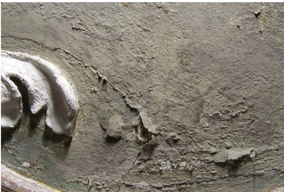
Obr. 49 Detail výjevu K9 v oblasti krajního pozadí v razantním bočním nasvícení. Stav před restaurováním. Na snímku je parná obvodová prasklina a okolní ztráta adheze barevného souvrství přemaleb, které se ve formě šupin odlupuje od sádrového podkladu.
