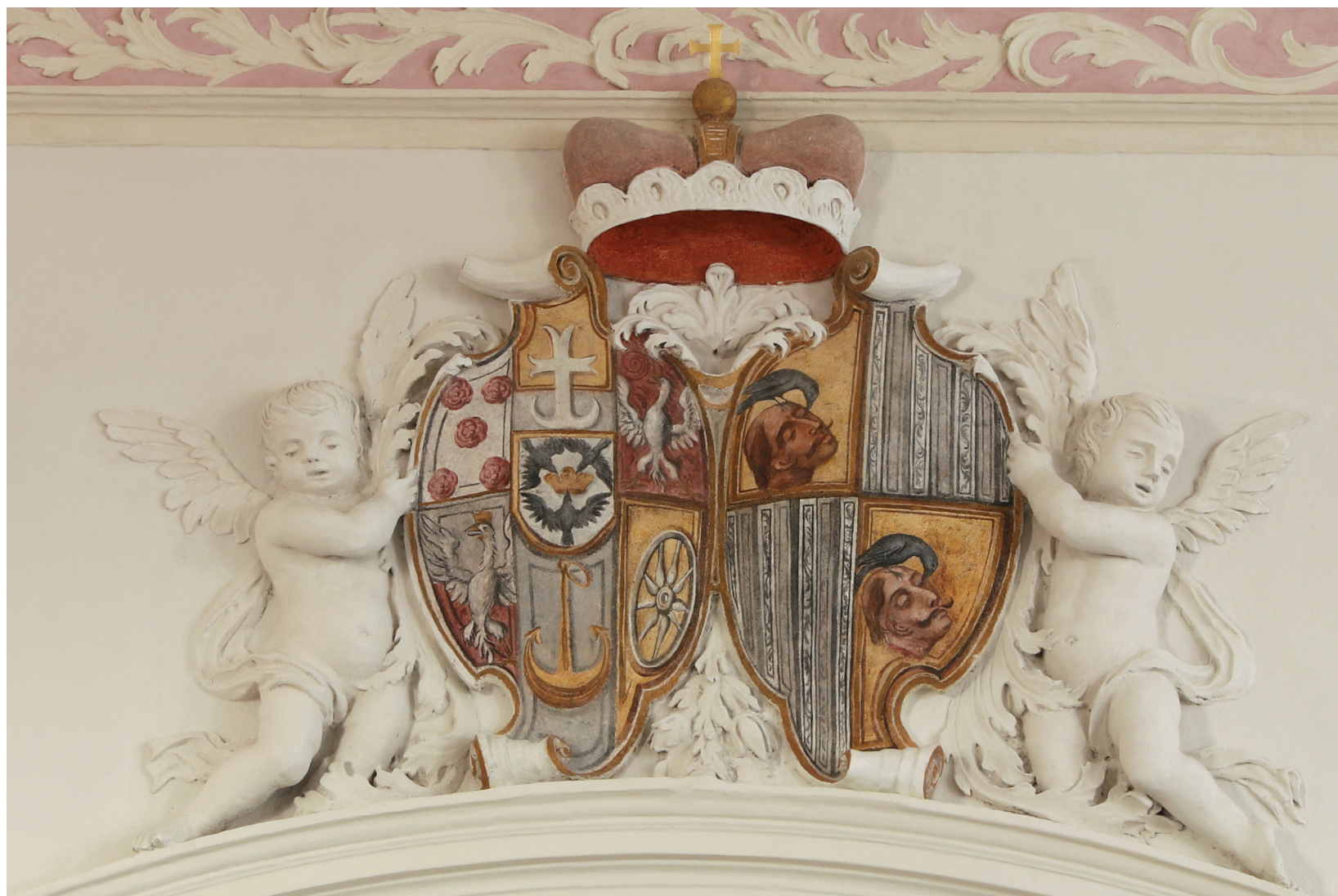
Obr. 124 Celkový pohled na alianční eggenbrsko-schwarzenberský znak nad vstupem do kaple sv. Václava. Stav po restaurování.
