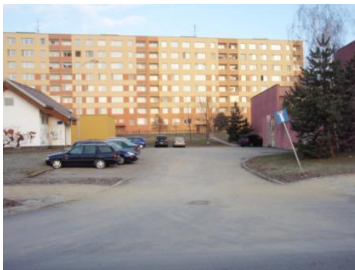
Obrázek 17: Asfaltová plocha u bývalé teplárny
