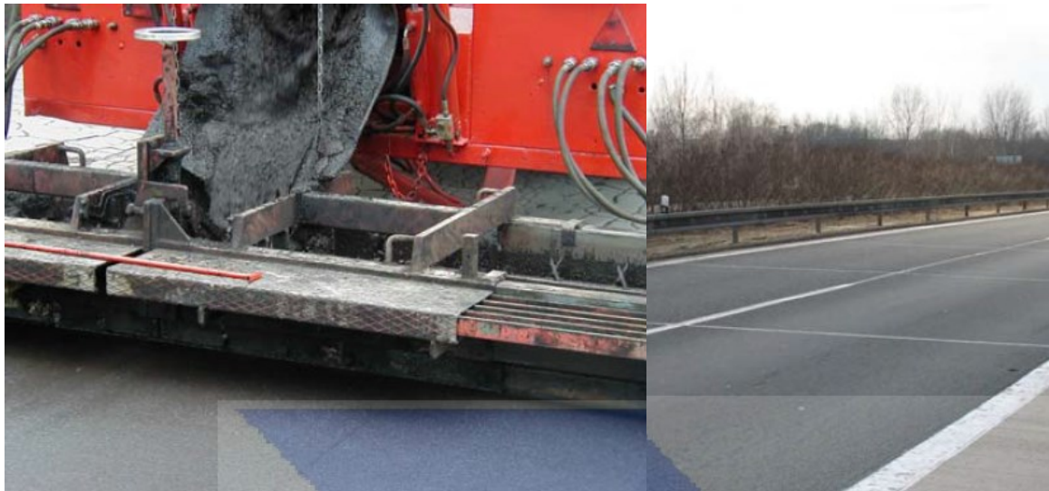
Obr. 12 Obnova protismykových vlastností pomocí emulzního mikrokoberce [64]
