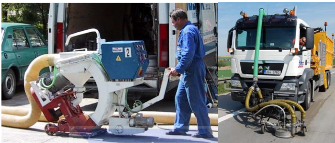
Obr. 10 Vlevo tryskání kovových částic, vpravo tryskání vodou [64]
