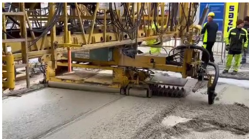
Obr. 8 Pokládka čerstvého betonu do pevných bočnic na ulici Sladkovského v Pardubicích
