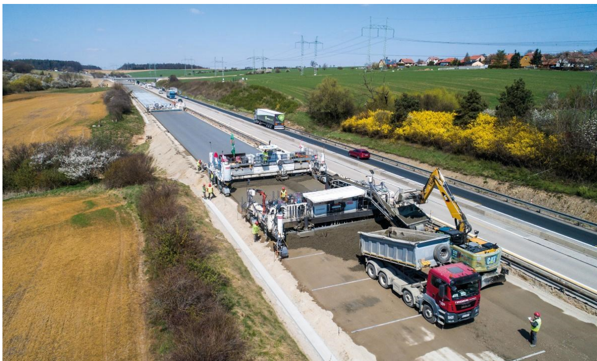
Obr. 9 Pokládka cementobetonového krytu [25]
