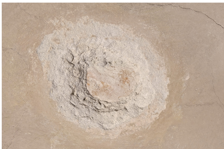
Obr. 95: Snímek zobrazující oblast po odstranění druhotného tmelu. Průběh restaurování.
