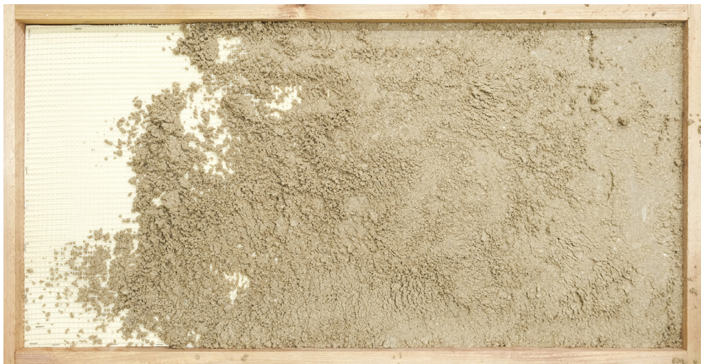
Obr. 10: Průběh hrubého omítání - nahazování vrstvy arriccio .
