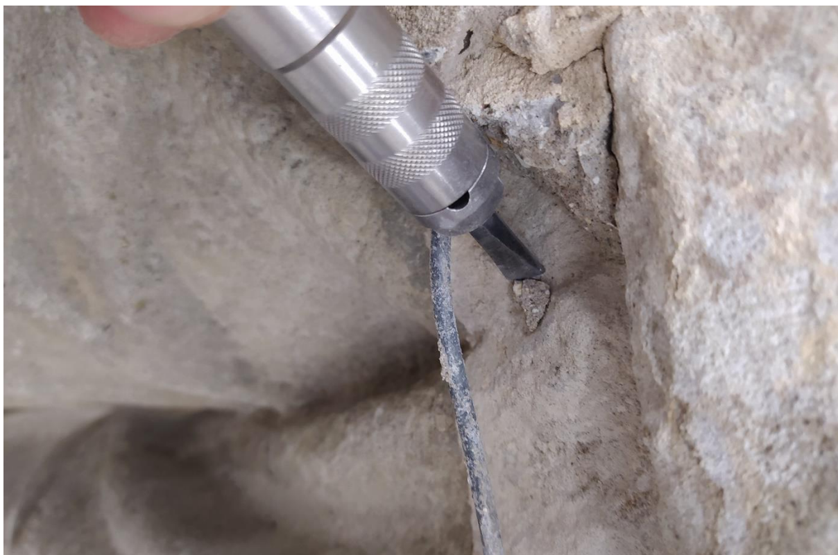
obr. 44 Odstraňování tmelu suknice 1.
