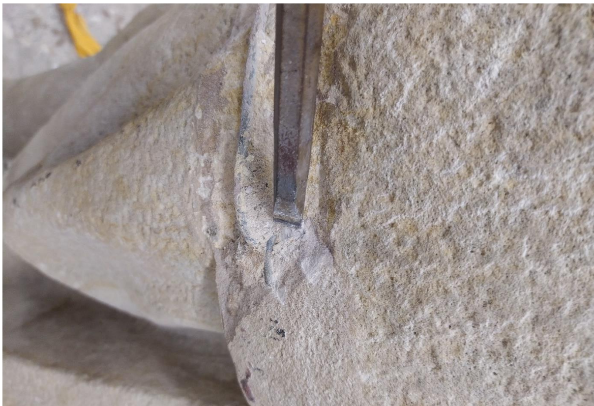
obr. 45 Odstraňování tmelu suknice 2.
