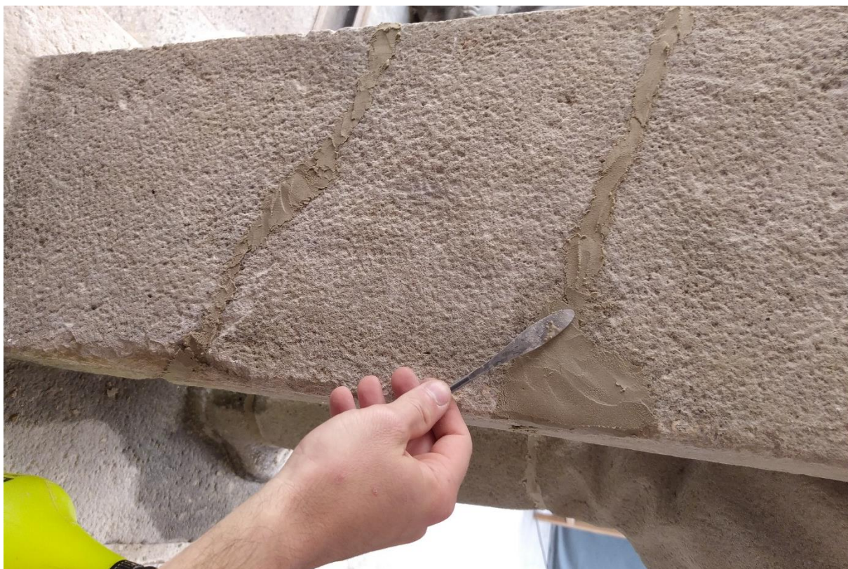
obr. 57 Plastická retuše lomové plochy hranolové podpory.
