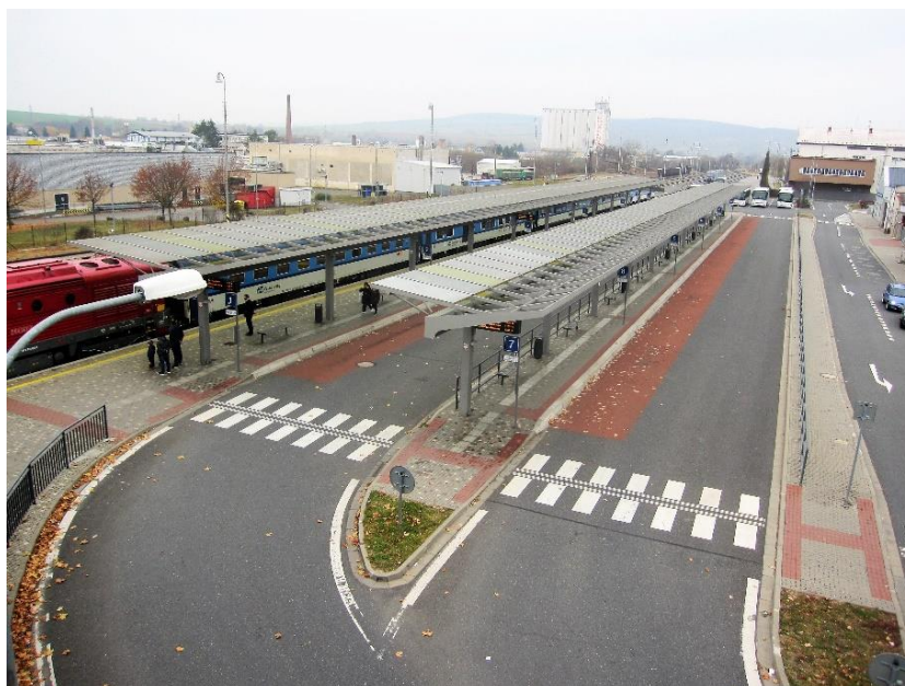
Obr. 1-3 Uherský Brod, pohled z lávky na přístup k nástupišťm
