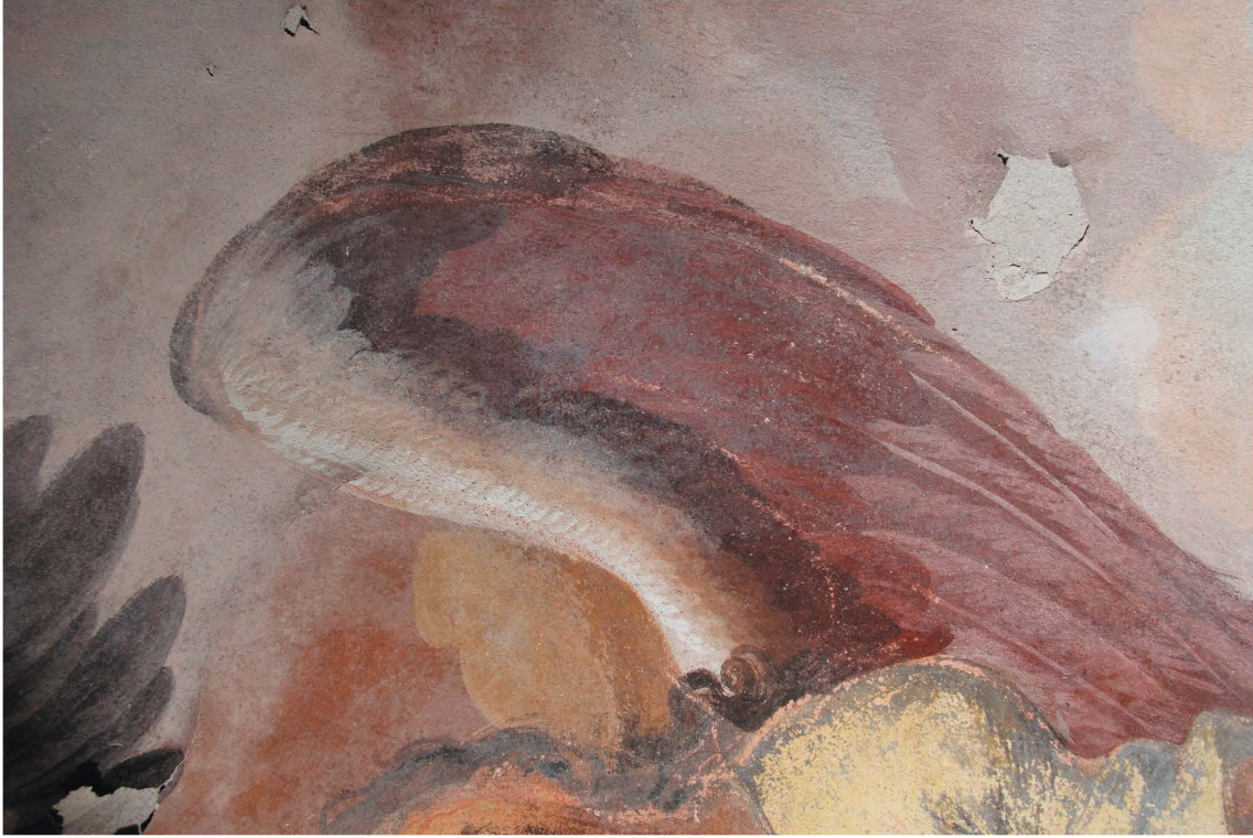
Obr. 47: Silně poškozená (zprášená a zpuchňovatělá) malba v oblasti postavy anděla vpravo (jizně) od Panny Marie.
