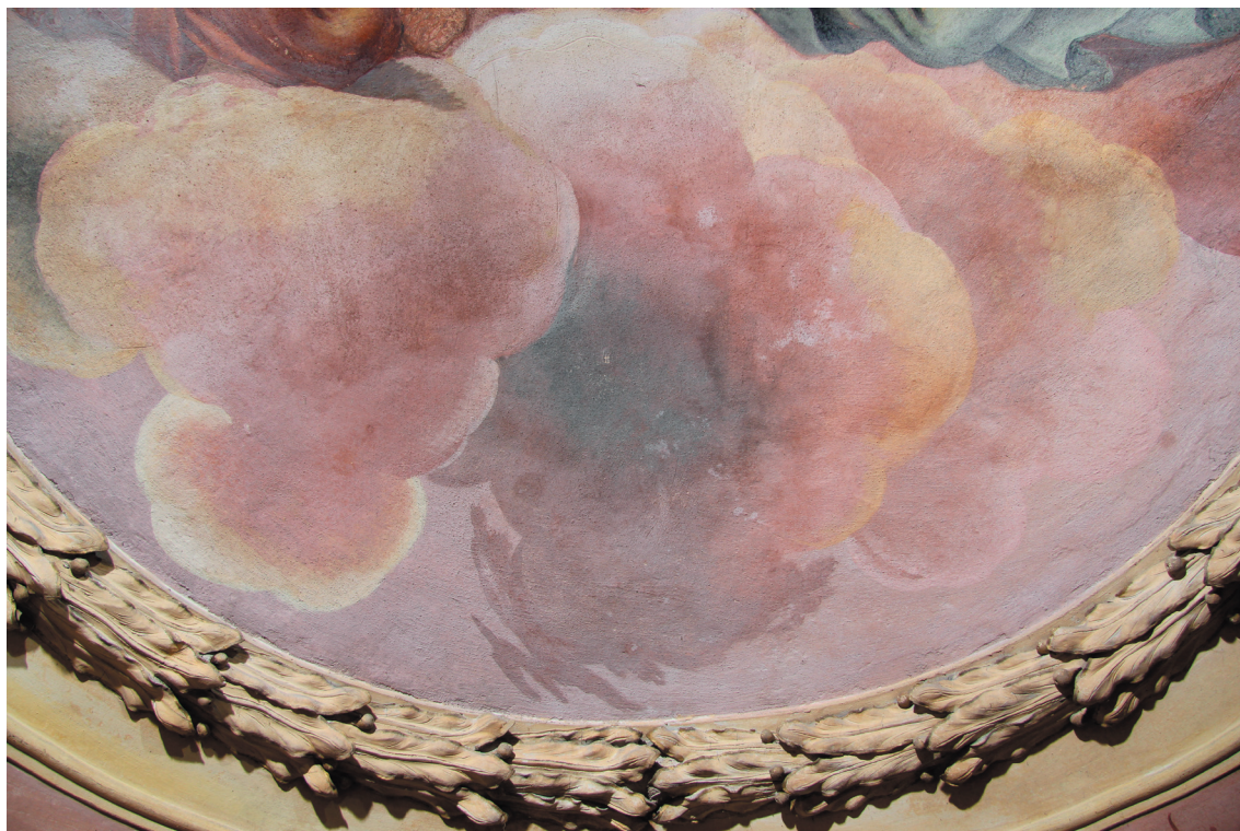
Obr. 30: Spodní partie výjevu Nanebevzetí Panny Marie v centrálním zrcadle. Barevná vrstva je práškovatělá.
