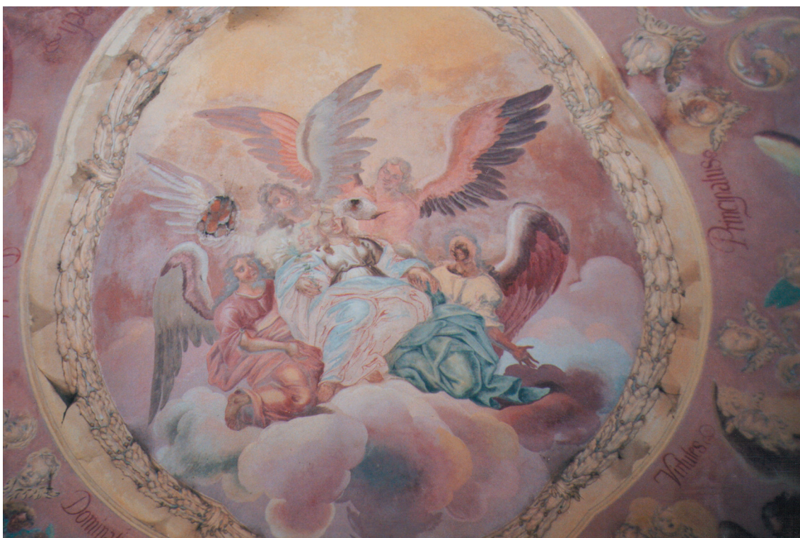
Obr. 51: Fotografie ze soukromého archivu Miroslavy Sejnohové z r. 2004. Rozsah poškození nebyl zdaleka tak veliký, jako je dnes.
