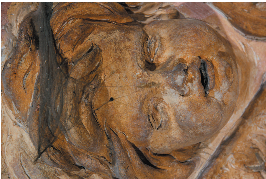
Obr. 56-58: Detaily obličejů okřídlené hlavy andělů umístěné těsně pod větracím otvorem v kupoli kaple. Barevná vrstva je v tomto místě silně namáhána, poškozování této plastiky je vyšší než u ostatních andělských hlaviček. Barevná vrstva je zprášena a zpuchýřovatělá, lokálně zcela chybí.
