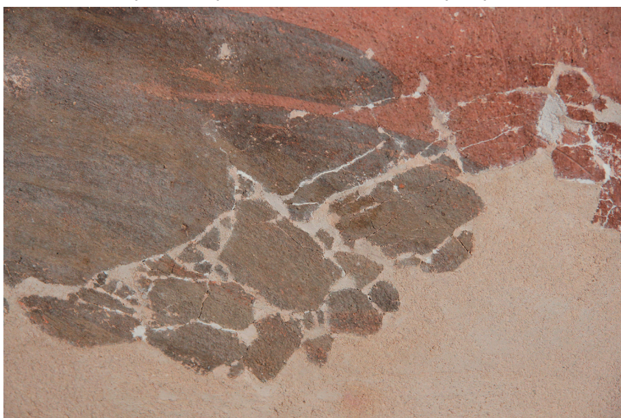
Obr. 82: Detail tmelů. Oblast s navrácenými transfery anebo kousky barevné vrstvy nalezenými na lešení ještě před restaurováním.
