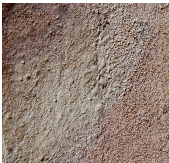
Obr. 15: Barevná vrstva před konsolidací.
