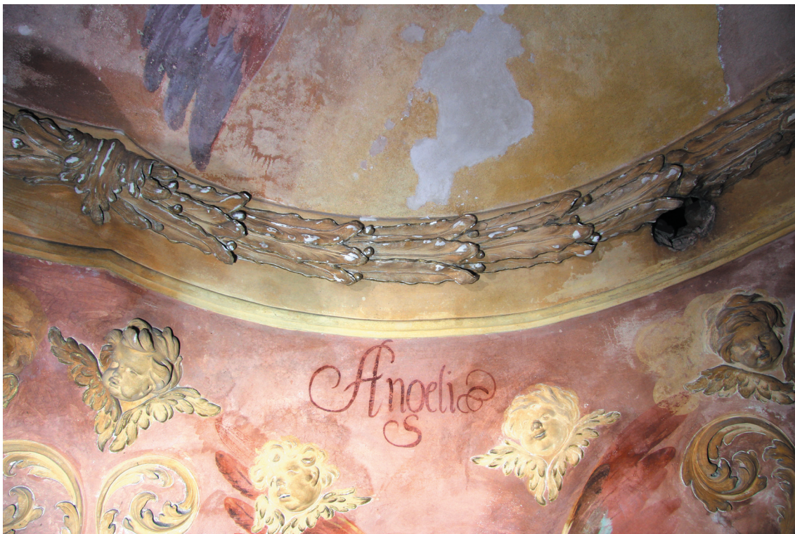
Obr. 83: Západní část štukového rámu po vytmelení defektů v oblasti vavřínových lístků.
