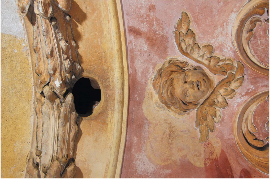
Obr. 86: Polychromovaná štuková výzdoba (okřídlená andělská hlavička a levá část štukového rámu s větracím otvorem) po restaurování.
