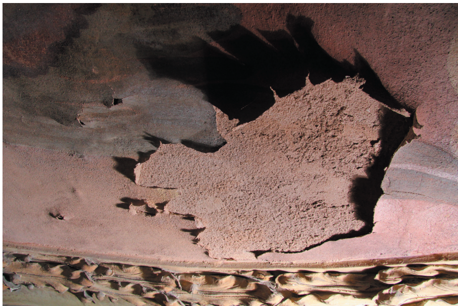
Obr. 74: Stav malby před konzervací. V defektu malby je patrný růžový odstín omítky.
