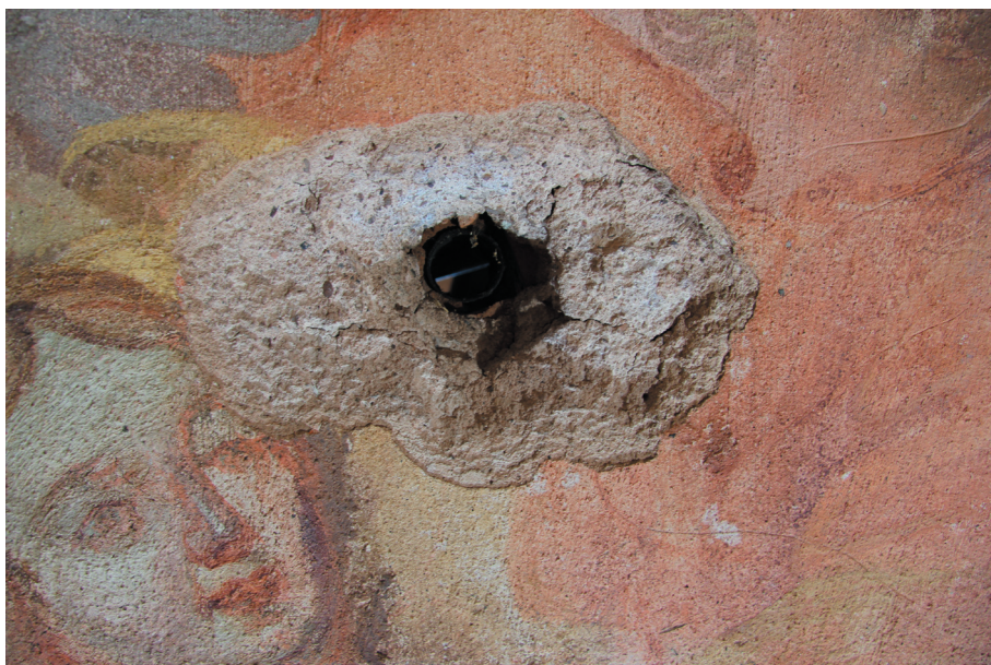
Obr. 69: Malba po odstranění přelepů a očištění.
