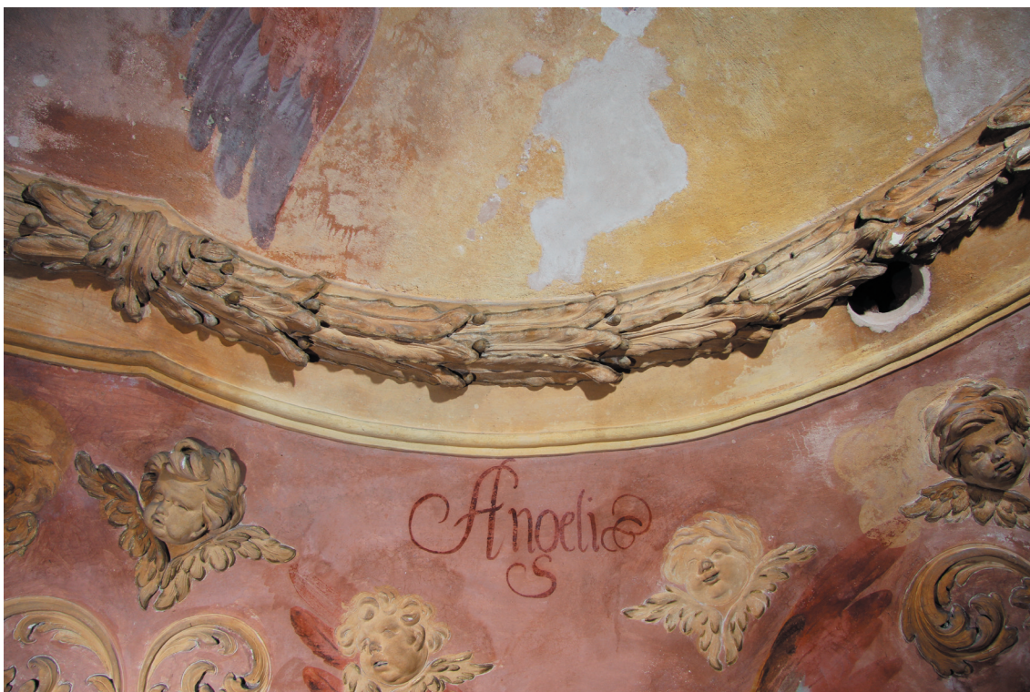
Obr. 84: Západní část štukového rámu po úpravě větracího otvoru a po vyretušování tmelů v oblasti vavřínových lístků.
