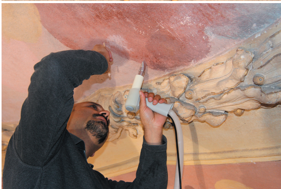
Obr. 65-66: Průběh čištění nástěnné malby pomocí mokré cesty. Na obr. 65 vatové tyčinky s povrchovými nečistotami. Obr. 66 - čištění párovým skalpelem.
