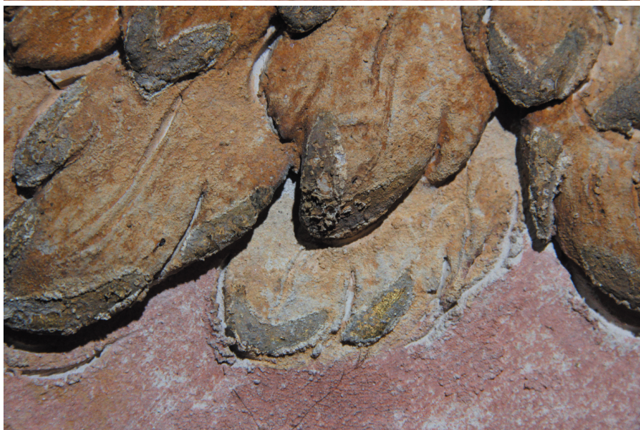
Obr. 59-60: Detaily okřídlené hlavy andílka umístěné těsně pod větracím otvorem v kupoli kapele. Zlacení a okrová vrstva jsou degradovány.
