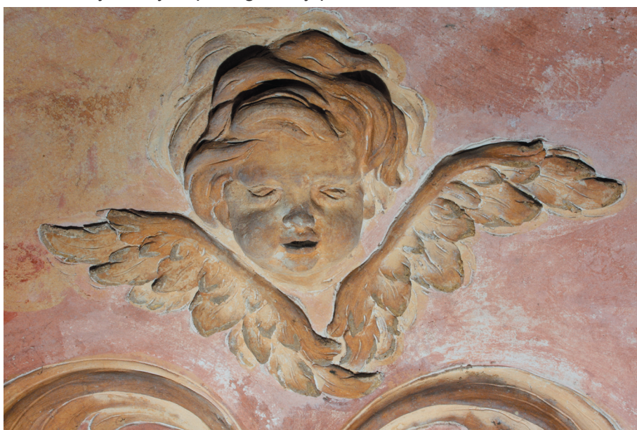
Obr. 64: Okřídlená hlava anděla v blízkosti větracího otvoru po očištění.
