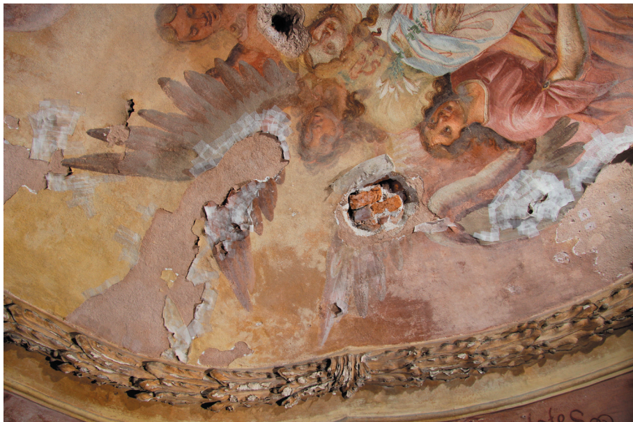
Obr. 77: Stav malby v průběhu konsolidace. Malba je lokálně zpevněná přely z japonského papíru.
