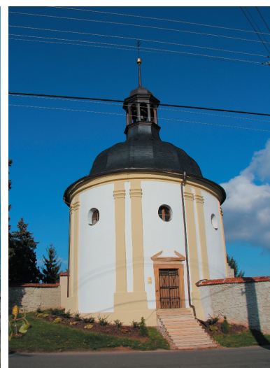
Obr. 24-26: Změny vnějšího pláště kaple sv. Isidora v Křenově během 20. a 21. století. Z obr. 24 je patrné, že původně byl vnější plášť členěn ještě jednou římsou probíhající v oblasti hlavic pilastrů.
