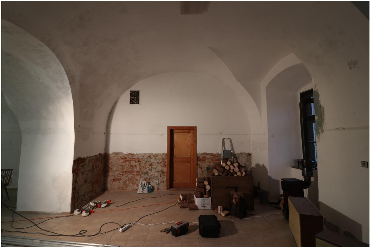
Obr. 45 Společenský sál, západní část, pohled jižním směrem.
