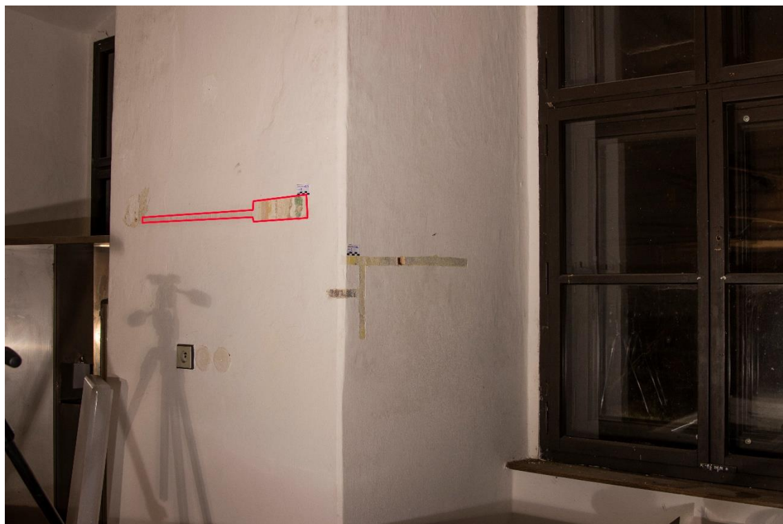
Obr. 2 Sonda 1, celkový pohled
