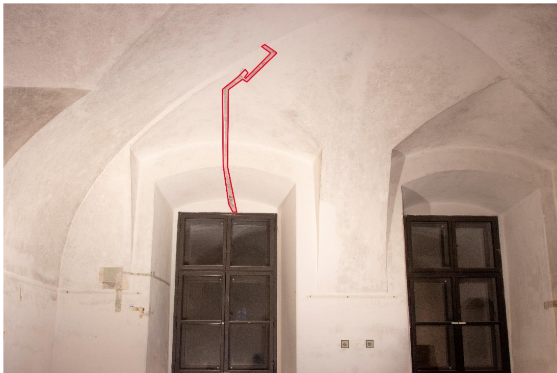
Obr. 11 Sonda 5, celkový pohled
