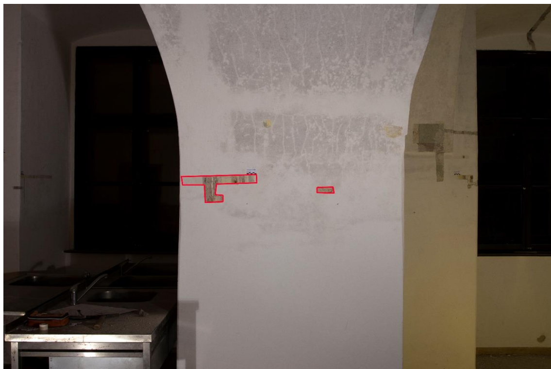
Obr. 6 Sonda 3, celkový pohled
