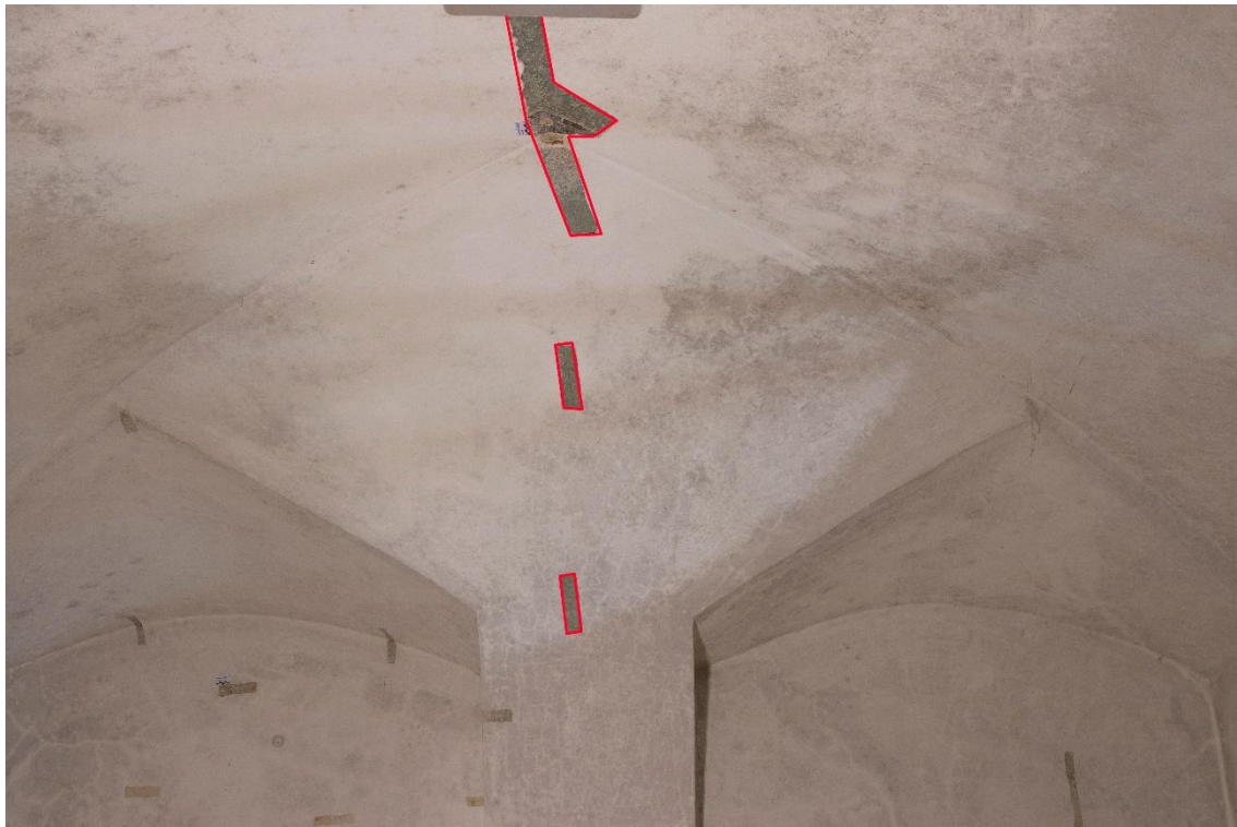
Obr. 16 Sonda 8, celkový pohled (a)
