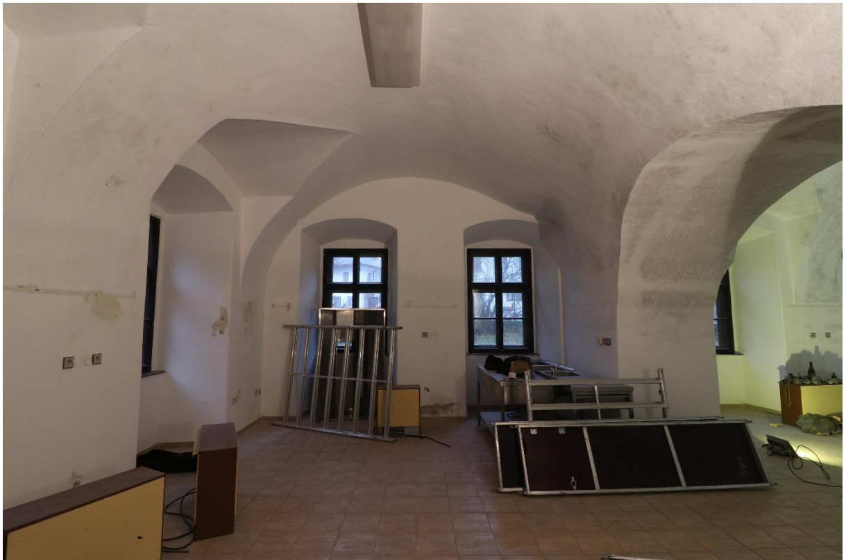
Obr. 46 Společenský sál, západní část, pohled severním směrem.
