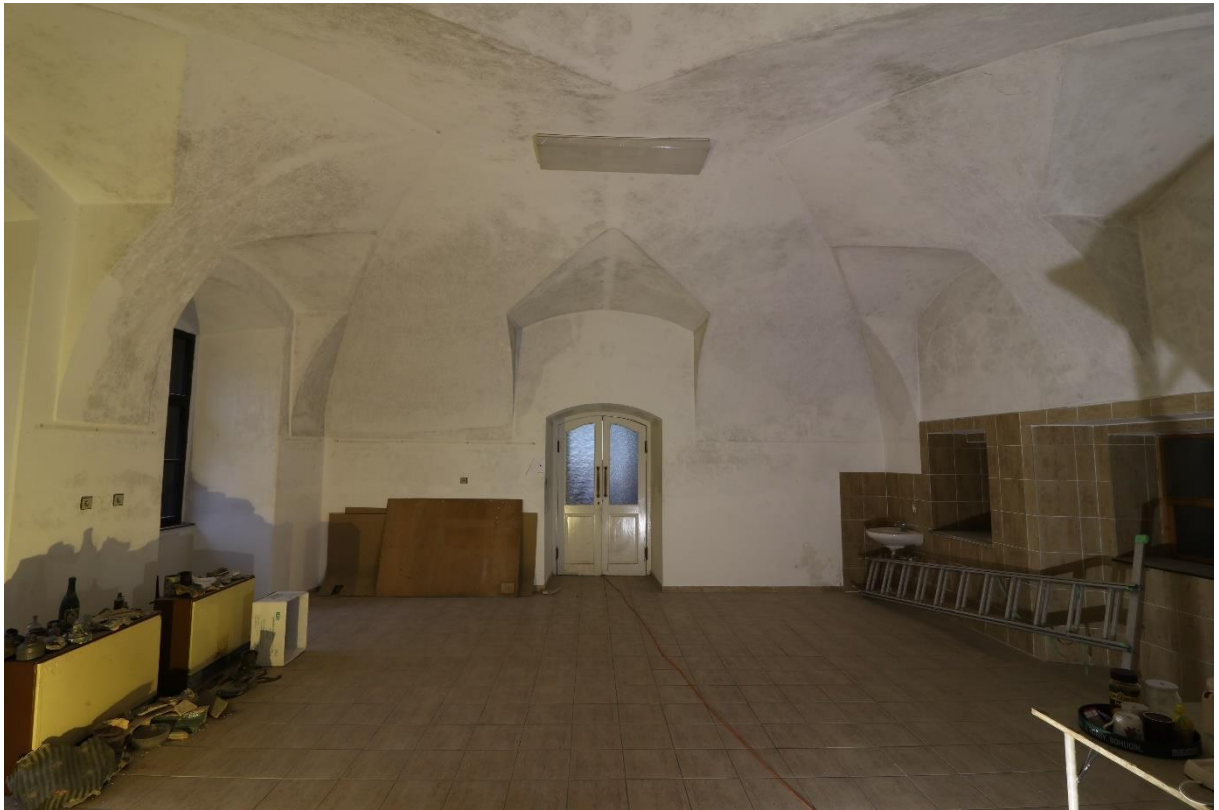
Obr. 41 Společenský sál, východní část, pohled východním směrem.
