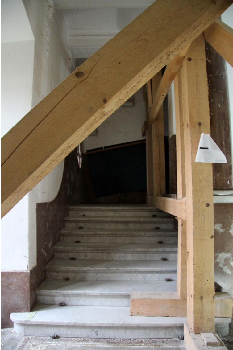
Obr. 48 Schodišťová hala, Pohled na schodiště VJ
