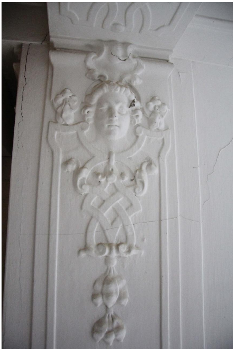
Obr. 53 Schodišťová hala, Detail štukového maskaronu s páskovým dekorem
