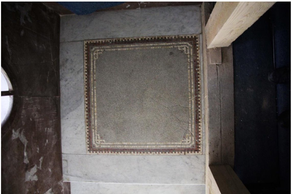
Obr. 52 Schodišťová hala, podlaha, mezipatro schodiště VJ
