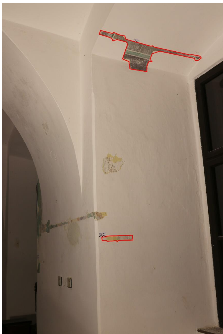
Obr. 33 Sonda 13, celkový pohled
