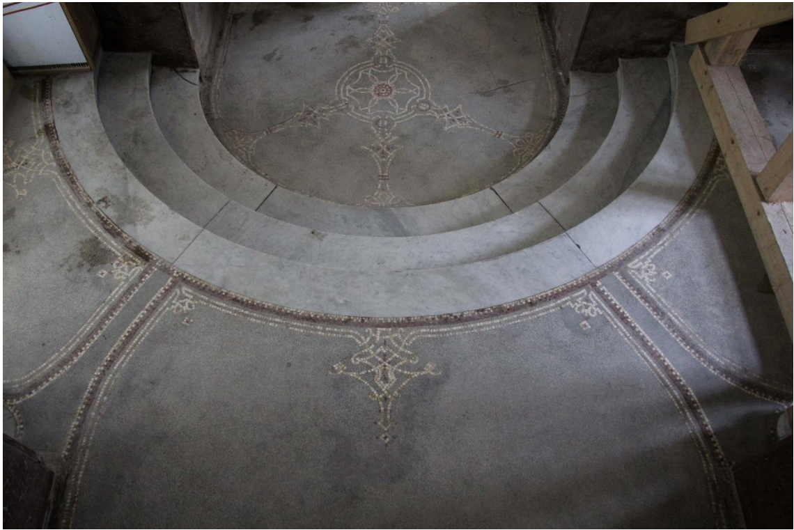
Obr. 51 Schodišťová hala, podlaha, vstup
