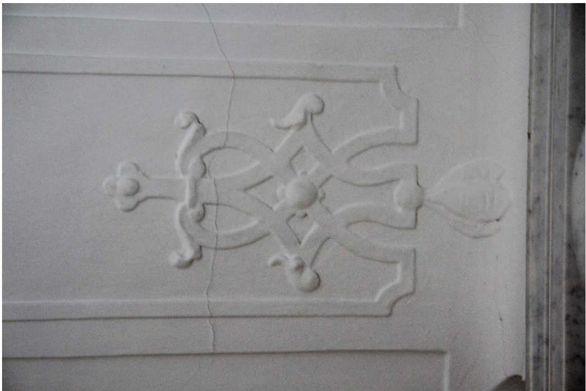
Obr. 55 Schodišťová hala, detail štukového páskového štukového dekoru
