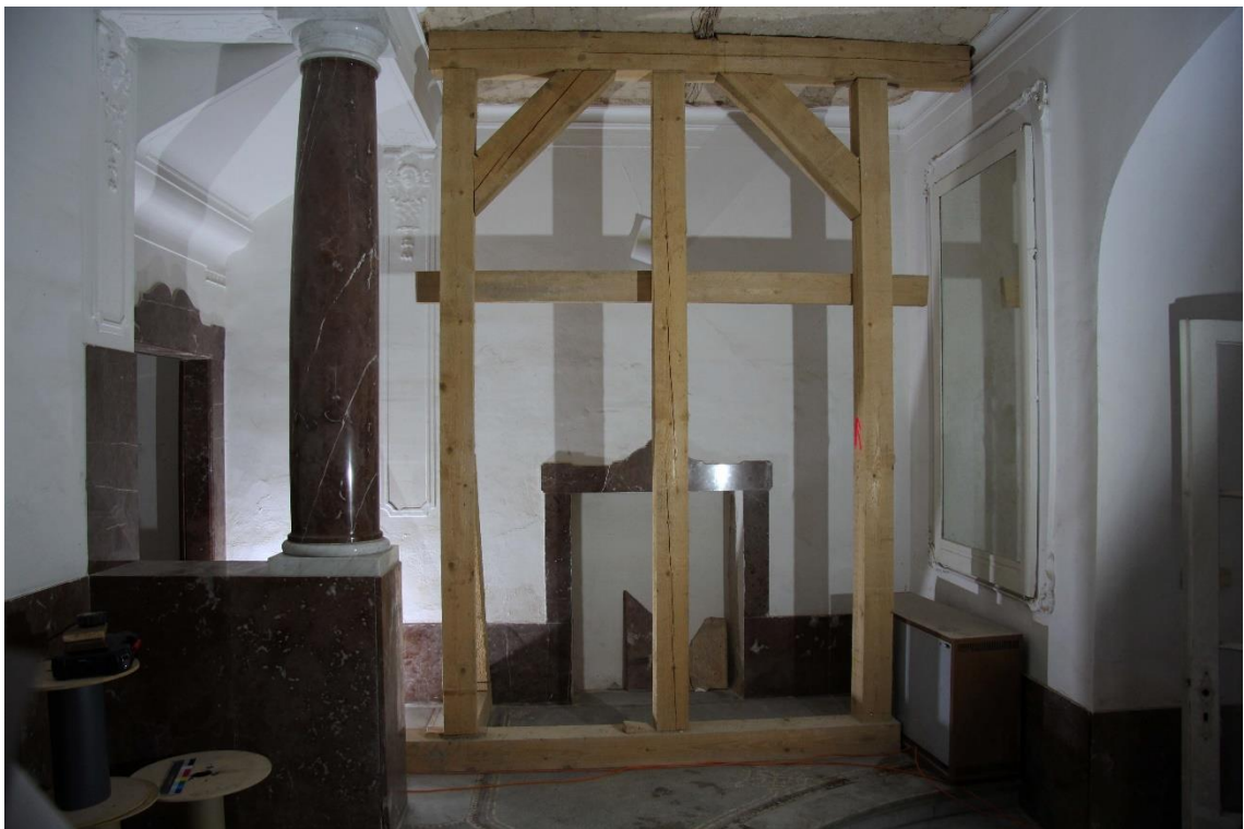
Obr. 50 Schodišťová hala, směr S
