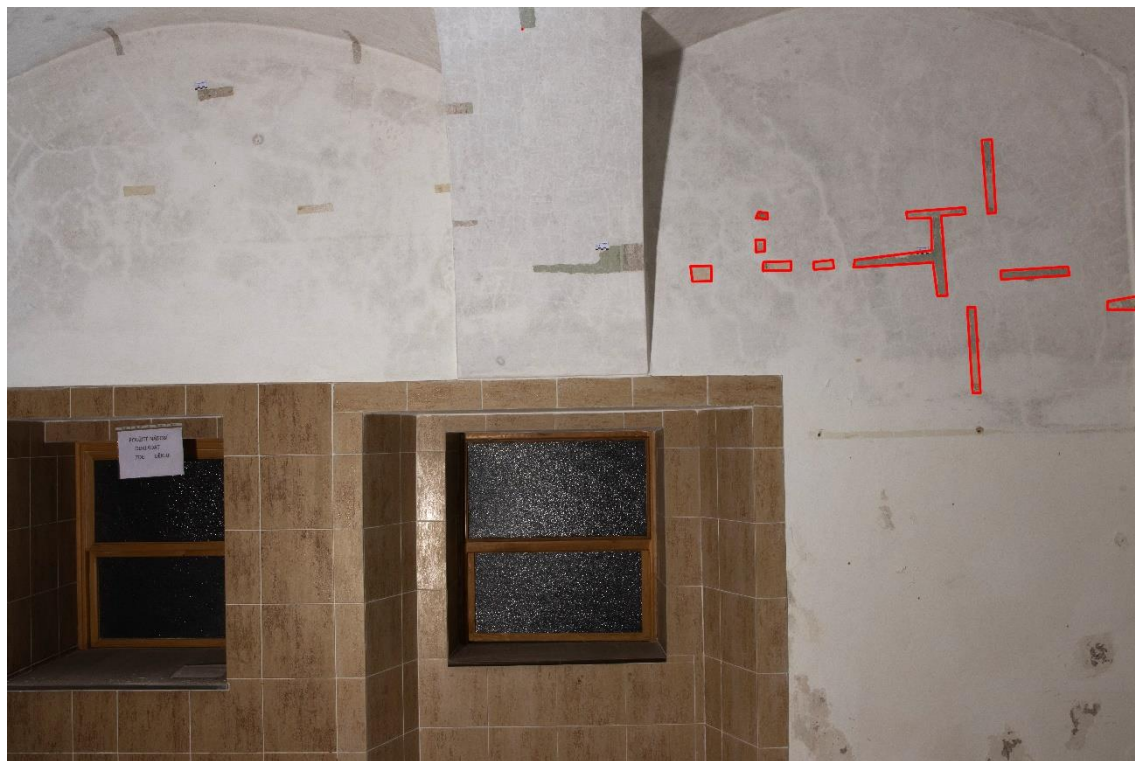
Obr. 20 Sonda 9, celkový pohled
