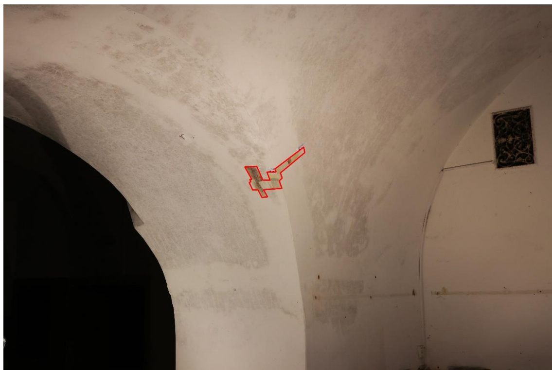
Obr. 23 Sonda 10, celkový pohled
