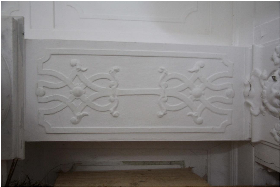
Obr. 54 Schodišťová hala, detail štukového páskového štukového dekoru
