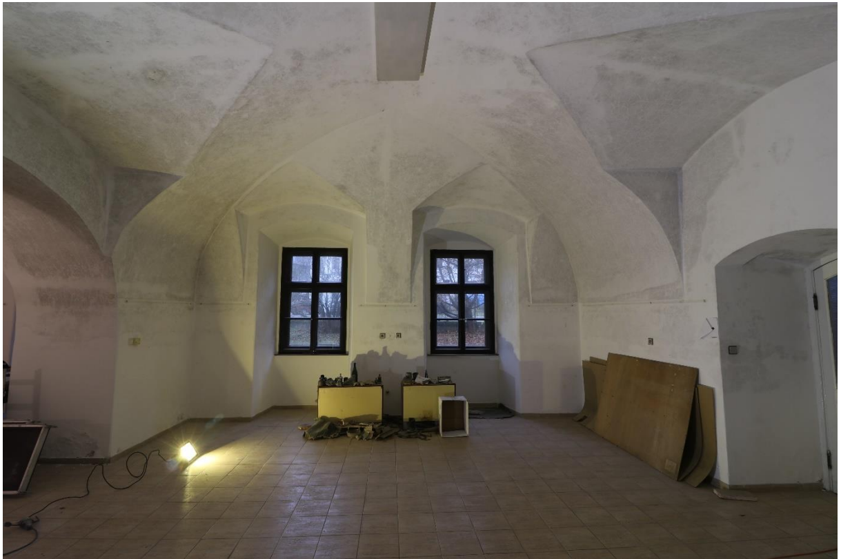
Obr. 43 Společenský sál, východní část, pohled severním směrem.
