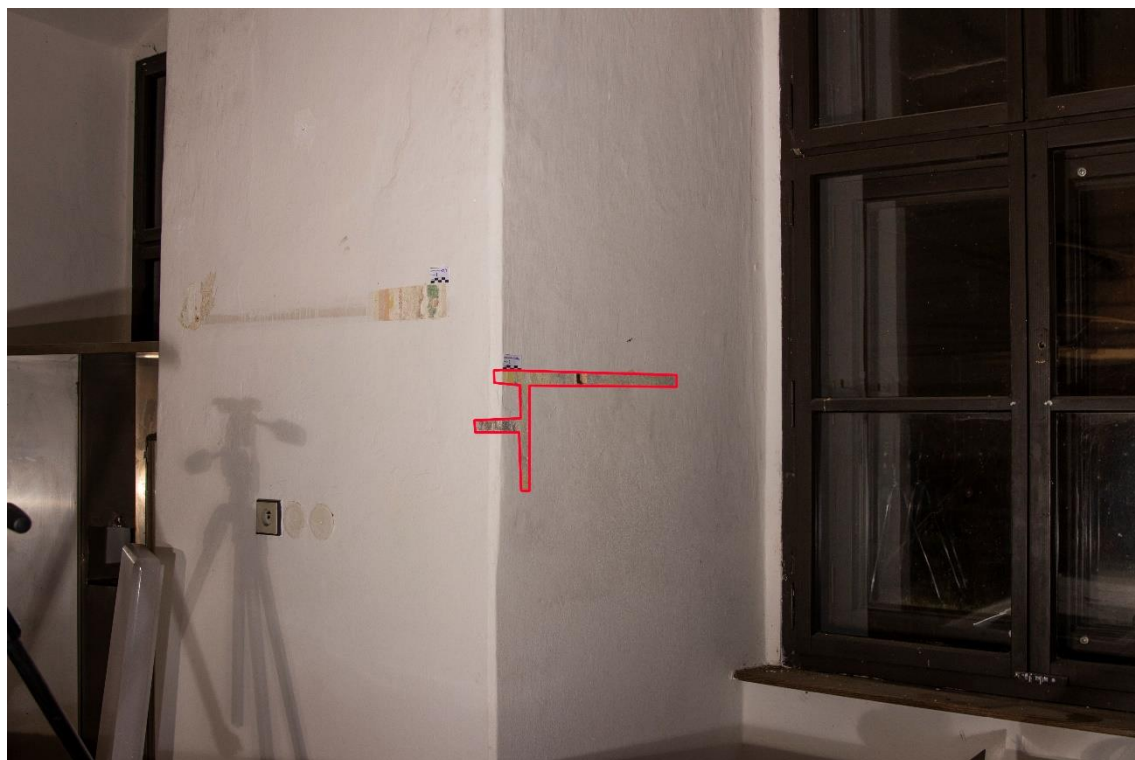
Obr. 4 Sonda 2, celkový pohled
