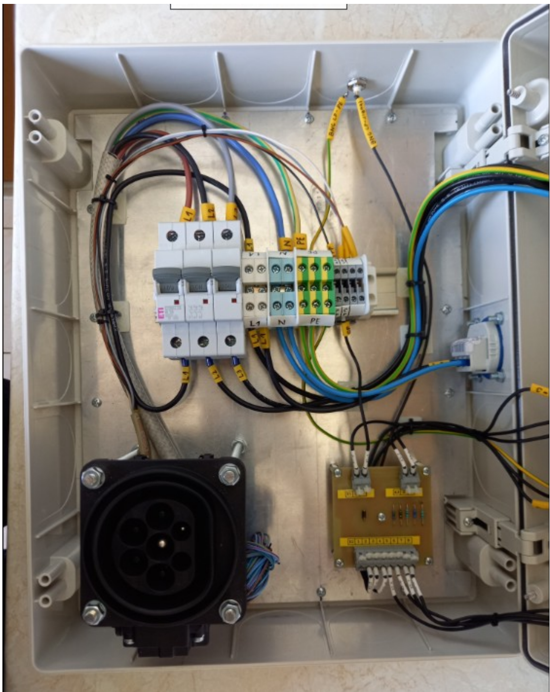
3.7 – Simulátor pro režim nabíjení 3C - pohled po otevření čelního víka
