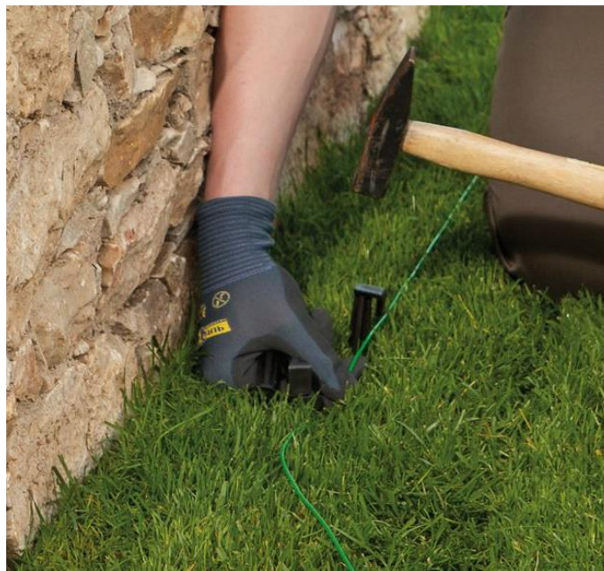
Obr. 1.15 – Instalace obvodového vodiče
