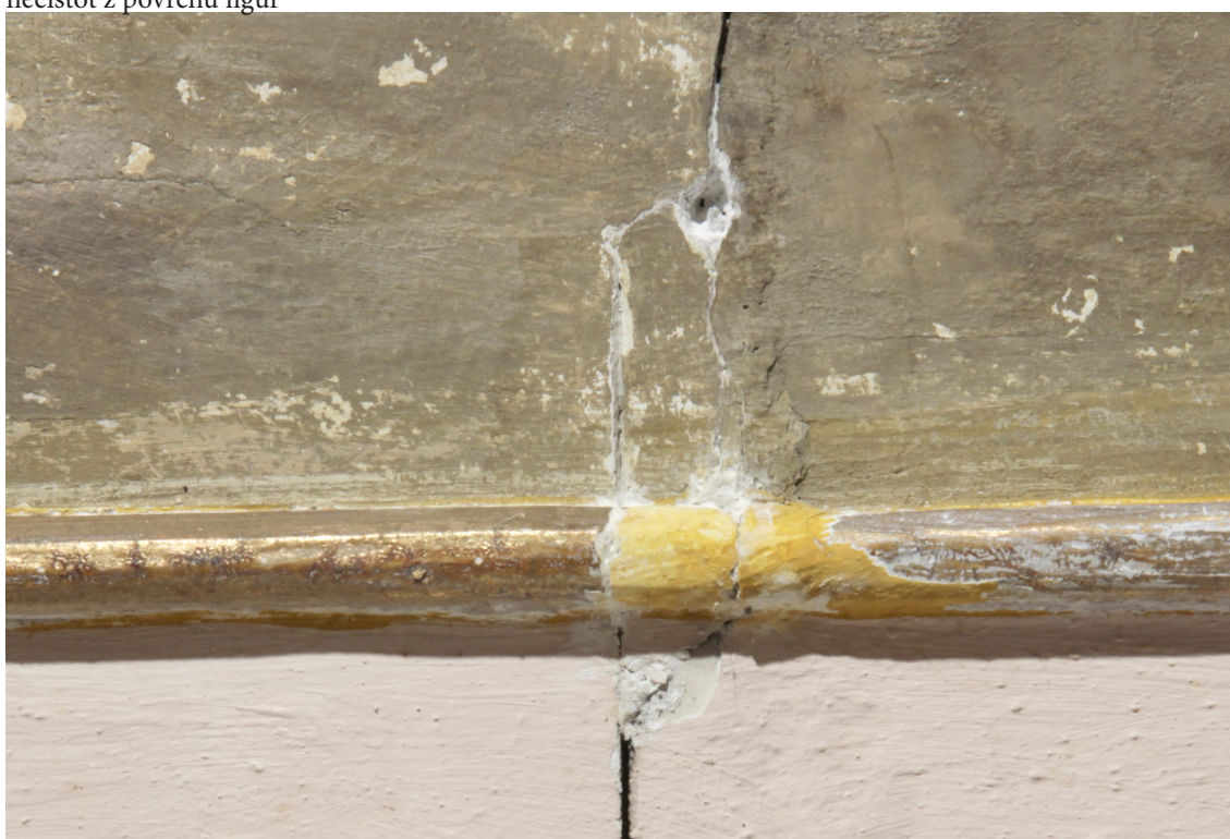
Obr. 50. Detail volně visícího fragmentu sádrového štku s barevnou vrstvou po proinjektování injektážní směsí a odstranění ochranného přelepu
