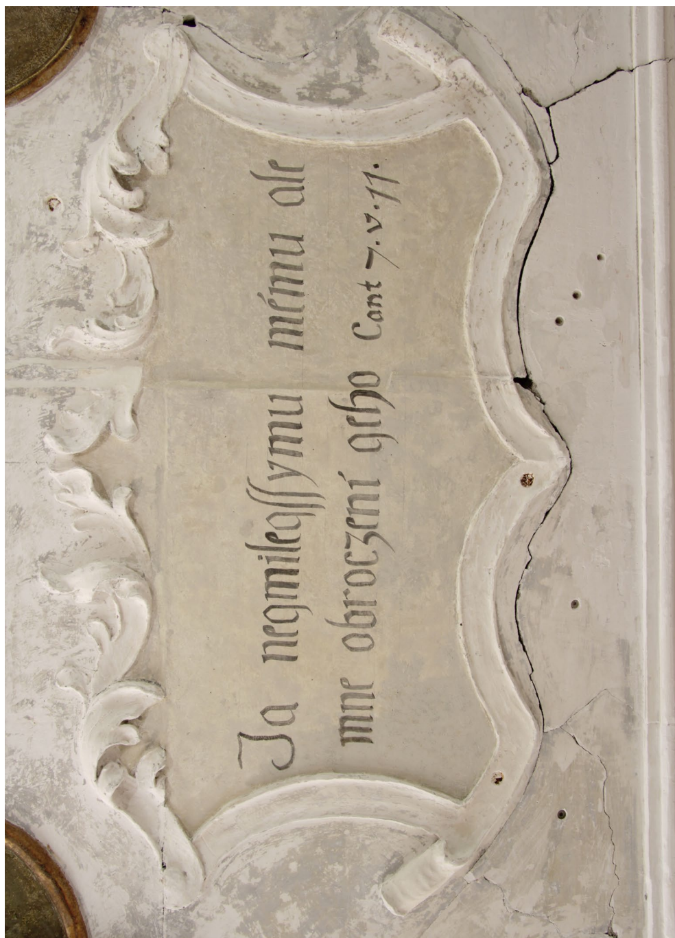
Obr. 60. Rekonstrukce nápisového pole, ztmavlé fragmenty starších vrstev byly barevně potlačeny
