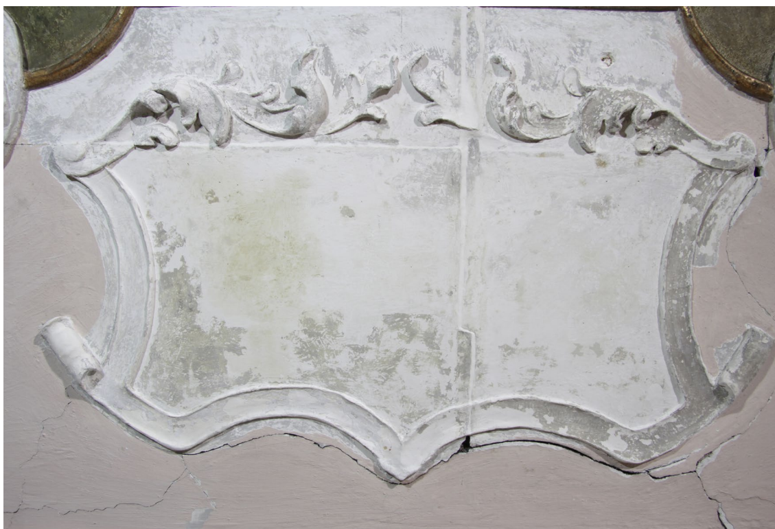
Obr. 54. Textové pole stav po sejmutí druhotné vrstvy a odhalení fragmentů starších vrstev; stav po vytmelené prasklin dělicích pole
