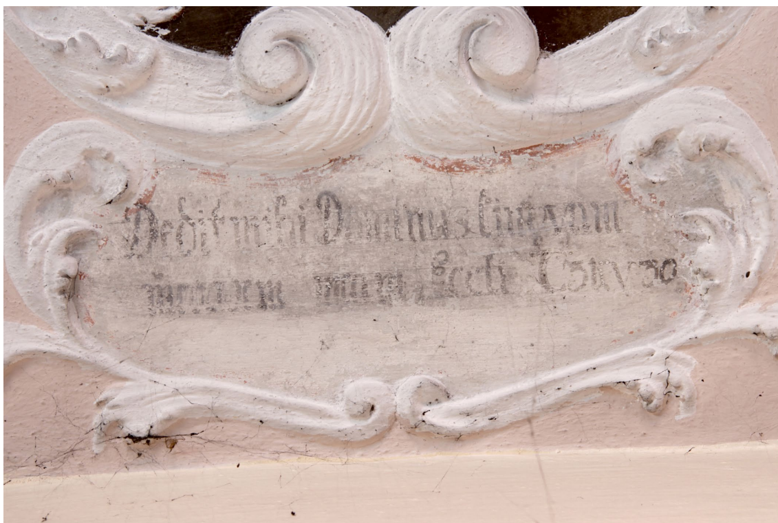
Obr. 68. Nápisové pole stav před restaurováním, text byl přes vrstvu nečistot velmi špatně čitelný, červená bordura je téměř celá překryta bílou vrstvou druhotného nátěru
