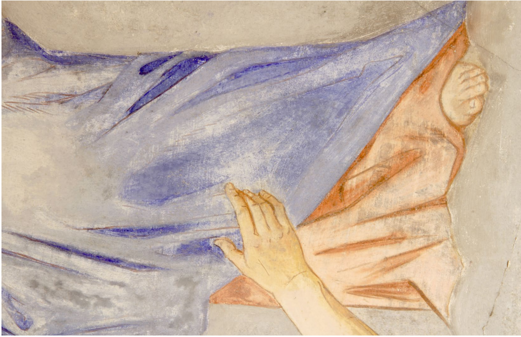
Obr. 15. Detail roucha Panny Marie na centrálním výjevu v kostele v Klokočech - na fotografii je patrná ztráta pastózních vrstev, které tvořily hmotu, malby jsou odhaleny až na červenou podkresbu a základní barevný rozvň hmot
