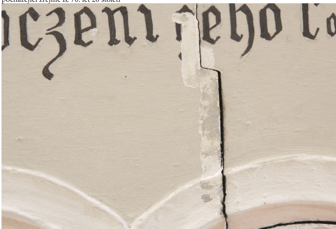
Obr. 48. Sonda provedená v textovém poli, v sondě jsou patrné fragmenty starších barevných vrstev, starší text se v sondě neobjevuje
