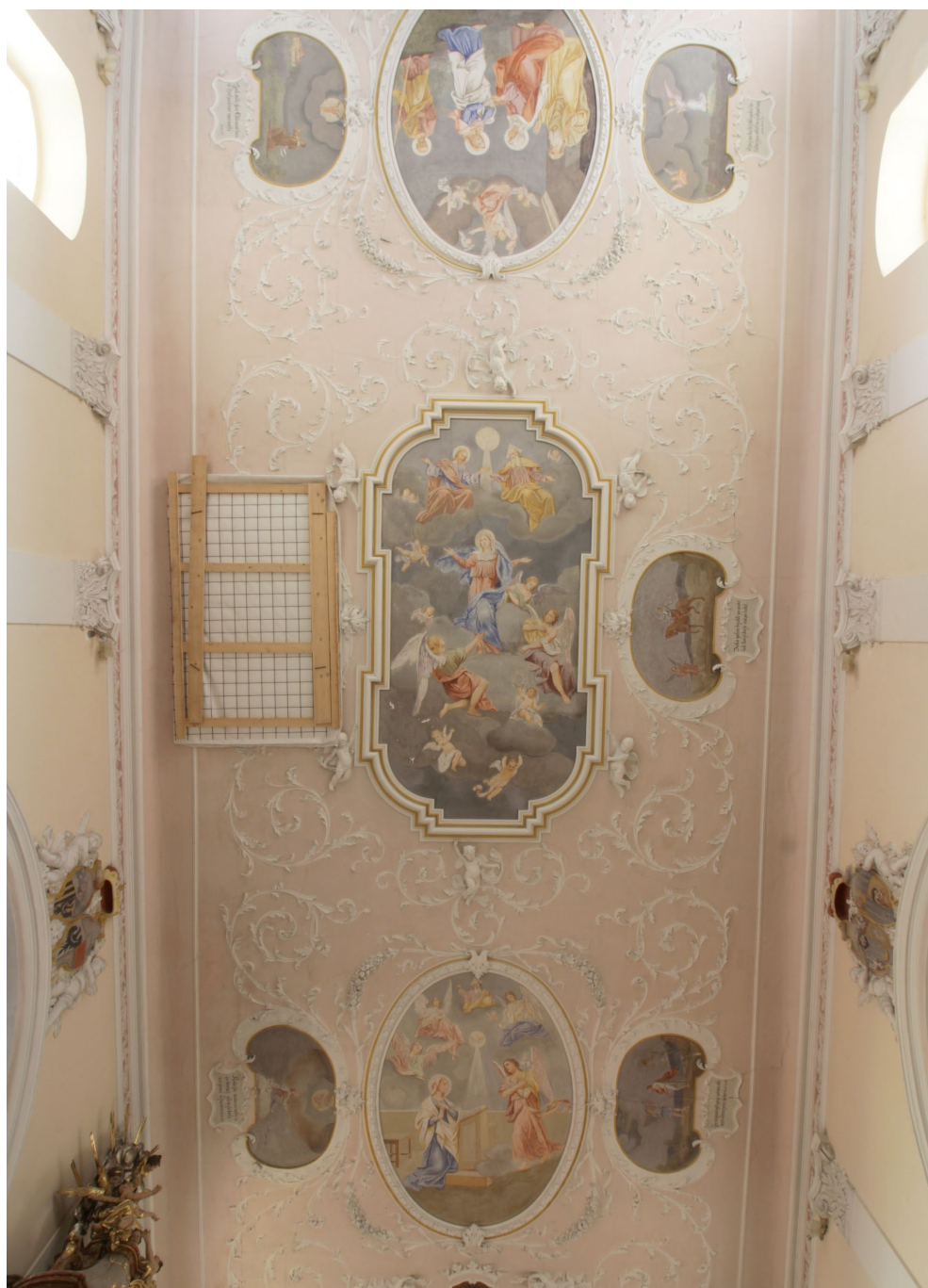
Obr. 31. Strop lodi kostela stav před restaurováním, oproti snímku Obr. 29. je patrné, že došlo k výraznému ztmavení pozadí maleb
