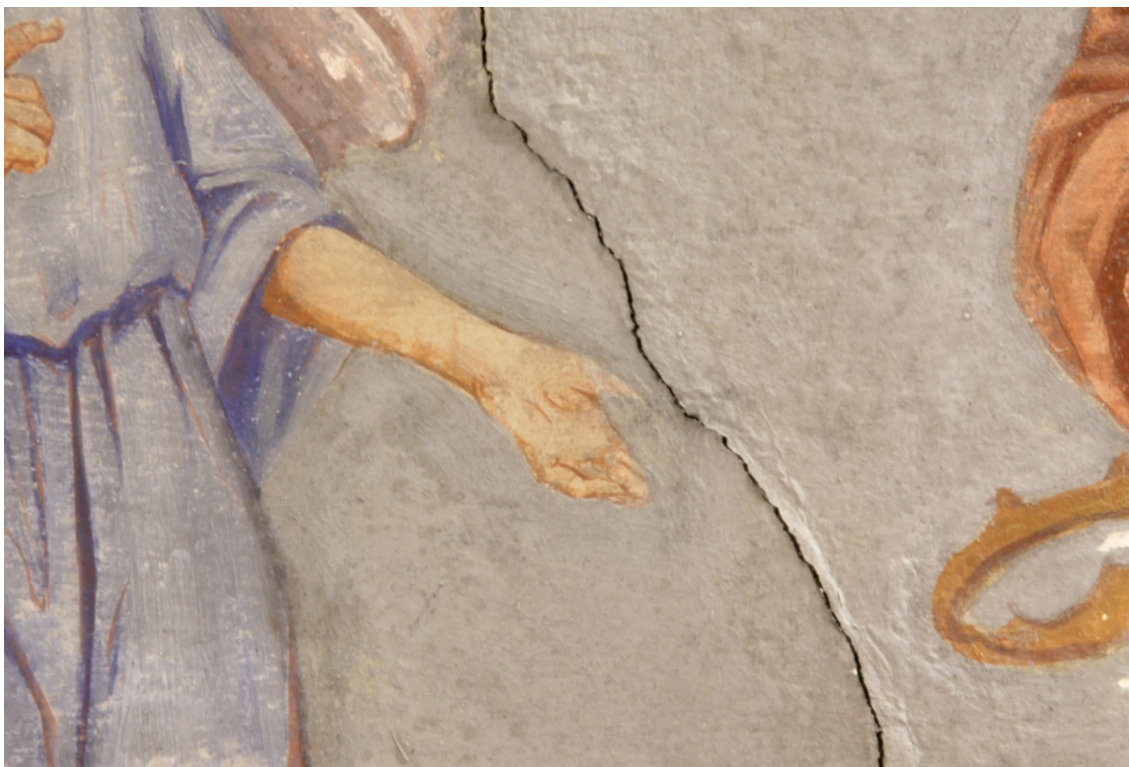
Obr. 42. Detail prasklina, která dělí výjev téměř v polovině; barevná vrstva v okolí praskliny vykazuje ztrátu adheze k povrchu podkladu, to se projevuje puchýřkovatěním povrchu malby; na ruce anděla jsou zjevné deformace vzniklé přetažením originální malby šedým pozadím
