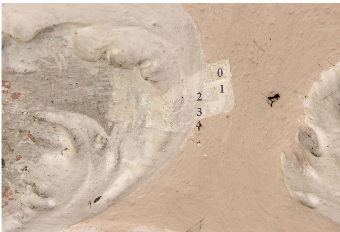
Obr. 73. Sonda provedená na přilehlé štukové výzdobě; 0 - štukový podklad má pískovou barvu, štuk pro modelaci prvků je v bílé bravnosti; 1 - světlá vrstva lomená do žluto-okrova; 2 - světle šedý nátěr provedený v tenké vrstvě; 3 - světlešedý nátěr v tenké vrstvě; 4 - úprava pocházející zřejmě ze 70. let 20. století, touto barevností byl pojednán dříve celý interér kostela
