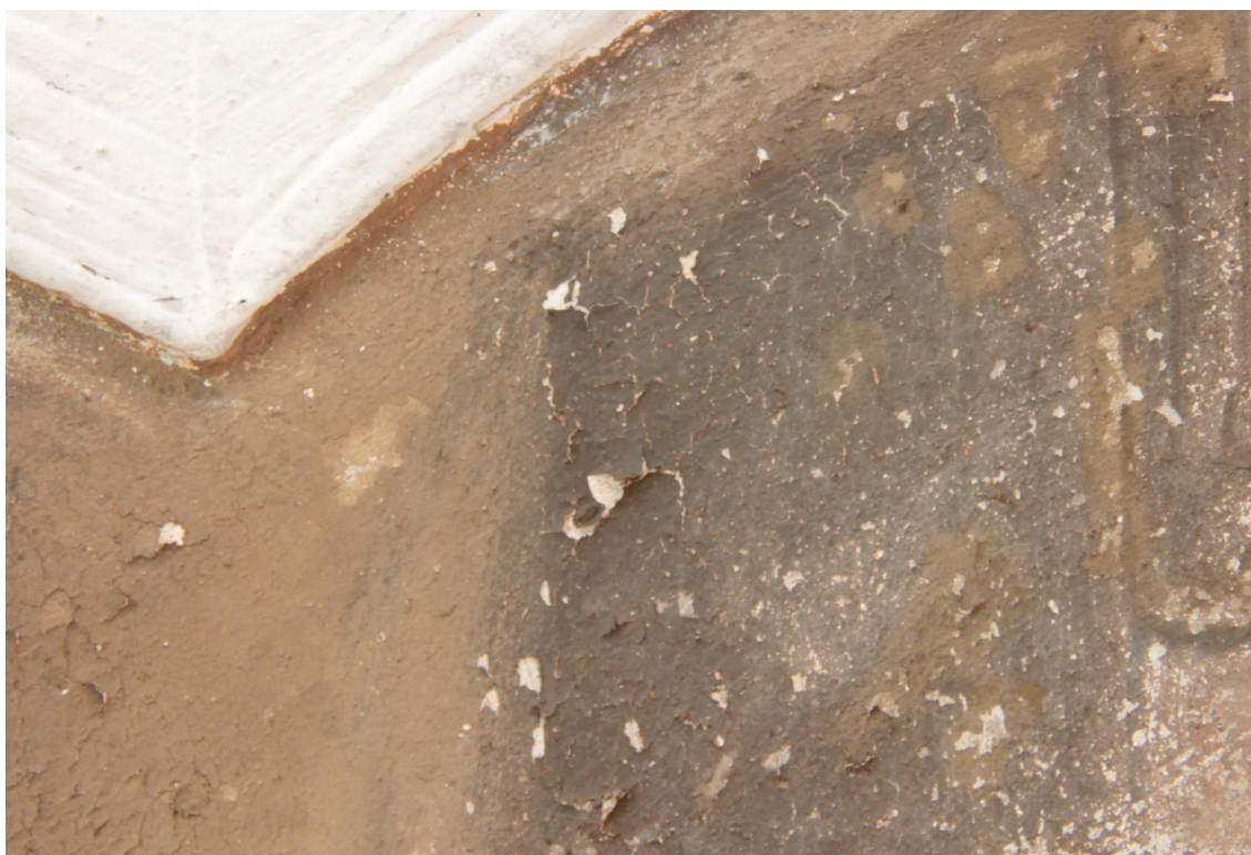
Obr. 70. Detail poškození barevné vrstvy - barevná vrstva se v šupinách odlupuje a hrozí tak její odpadení
