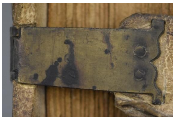
Obr. č. 14 Spona háčková s prierezovou záchytkou. Konce spony sa postupne rozvetvujú do tvaru písmená „T“, pričom riešenie podoby konca štítku a tela spony je totožné. Sign. II G β 5
