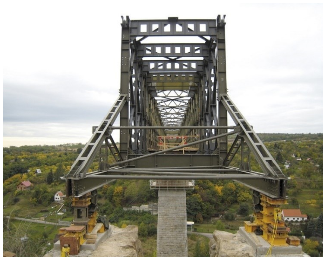
Obrázek 5 Výstavba náhradního železničního přemostění ŽM 16 M (Pokorný a Václavík, 2009)
