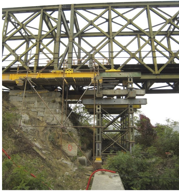
Obrázek 4 Výstavba náhradního železničního přemostění pilíř Pižmo (Pokorný a Václavík, 2009)
