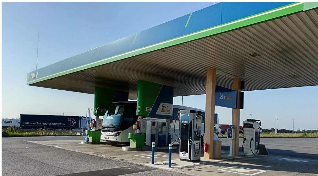
Obrázek 9: Průjezdné UFC DC dobíjecí stanic umístěné na čerpacích stanicích
