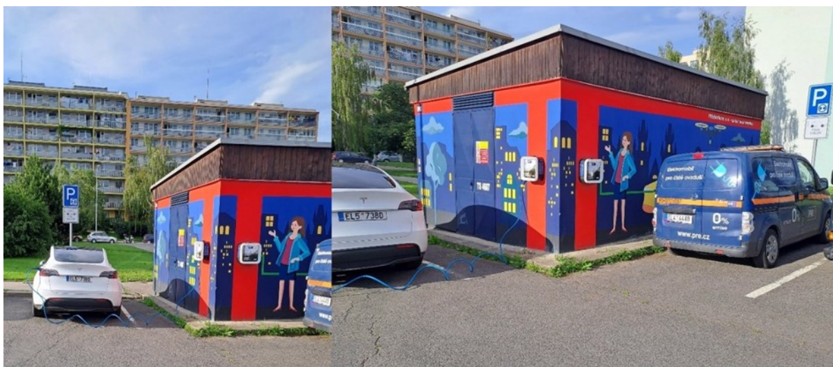
Obrázek 13: Wallboxy na trafostanicích pro dobíjení na sídlištích
