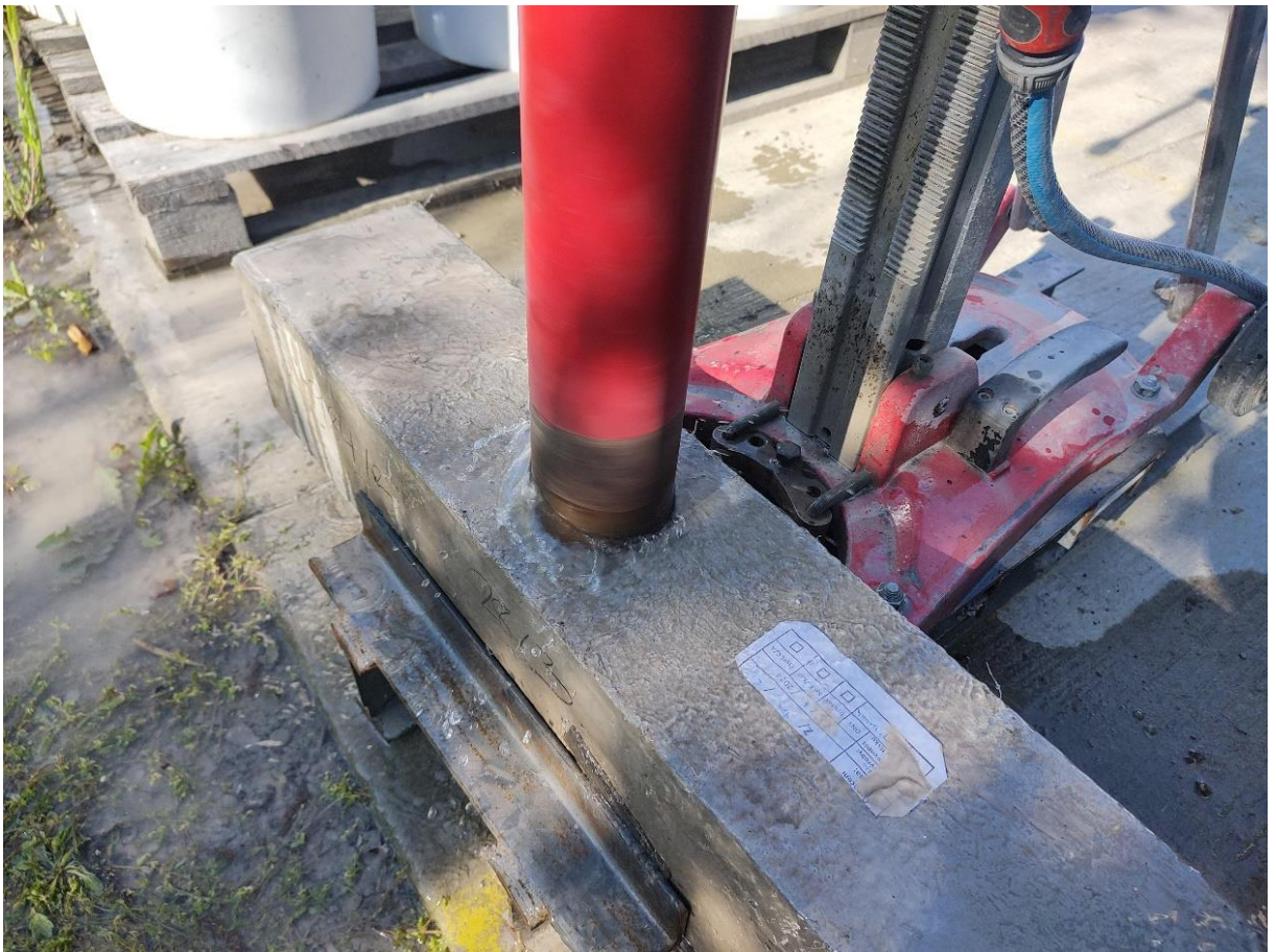
Obrázek 35 Úprava zkušebního tělesa – vývrt průměru 80 mm
