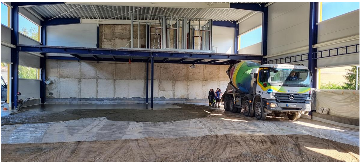
Obrázek 11 Betonování průmyslové podlahy [43]
