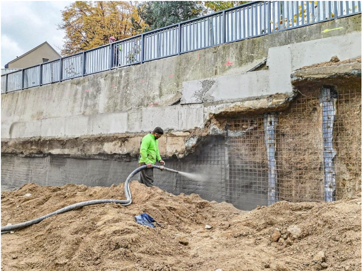
Obrázek 10 Torkretování opěrné stěny [42]
