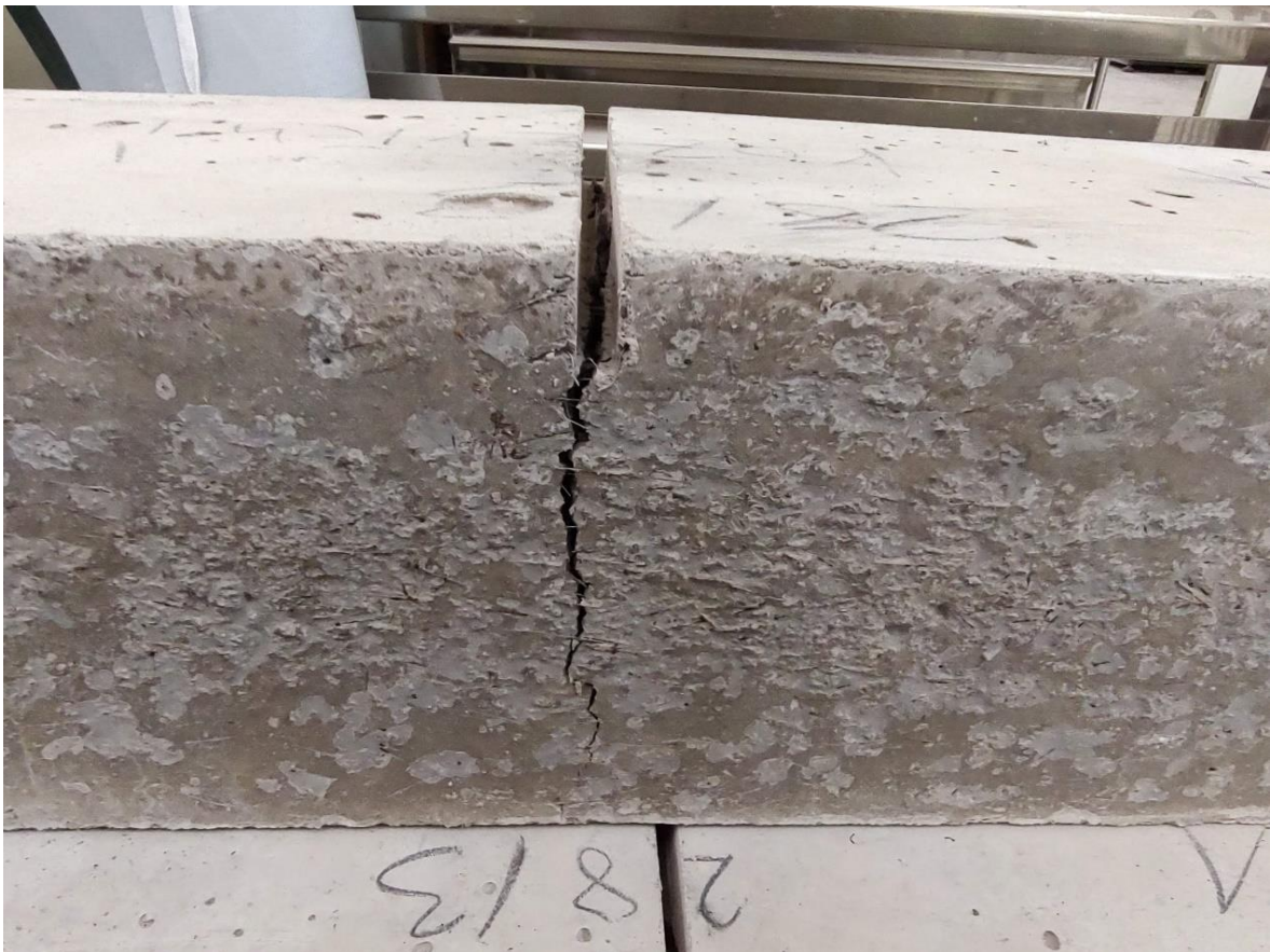
Obrázek 32 Zkušební těleso po ukončení zkoušky (směs 4, vlákna Masterfibre 482)
