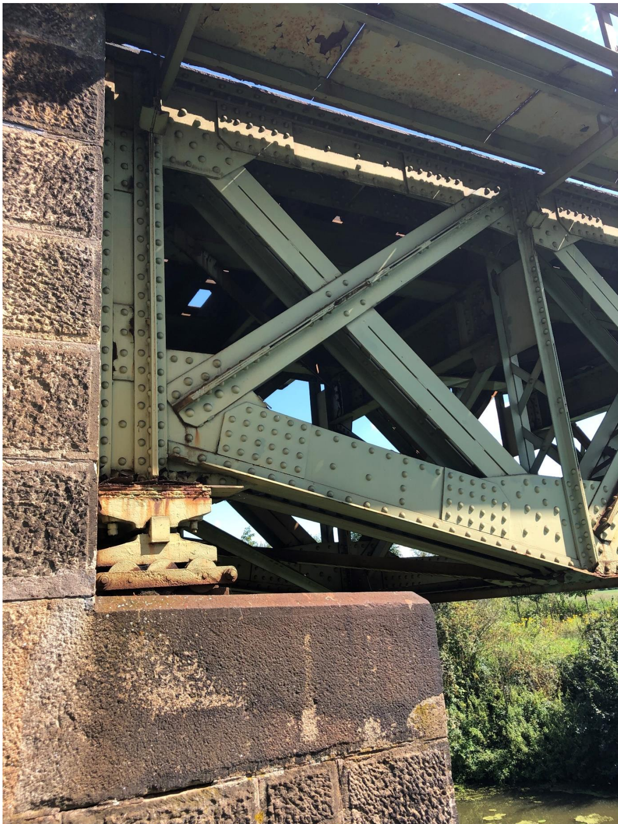
Obrázek 10 - Pohled na opěru a pevné ložisko [fotografie: archive autora]
