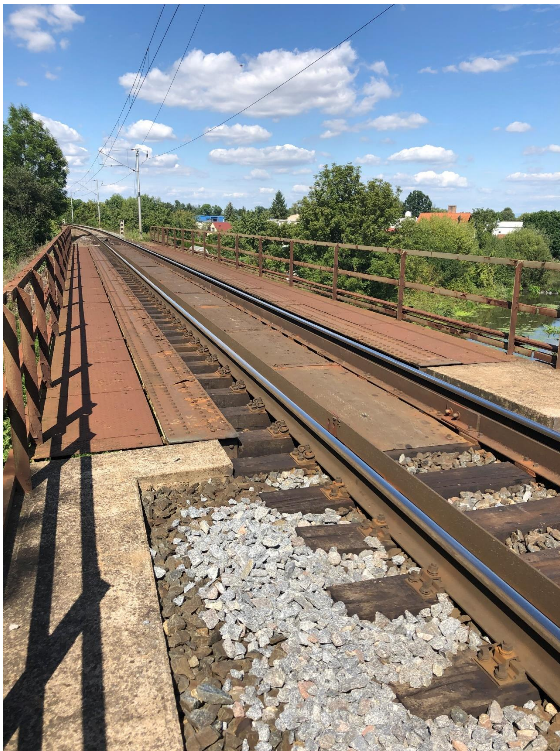
Obrázek 1 - Pohled na mostní svršek [fotografie: archive autora]
