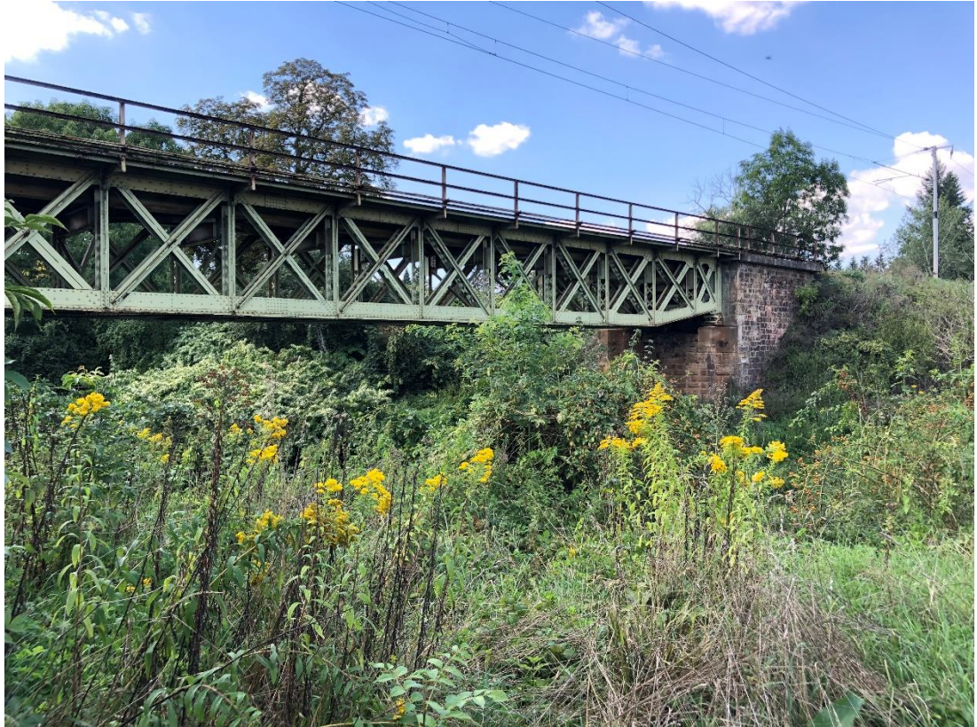
Obrázek 4 - Boční pohled na mostní objekt (2) [fotografie: archive autora]
