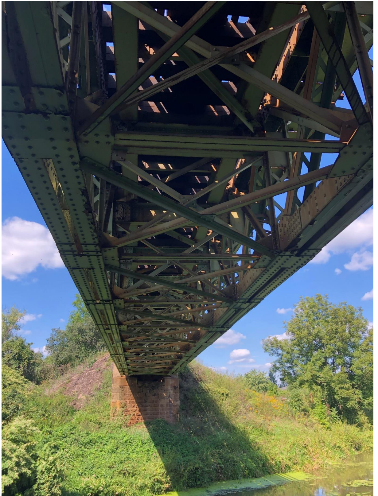
Obrázek 7 – Spodní pohled na mostní objekt (2) [fotografie: archive autora]
