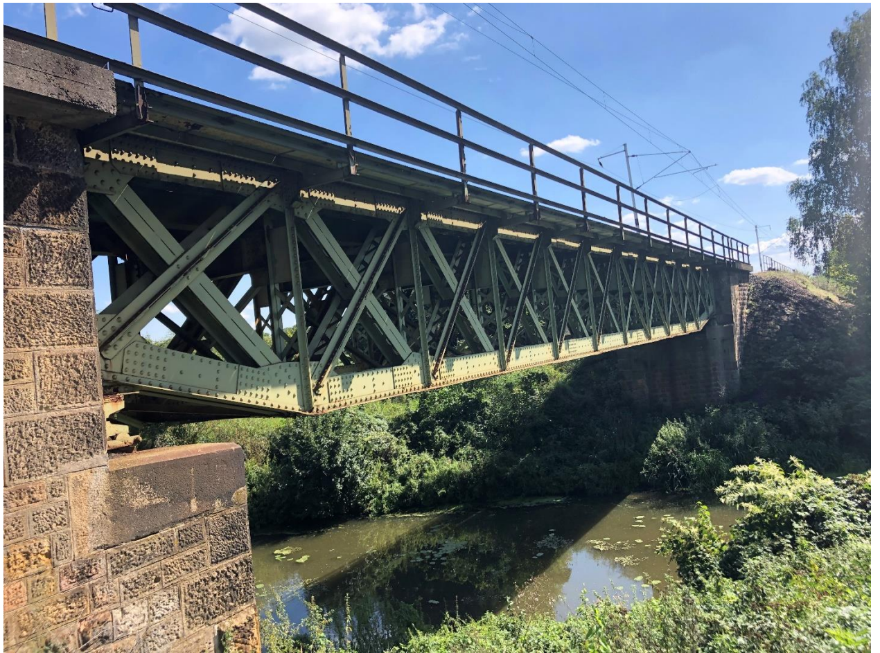
Obrázek 2 - Boční pohled na mostní objekt [fotografie: archive autora]
