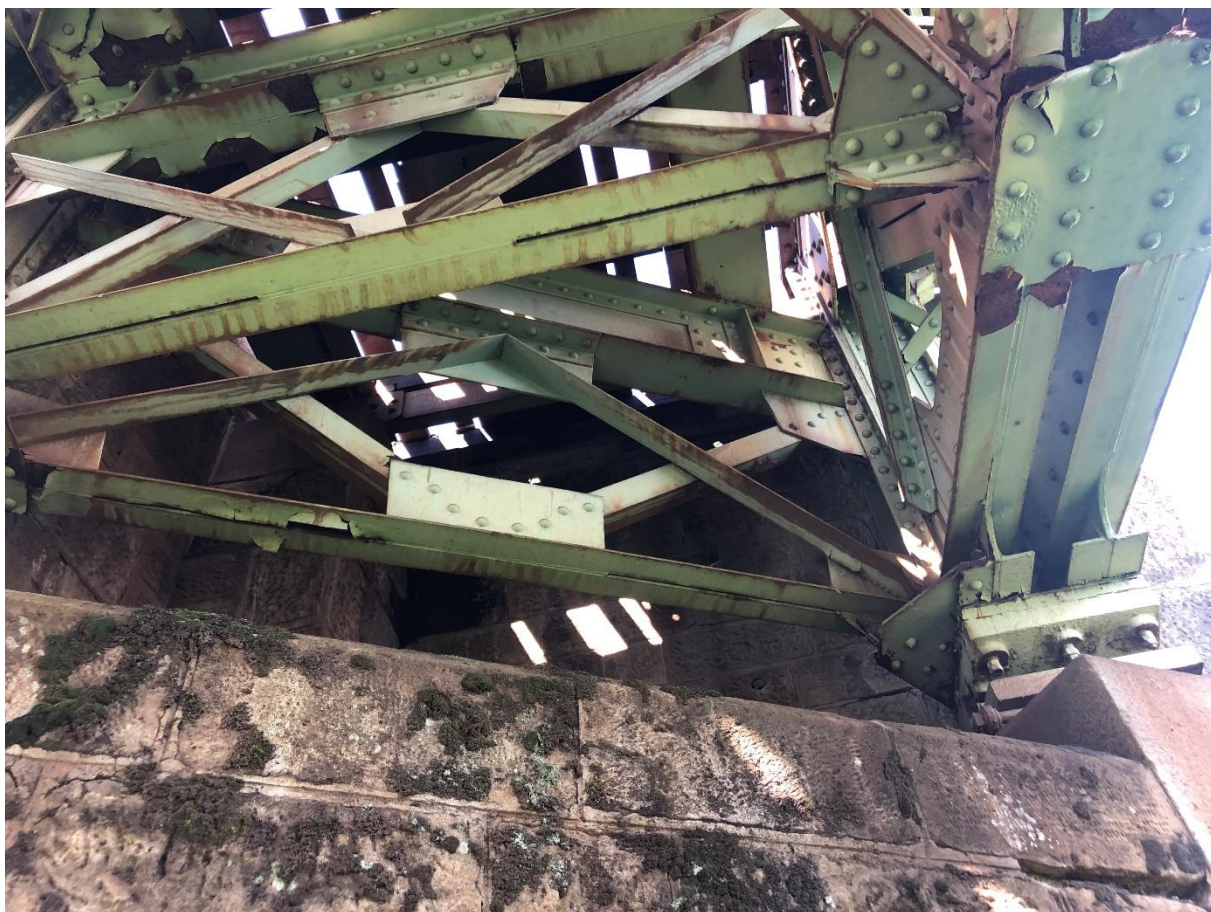
Obrázek 9 - Pohled na krajní šikmý příčník [fotografie: archive autora]
