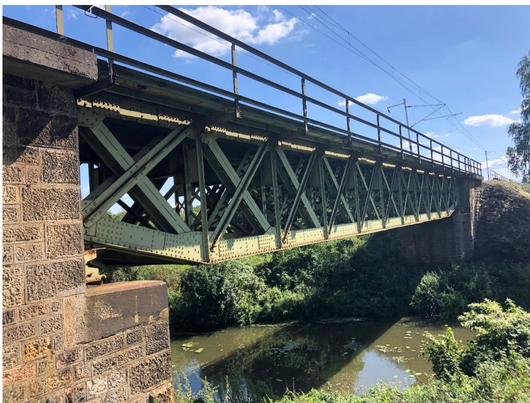
Obrázek 3- Pohled na mostní objekt [vlastní foto]
