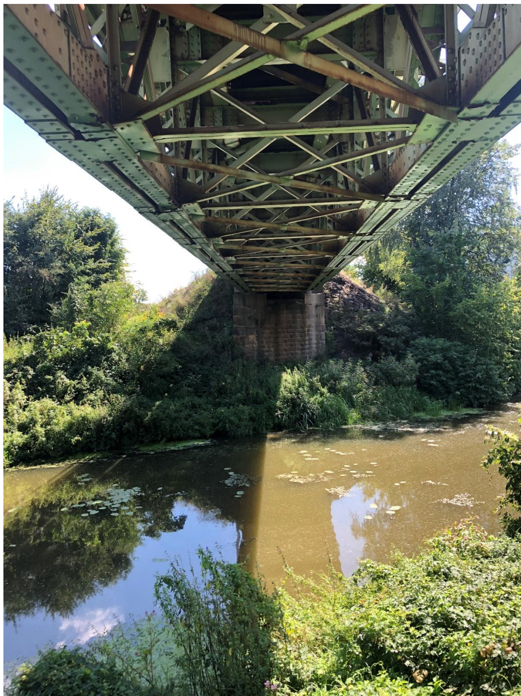
Obrázek 6 –Spodní pohled na mostní objekt (1) [fotografie: archive autora]
