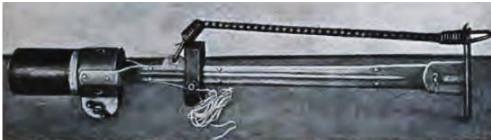
Obrázek 62 – Konstrukce křídlové světlice [26]
