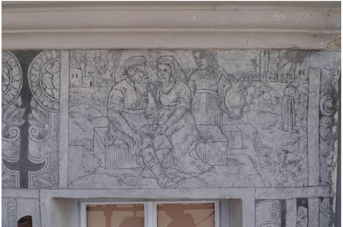
Obr. 35. Stav před restaurováním.
