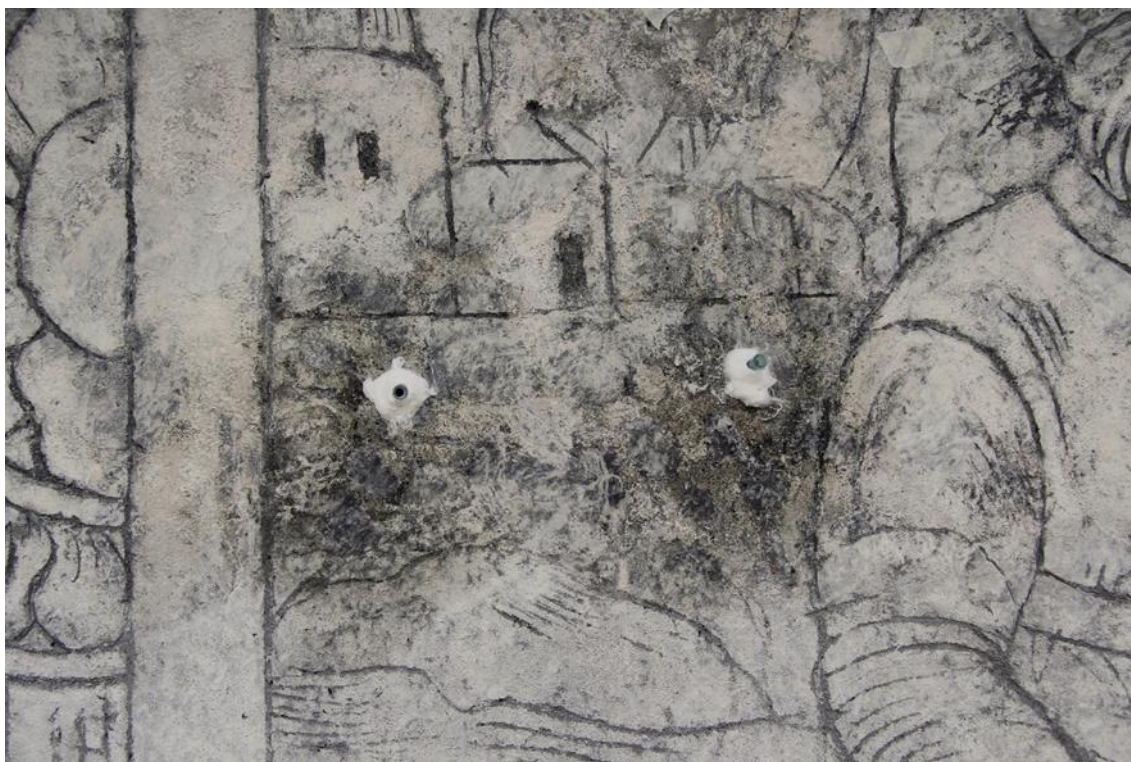
Obr. 25. Detail výjevu „č. 19“ v průběhu injektáže dutin.
