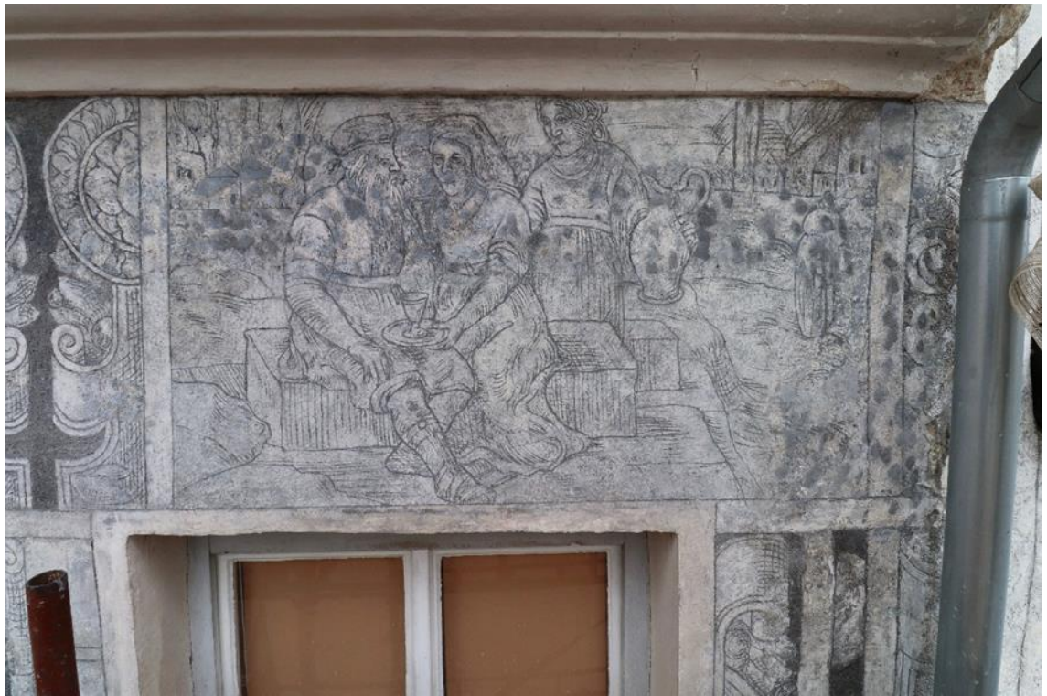
Obr. 37. Stav po vytmelení vrstvy probarvené omítky.
