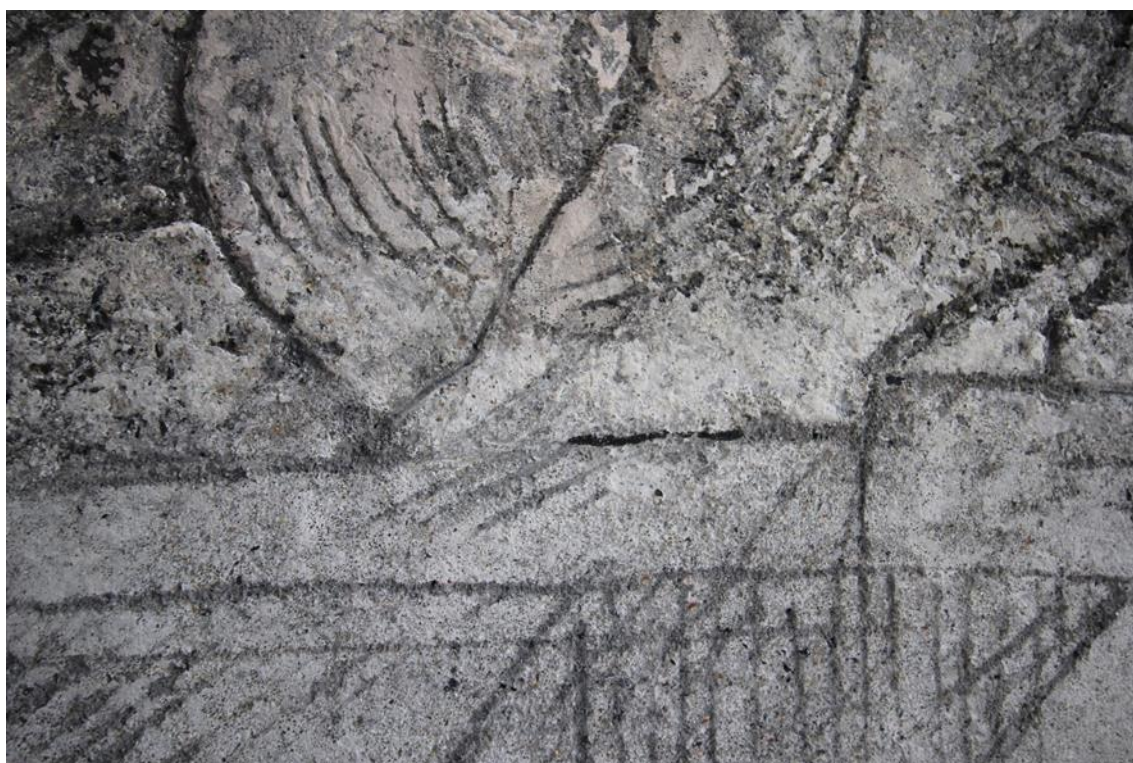
Obr. 16. Detail výjevu „č. 34“ ve stavu před restaurováním. Viditelně rozdílný charakter druhotných tmelů v dolní části oproti originálu v části horní.
