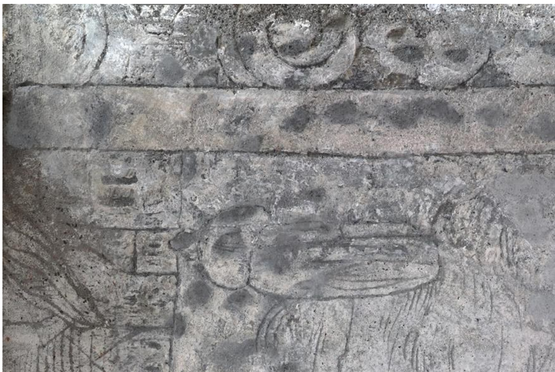
Obr. 41. Stav po vytmelení vrstvy probarvené omítky.
