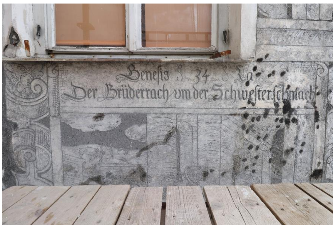
Obr. 30. Horní část výjevu „č. 34“ po odstranění nevyhovujících druhotných doplňků a strukturální konsolidaci.
