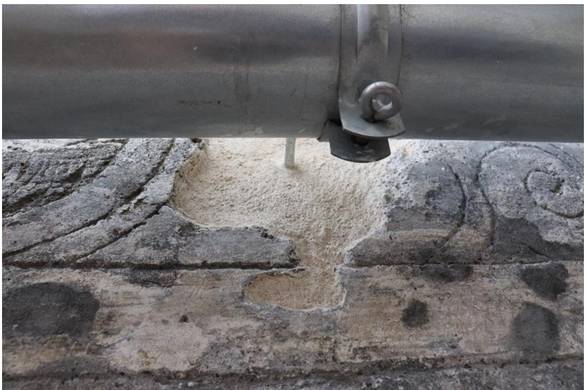
Obr. 56. Stav po vytmelení první vrstvy jádrové omítky.
