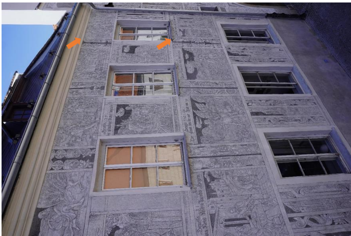
Obr. 9. Bližší pohled na pravou polovinu fasády domu čp. 538 ve stavu po restaurování. Dva jednotlivé výjevy v kraji fasády, nad a pod oknem v prvním patře, byly přiděleným úsekem k restaurování. Autorem Jana Waisserová.
