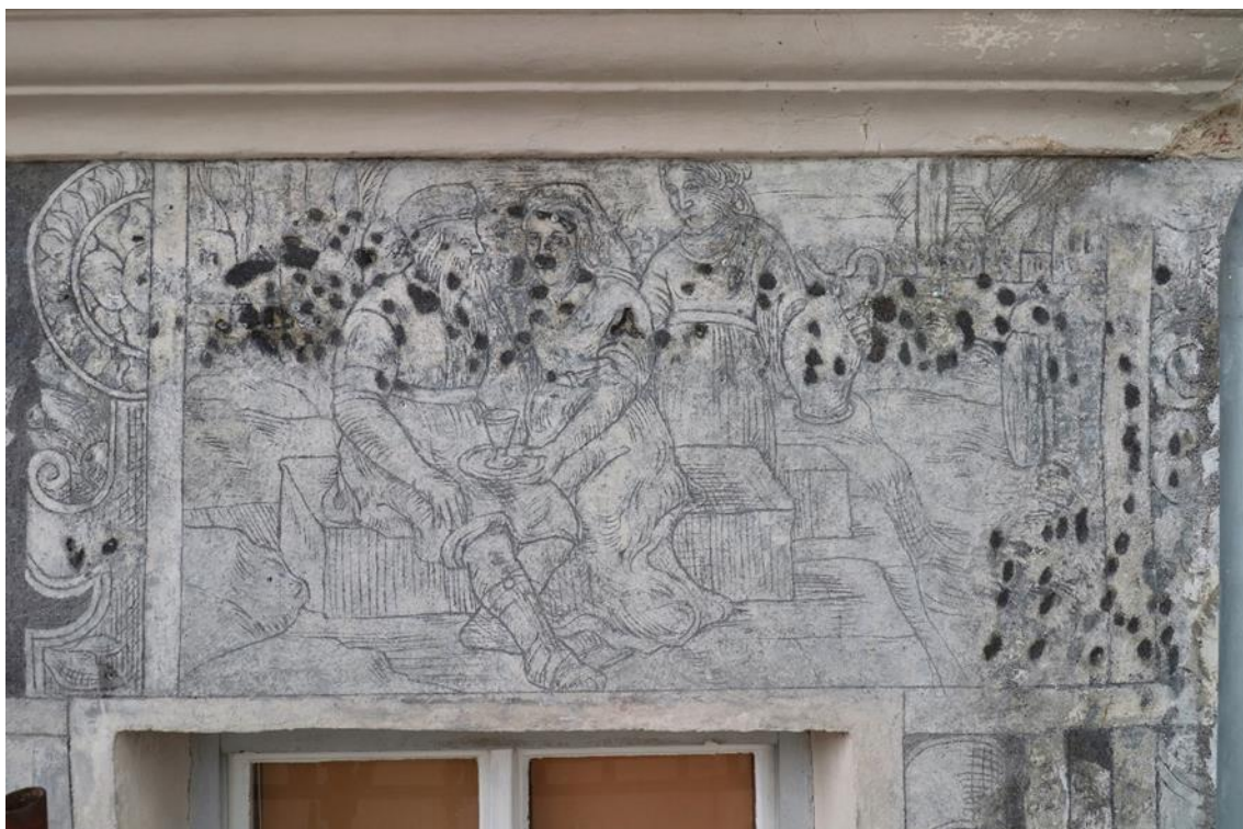
Obr. 29. Výjev „č. 19“ ve fázi po odstranění nevyhovujících druhotných doplňků a strukturální konsolidaci, která proběhla napouštěním prostředků Remmers KSE 100 a CaLoSil E25 přes otevřené defekty a odhalenou strukturu omítkových vrstev.
