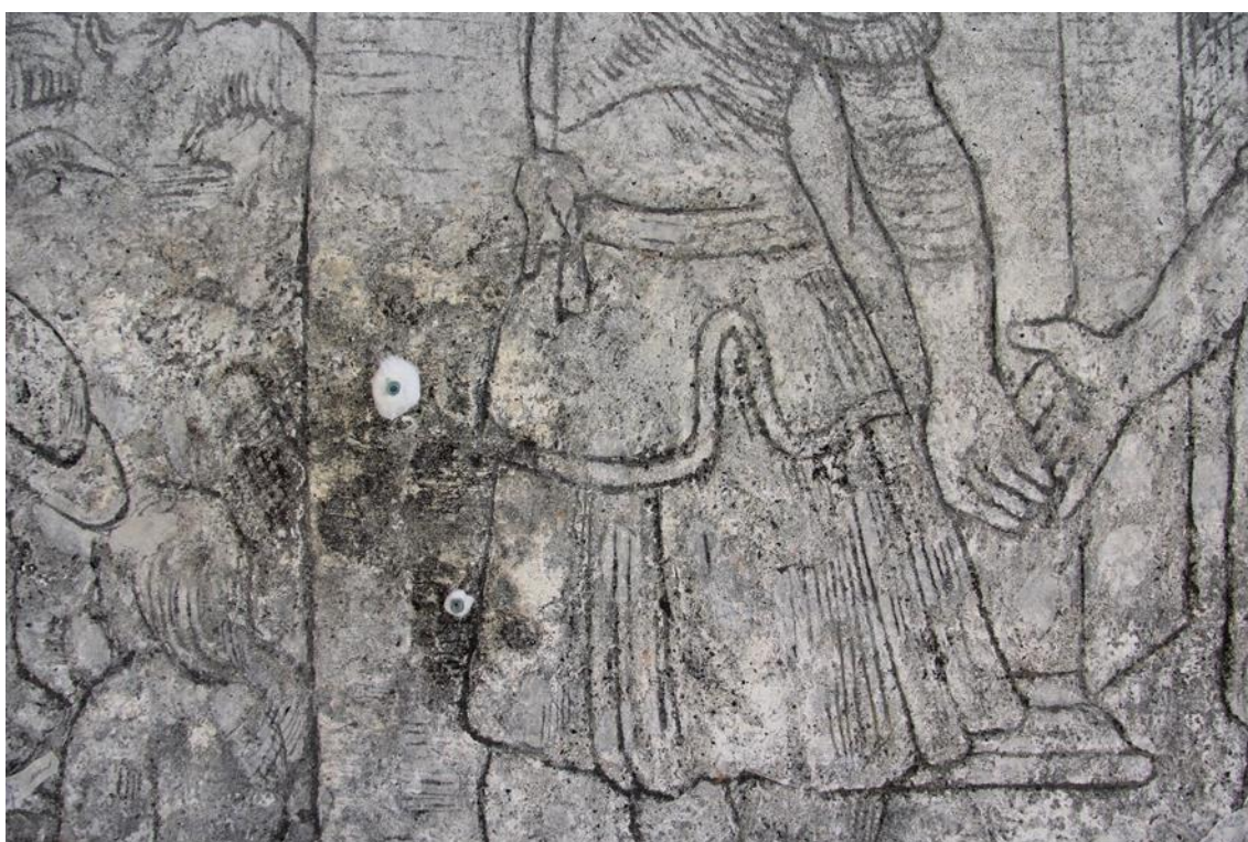
Obr. 26. Detail výjevu „č. 34“ v průběhu injektáže dutin.
