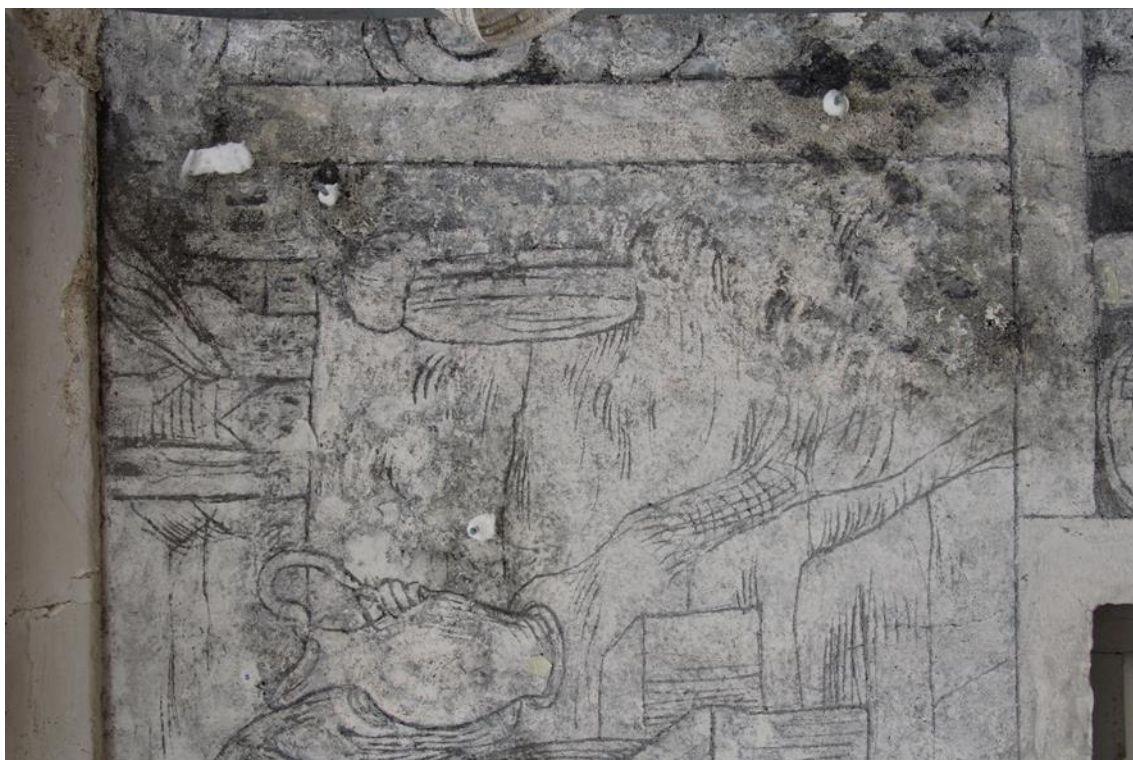
Obr. 27. Detail výjevu „č. 19“ v průběhu injektáže dutin.
