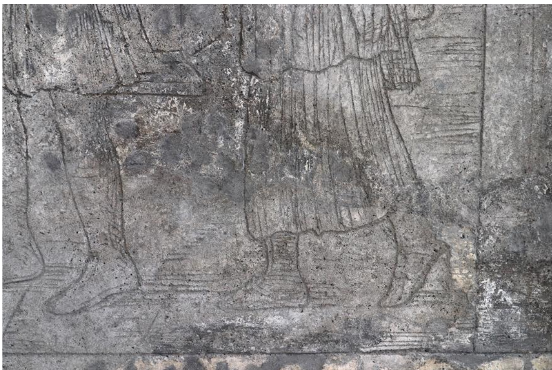
Obr. 53. Stav po vytmelení vrstvy probarvené omítky.
