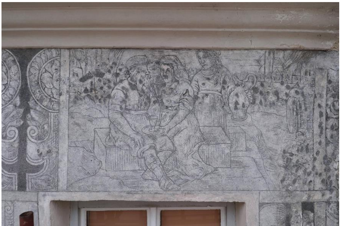
Obr. 36. Stav po odstranění nevyhovujících druhotných doplňků.
