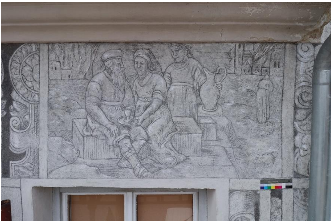
Obr. 38. Stav po restaurování.
