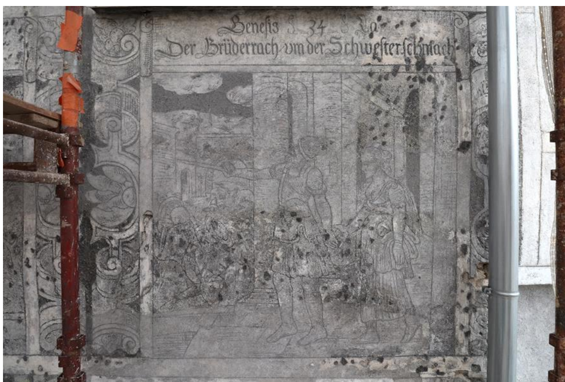
Obr. 44. Stav po odstranění nevyhovujících druhotných doplňků.
