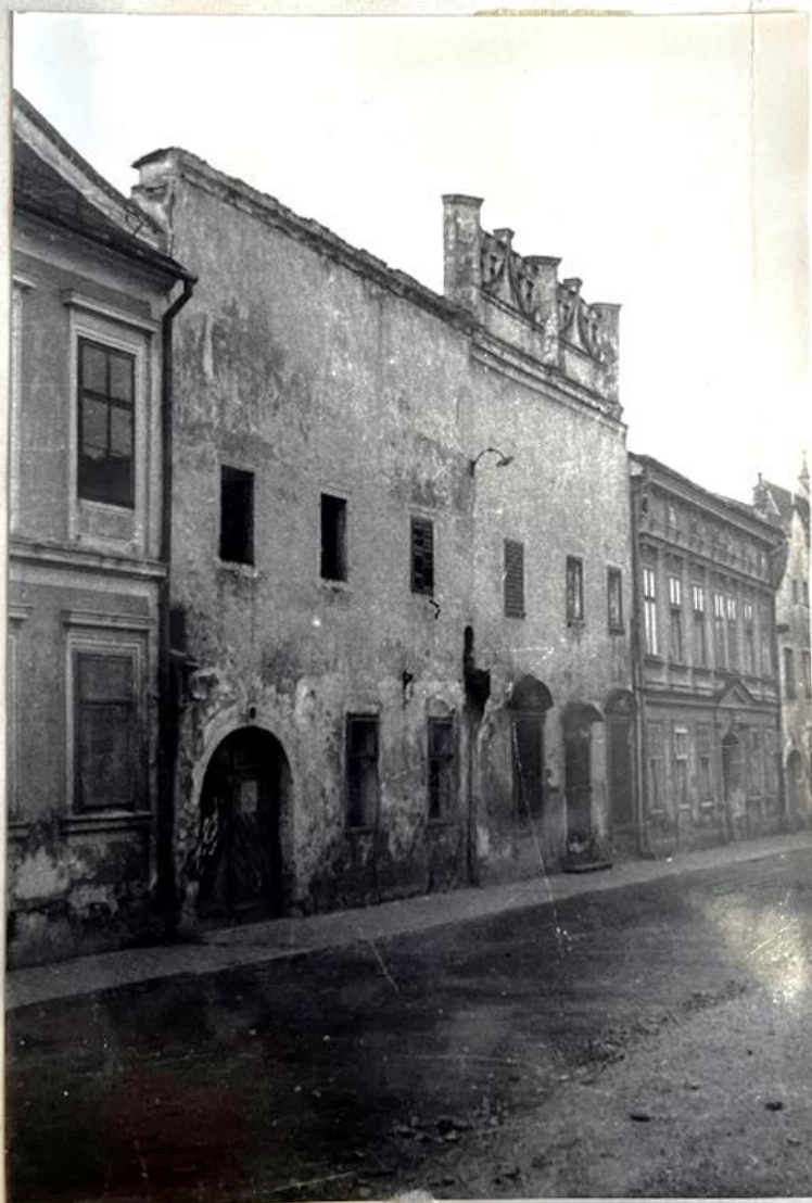
Obr. 1. Pohled na průčelí domů čp. 536, 537 a části 538. Zachycuje podobu klasicistní fasády před odkryvem renesančního sgrafita v roce 1967. Součást dokumentace technické zprávy: ŠMIDRKAL, Josef. Technická zpráva k fotogrammetrickému zaměření průčelí domů čp. 538, 537, 536 ve Slavonicích. Státní ústav pro rekonstrukci památkových měst a objektů. 1986. Dostupné z archivu NPÚ ÚOP v Českých Budějovicích, PD 352.
