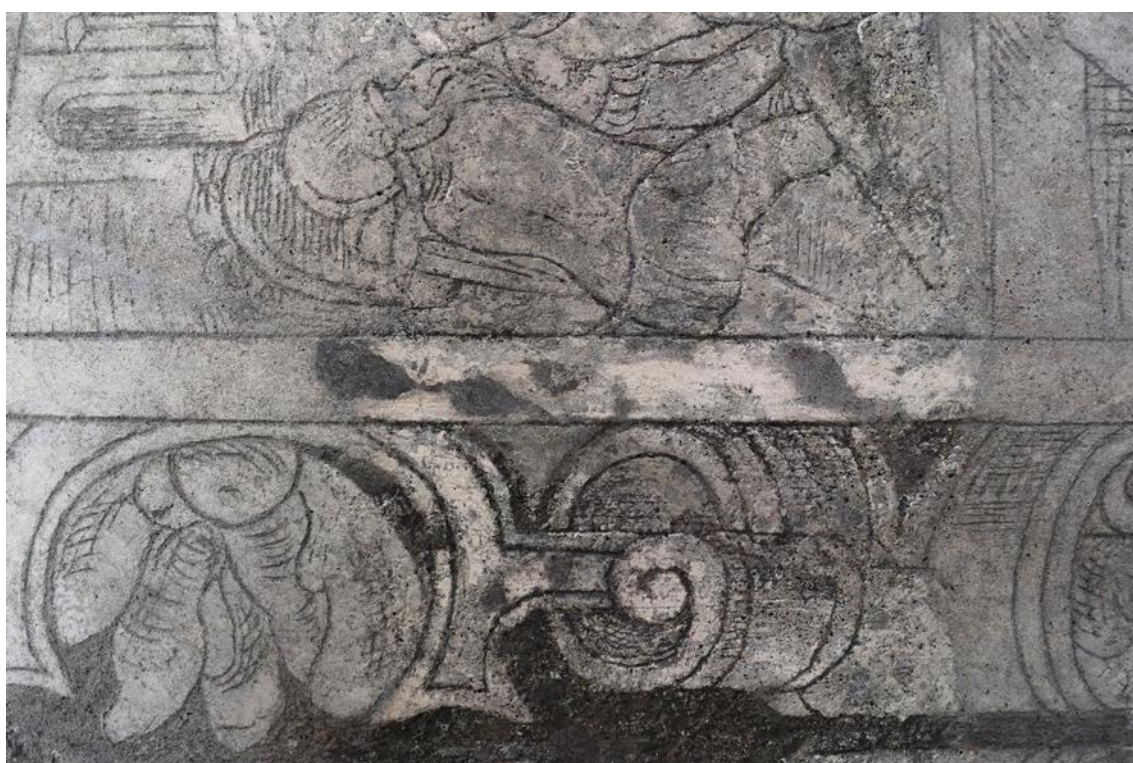
Obr. 34. Detail defektu v oblasti rámové pásky v levé části výjevu „č. 34“. Stav po vytmelení vrstvy probarvené omítky.
