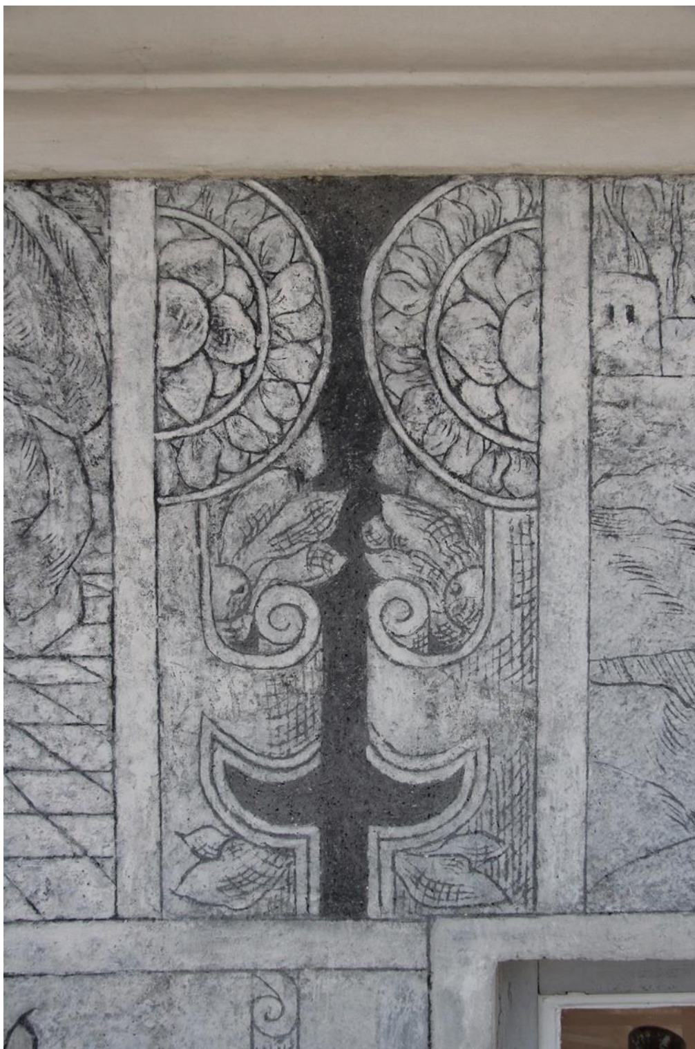
Obr. 19. Oblast rollwerku lemujícího z levé strany výjev „č. 19“. Stav před restaurováním. V horní části barevně odlišná plocha originálu, která byla ztmavena lazurními nátěry během předchozích restaurátorských zásahů.
