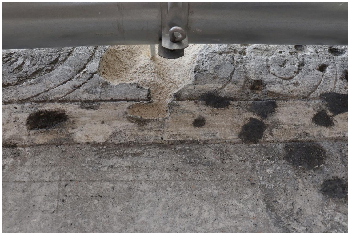
Obr. 57. Stav po dorovnání jádrové omítky. Provedeno ve dvou dalších vrstvách.
