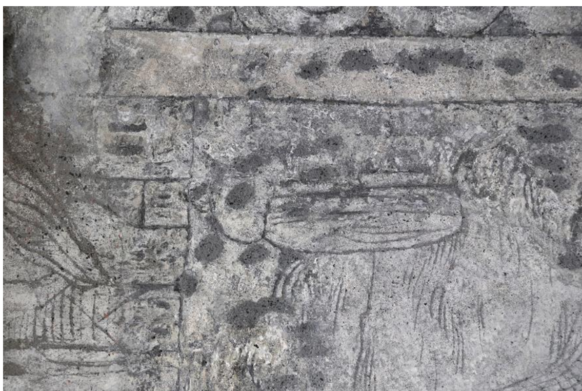
Obr. 40. Stav po odstranění nevyhovujících druhotných doplňků.
