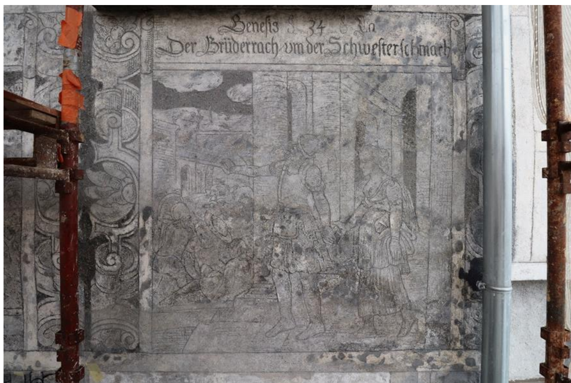
Obr. 45. Stav po vytmelení vrstvy probarvené omítky.
