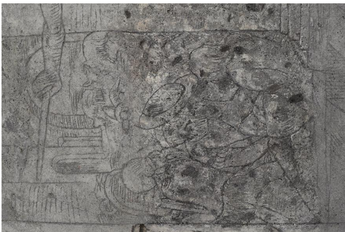
Obr. 48. Stav po odstranění nevyhovujících druhotných doplňků.
