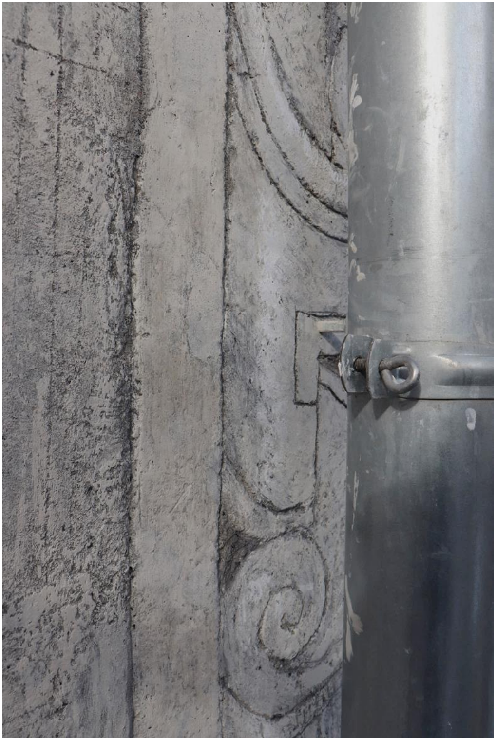
Obr. 59. Stav po restaurování.
