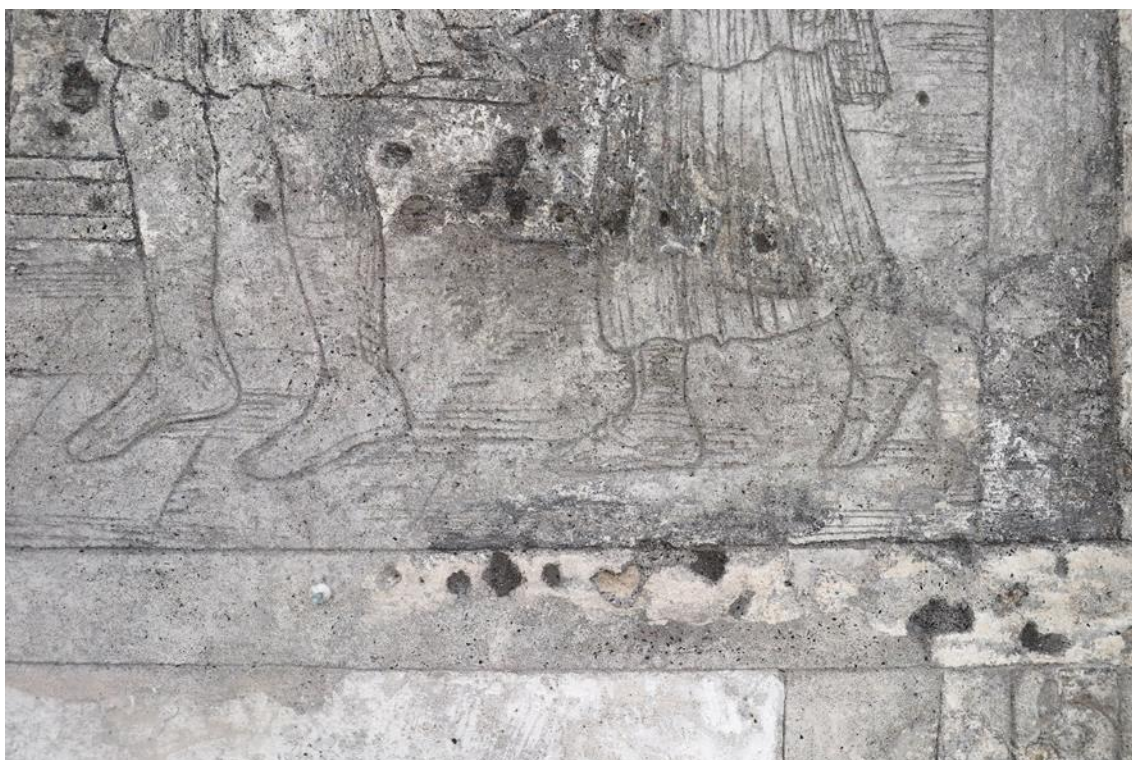
Obr. 52. Stav po odstranění nevyhovujících druhotných doplňků.
