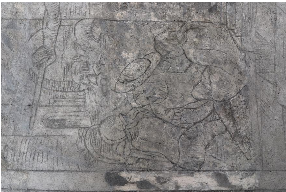
Obr. 49. Stav po vytmelení vrstvy probarvené omítky.
