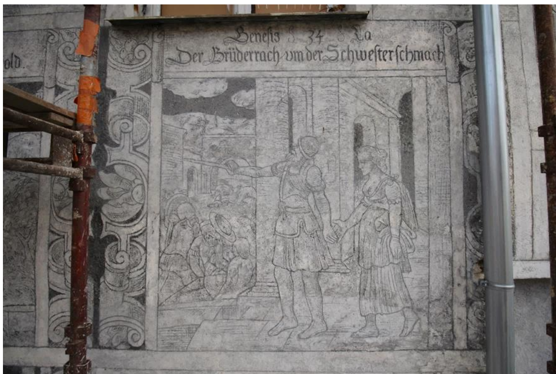
Obr. 43. Stav před restaurováním.
