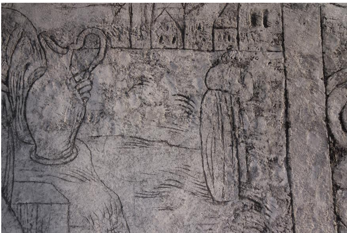
Obr. 21. Detail části výjevu „č. 19“ ve stavu před restaurováním. Rozdílnost struktury povrchu druhotných tmelů (levý dolní roh) a originálních omítkových vrstev s pekováním (téměř celá horní část a pravá strana).
