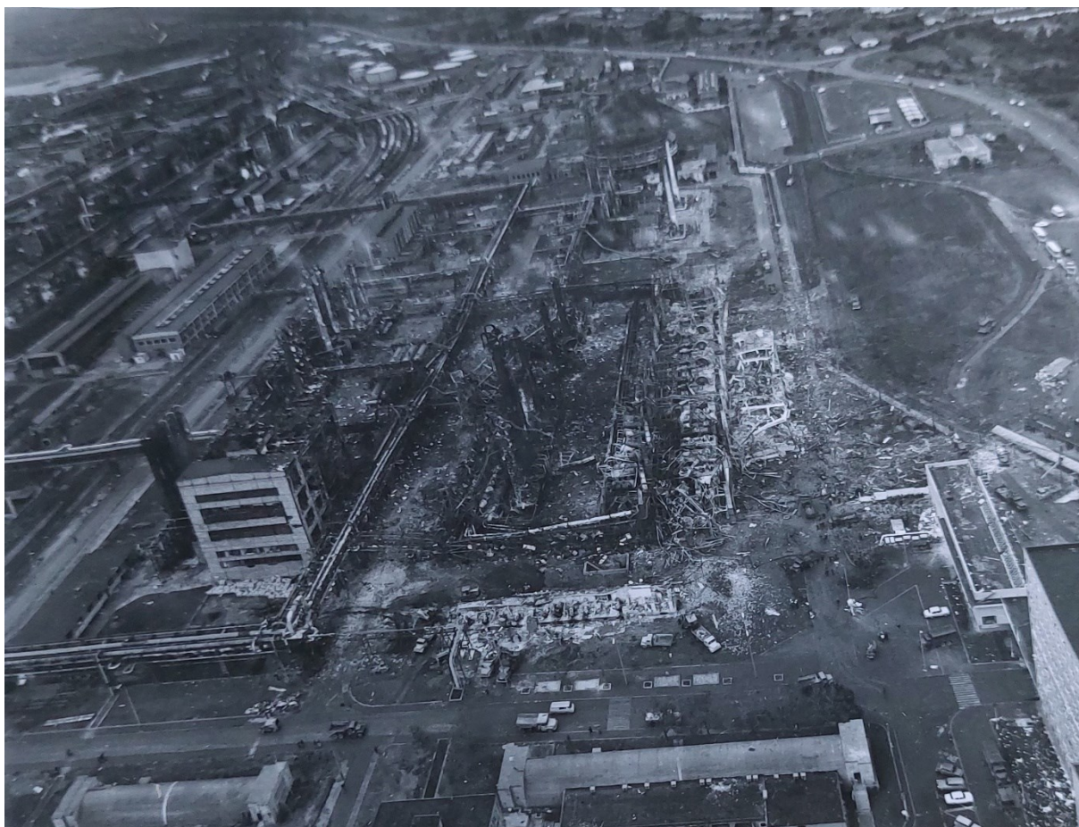
Obrázek 4 Výroba syntetického lihu po výbuchu, vlevo poničená budova ethylbenzenu[18]
