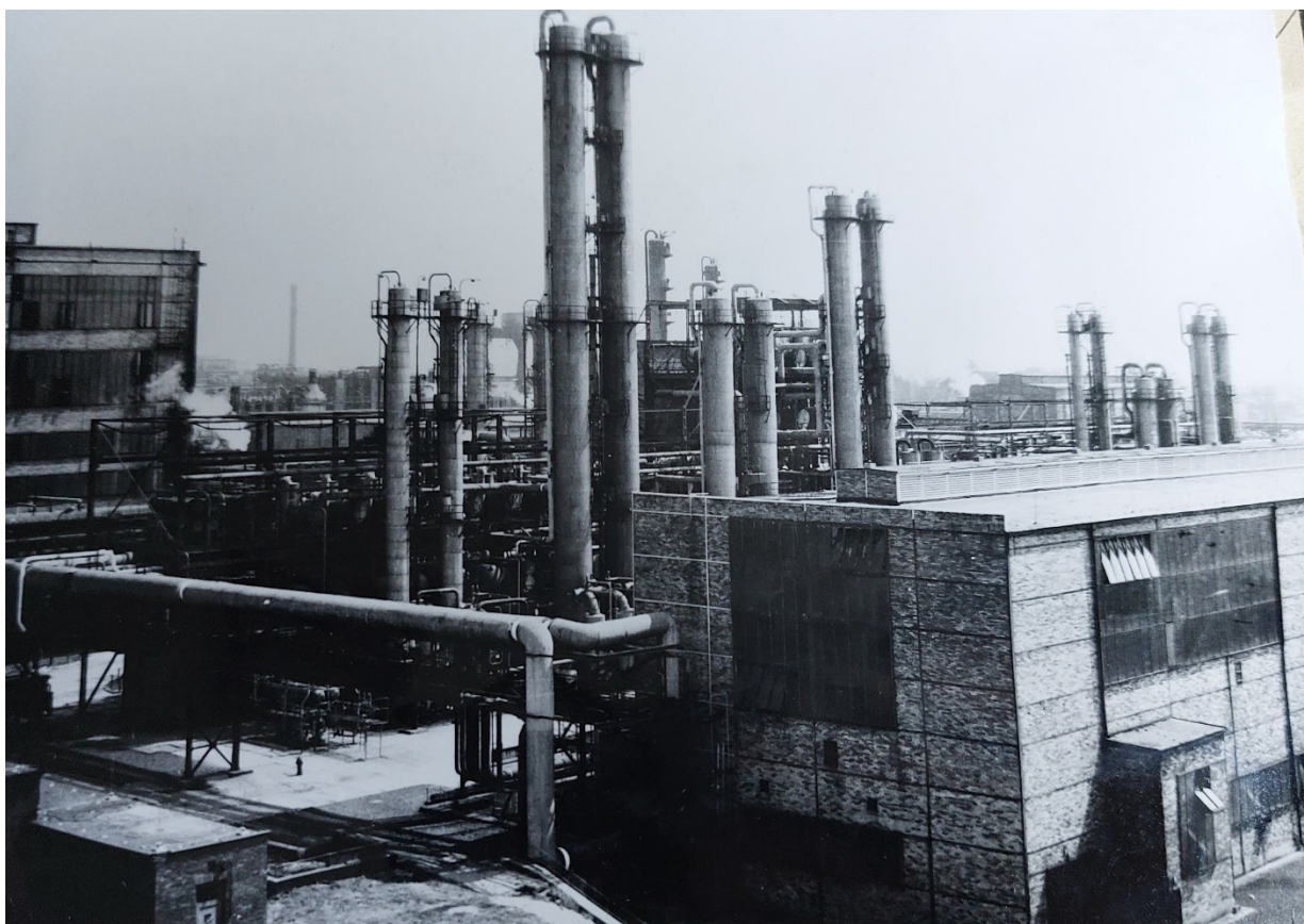
Obrázek 2 Výroba syntetického lihu před nehodou, v popředí budova kompresorovny, následují rektifikační kolony a vlevo v pozadí budova ethylbenzenu[18]
