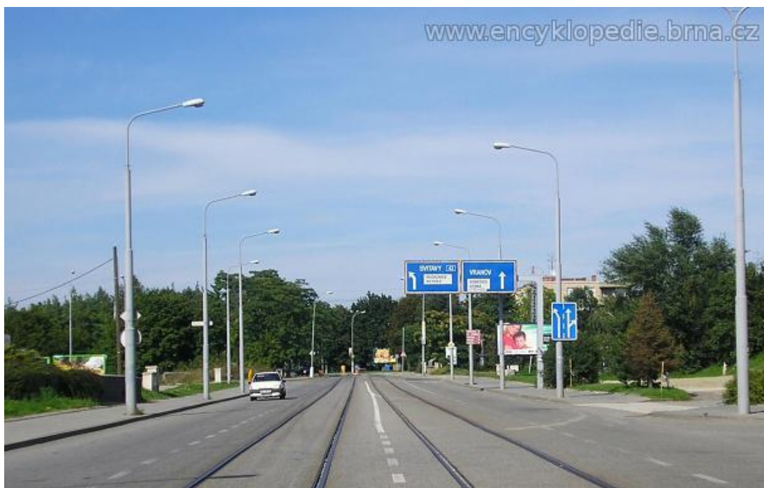
Obrázek 4: tramvajové koleje v ulici Merhautově
