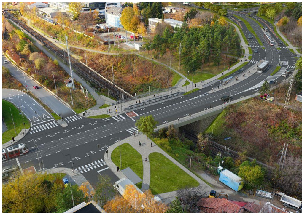
Obrázek 6: most přes železniční trať 251
