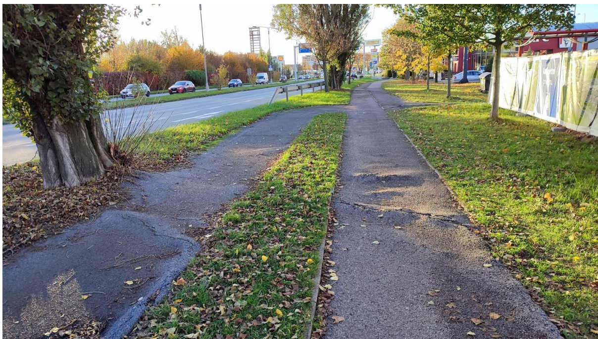
Obrázek 19 Poškození dělené stezky pro chodce a cyklisty v Pilnáčkově ulici
