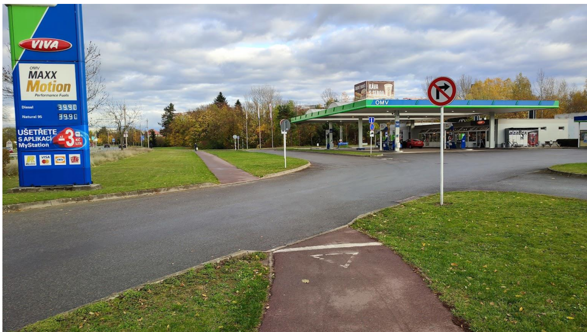
Obrázek 53 Křížení stezky pro chodce a cyklisty s jednosměrným provozem cyklistů a PK propoující S I/31 a čerpací stanici OMV
