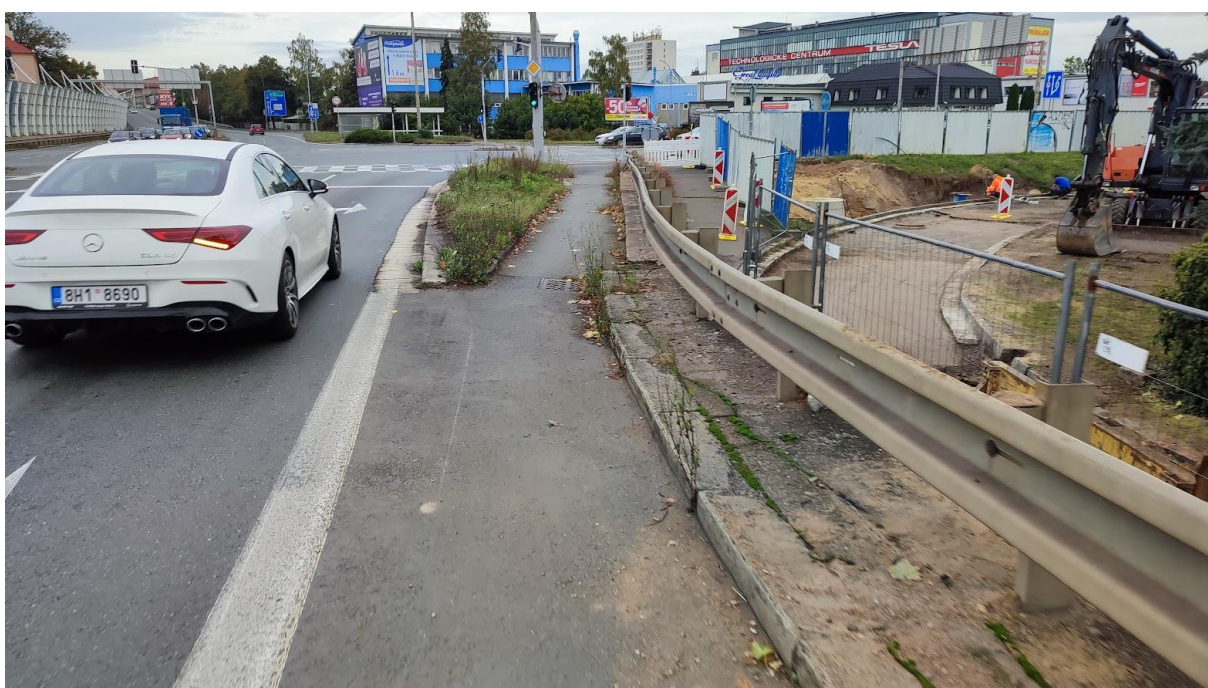
Obrázek 5 Vedení cyklistů z HDP do PDP u křižovatky Gočárova okruhu s ulicí Víta Nejedlého
