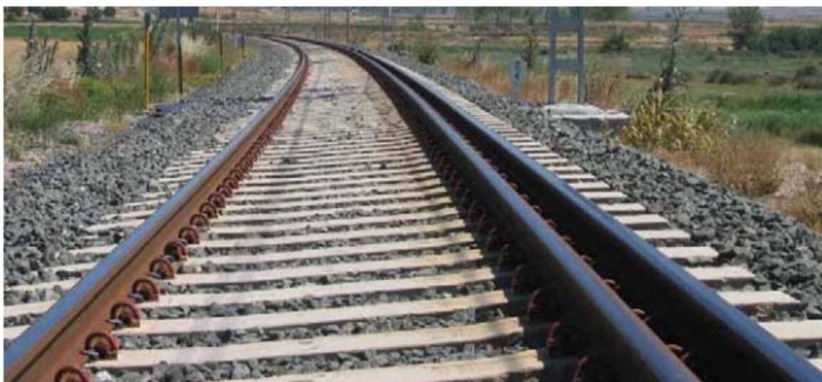
Obrázek 13: Třetí kolejnice v koleji
