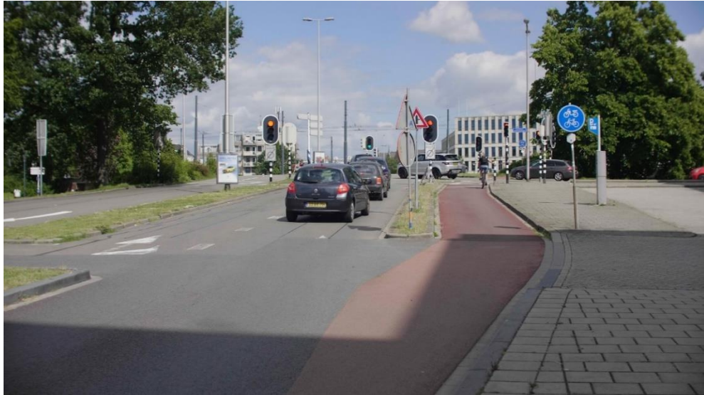
Obrázek 29 Přechod z cyklopruhu do samostatného cyklistického pásu
