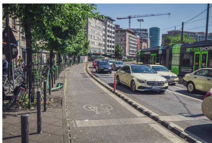
Obrázek 55 Nízkonákladově fyzicky oddělný cyklopruh
