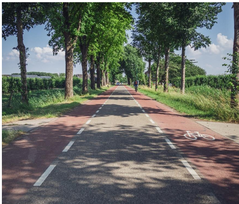
Obrázek 22 Zklidněná komunikace typu AR-60 v extravilánu
