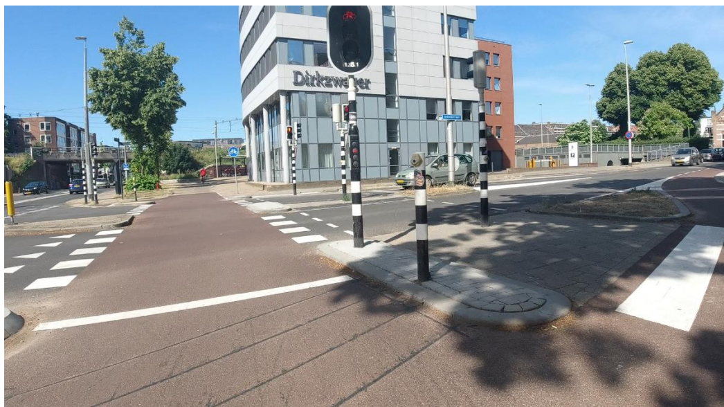
Obrázek 28 Fyzicky oddělený průjezd průsečnou křižovatkou
