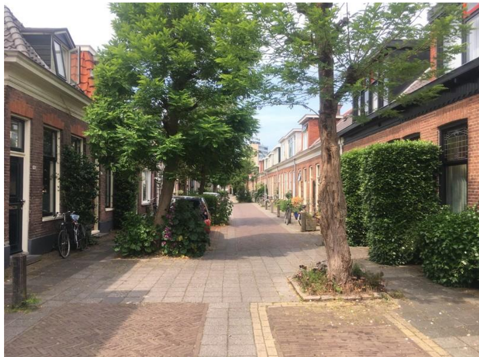
Obrázek 26 Provedení zklidněné obytné ulice formou nizozemského Woonerf
