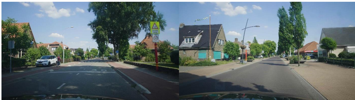
Obrázek 24 Přechod průtahu silnice N339 do zklidněné komunikace
