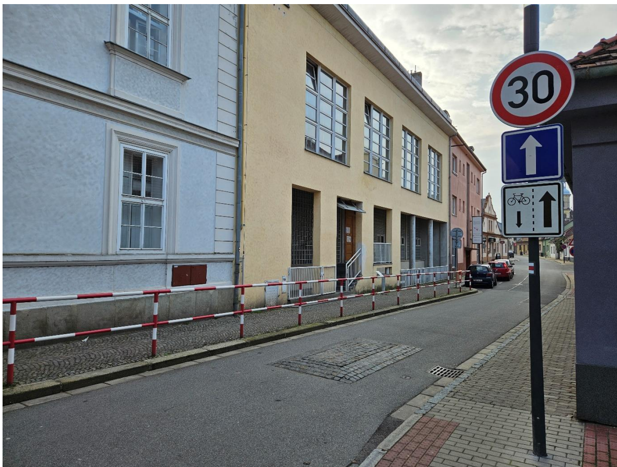
Obrázek 22 Zklidňovací opatření u ZŠ v ulici Zborovská
