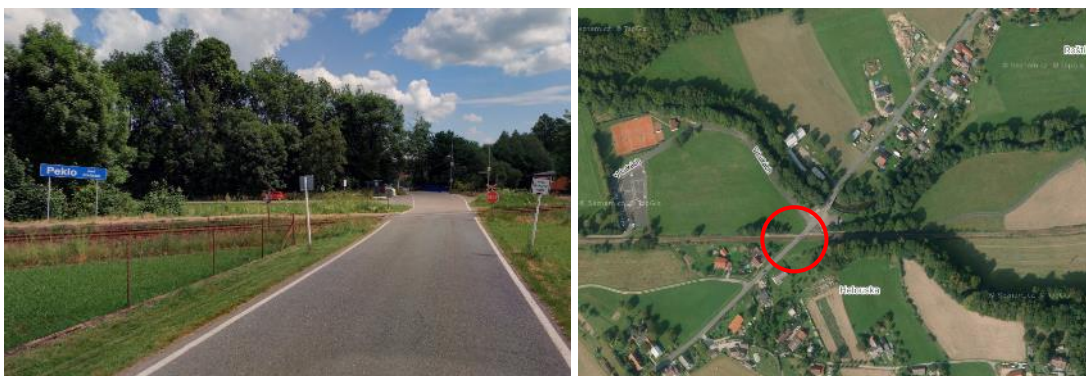
Obr. 17 Přejezd P4126 u zastávky Peklo nad Zdobnicí, křížení s komunikací III/3193 (2)
