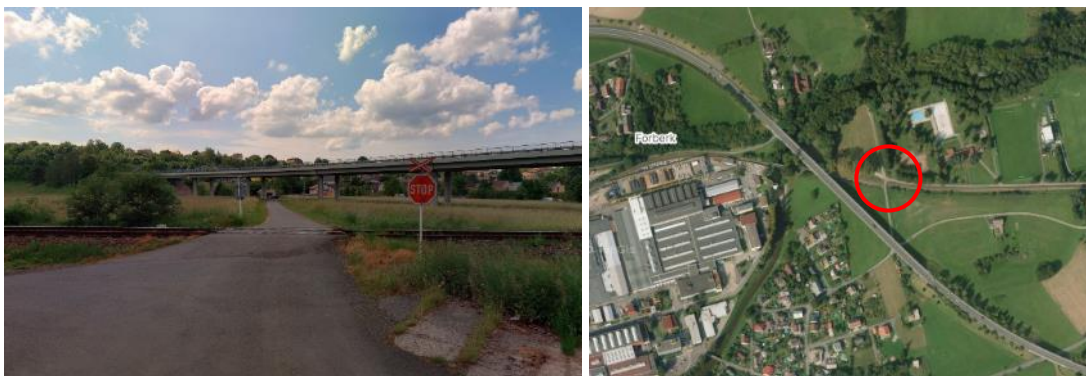
Obr. 16 Přejezd P4125, křížení s účelovou komunikací (2)
