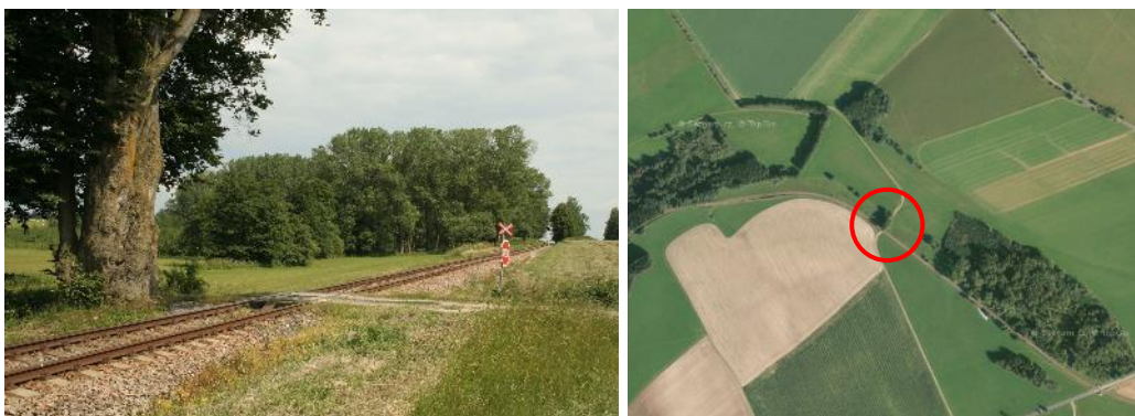
Obr. 32 Přejezd P4140, křížení s účelovou komunikací (2) (15)
