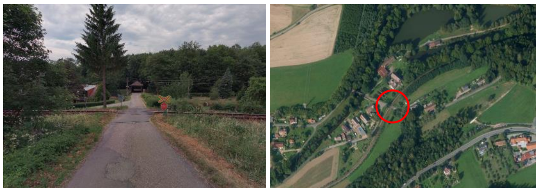
Obr. 19 Přejezd P4128, křížení s komunikací III/3194 (2)
