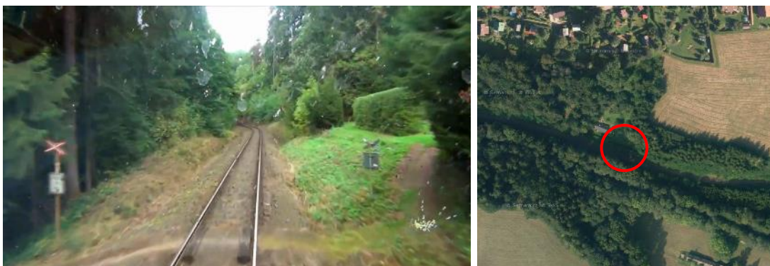
Obr. 23 Přejezd P4131 u domu č.p. 2, křížení s místní komunikací (2) (13)
