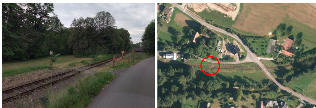
Obr. 25 Přejezd P4133, křížení s účelovou komunikací (2)
