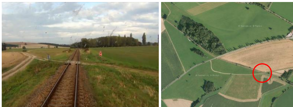
Obr. 34 Přejezd P4142, křížení s účelovou komunikací (2) (13)
