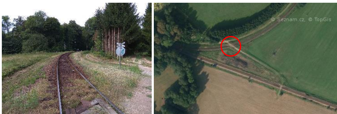
Obr. 10 Přejezd P4119, křížení s účelovou komunikací (2) (11)
