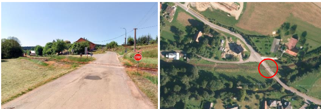
Obr. 26 Přejezd P4134, křížení s komunikací III/3195 (2)
