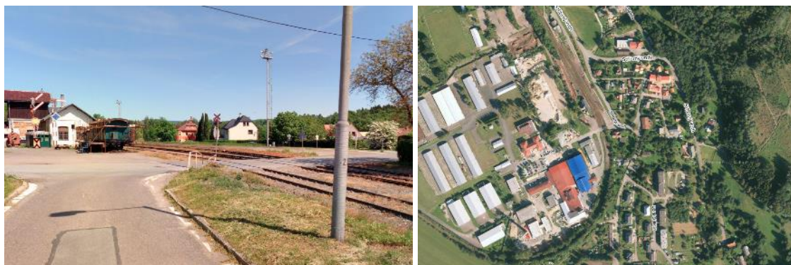
Obr. 35 Přejezd P4144, křížení s místní komunikací (2)
