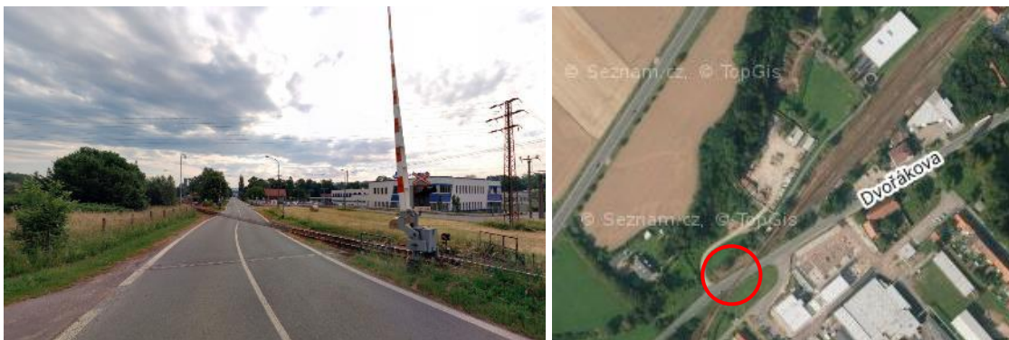
Obr. 12 Přejezd P4121, křížení s komunikací I/11 (2)
