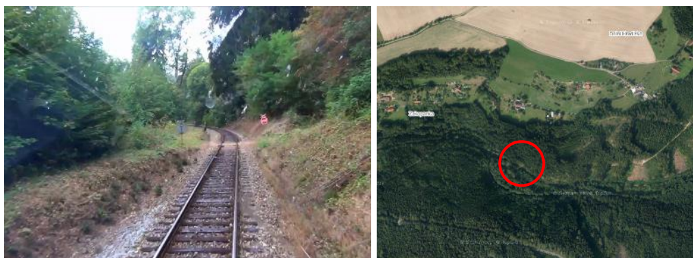
Obr. 20 Přejezd P4129, křížení s účelovou komunikací (2) (13)
