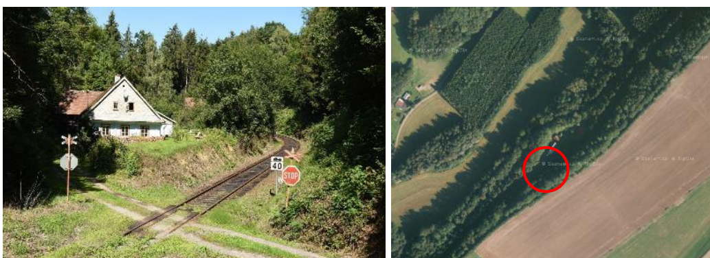
Obr. 28 Přejezd P4137 u domu č.p. 211, křížení s účelovou komunikací (2) (14)
