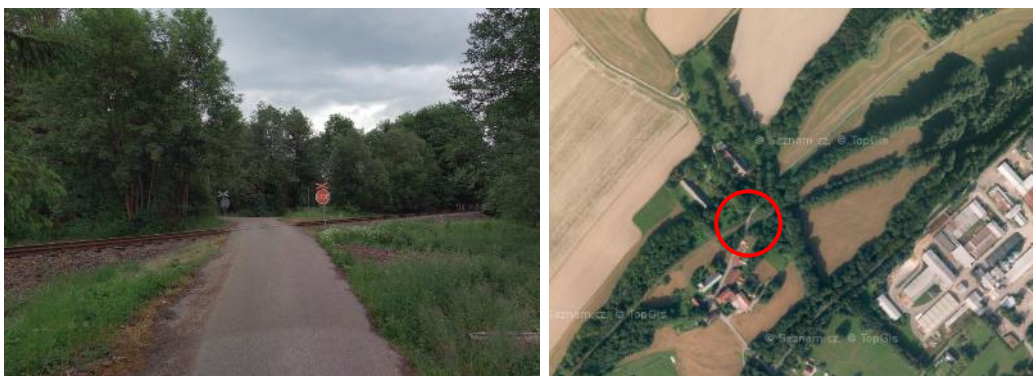
Obr. 27 Přejezd P4136, křížení s místní komunikací (2)
