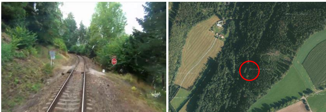
Obr. 29 Přejezd P4138, křížení s účelovou komunikací (2) (13)
