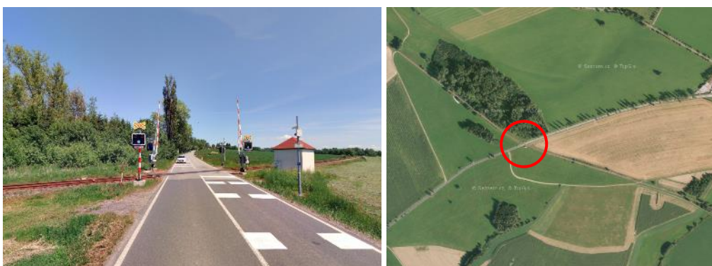
Obr. 33 Přejezd P4141, křížení s komunikací II/319 (2)
