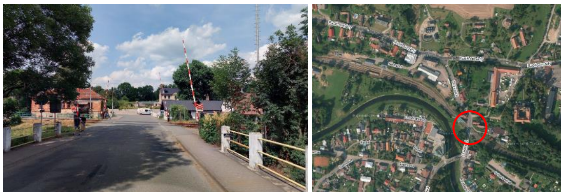
Obr. 9 Přejezd P4038, křížení s komunikací III/3164 (2)
