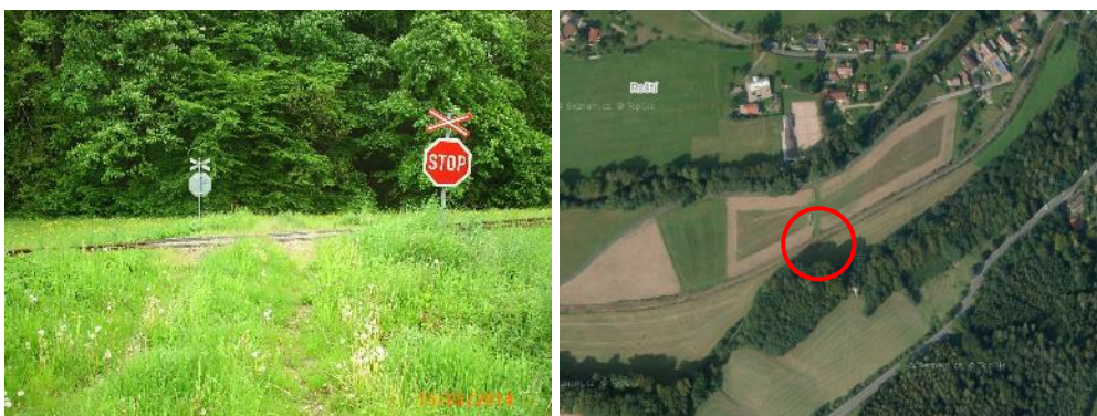
Obr. 18 Přejezd P4127, křížení s účelovou komunikací (2) (12)
