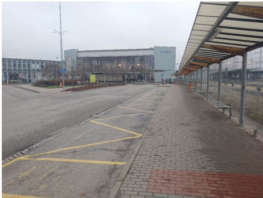
Obrázek D1 Současný stav stanoviště Dopravní terminál
