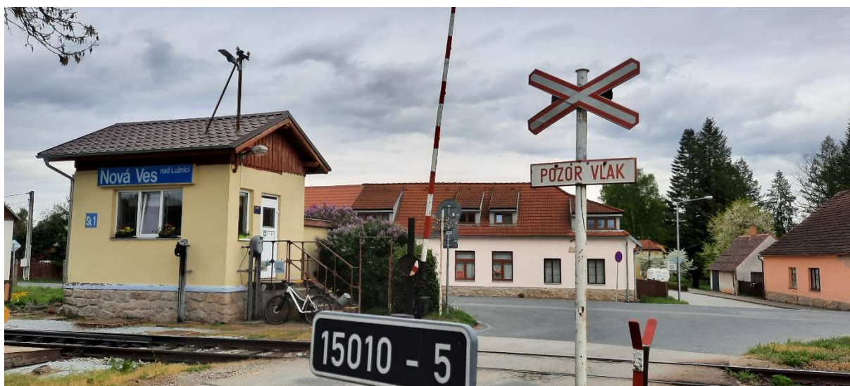
Obrázek 7 Přejezd P5587 zabezpečený výstražnými kříži a břevny závislémi na ruční obsluze signalistou (autor)
