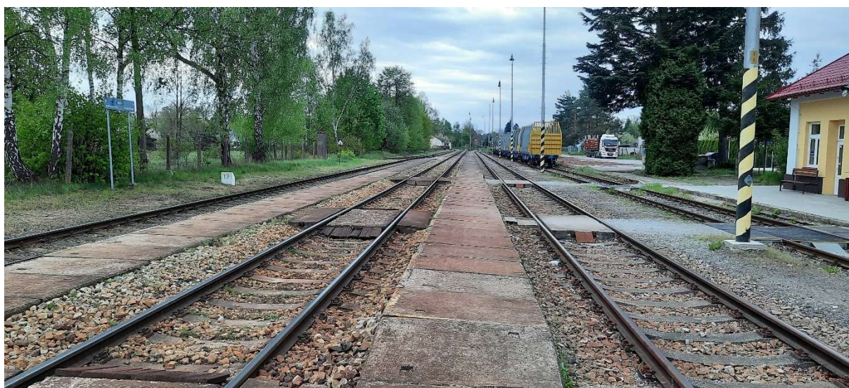
Obrázek 8 Výhled na peron v ŽST Suchdol nad Lužnicí (autor)
