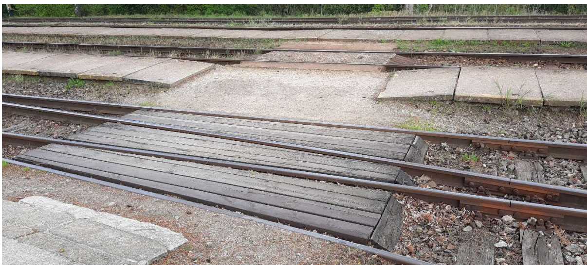
Obrázek 10 Přechod přes koleje v ŽST Třeboň (autor)
