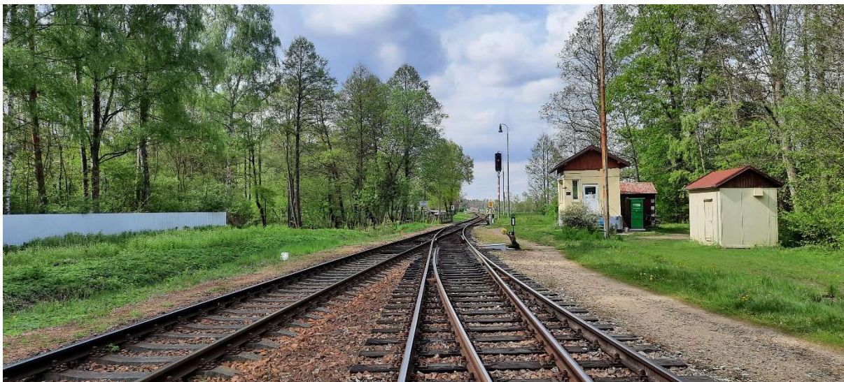
Obrázek 6 Třeboňské zhlaví ŽST Majdalena. Absence ohřevu výměn vyžaduje v mrazivém období péči zaměstnanců infrastruktury (autor)
