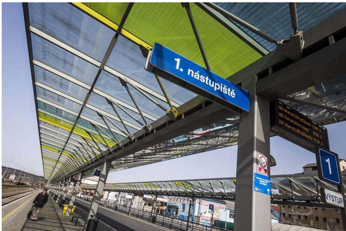
Obrázek 12 Dopravní terminál Uherský Brod (24, Hochtief, 2016)
