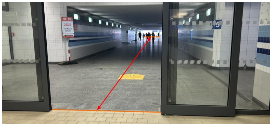
Obrázek 11 Úsek vedený severním podchodem stanice Plzeň hl. n.
