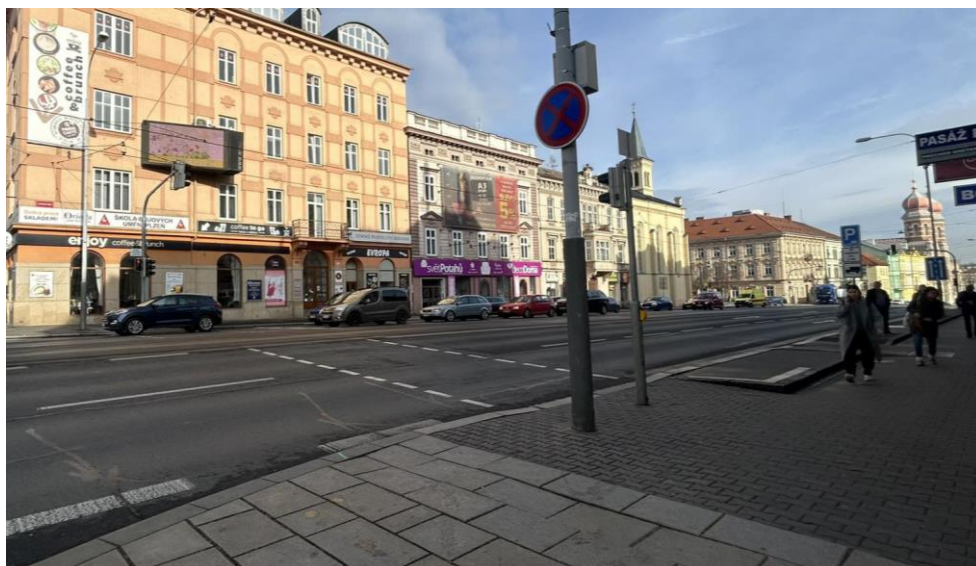
Obrázek 16 Chybějící varovný a signální pás
