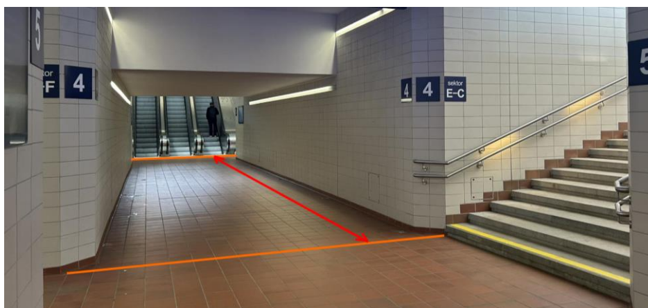
Obrázek 4 Úsek vedený podchodem mezi 1. a 2. nástupišťem stanice Pardubice hl. n.
