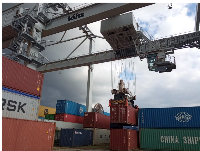
Obrázek 10 Jeden z jeřábů v terminálu METRANS Česká Třebová
