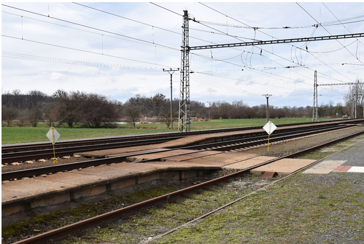
Obrázek 9: Přístup na nástupiště ŽST Hustopeče nad Bečvou
