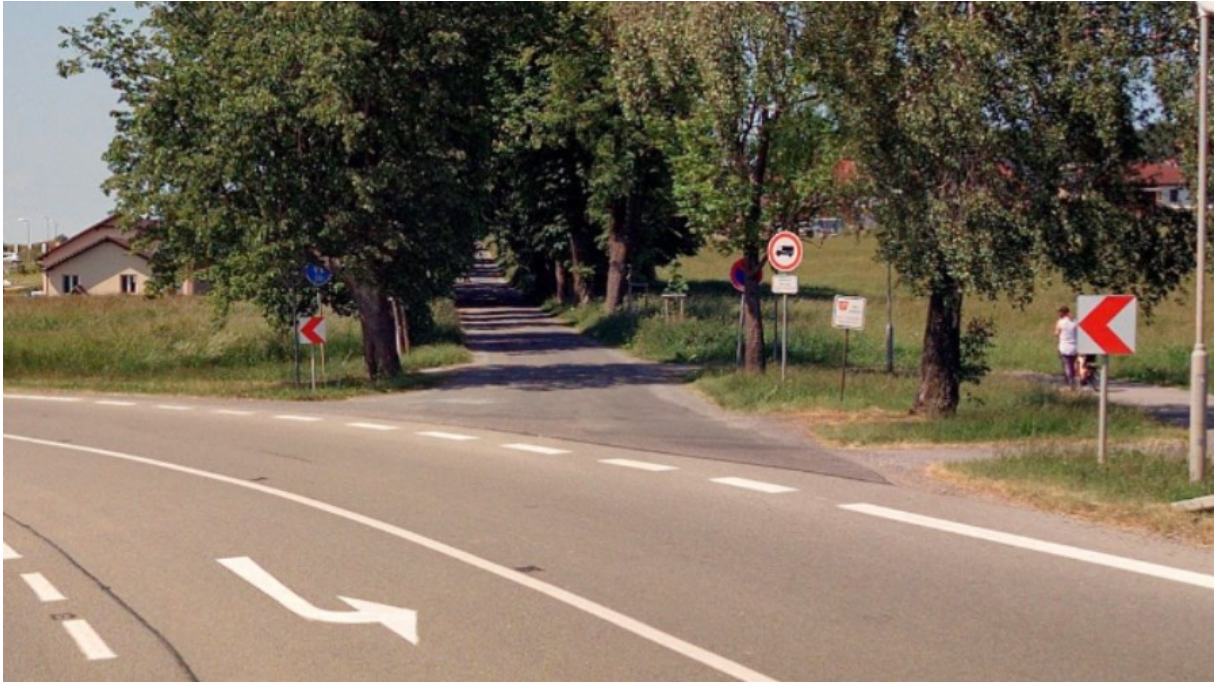
Obrázek 31 Pohled na křížení z pozemní komunikace I/43
