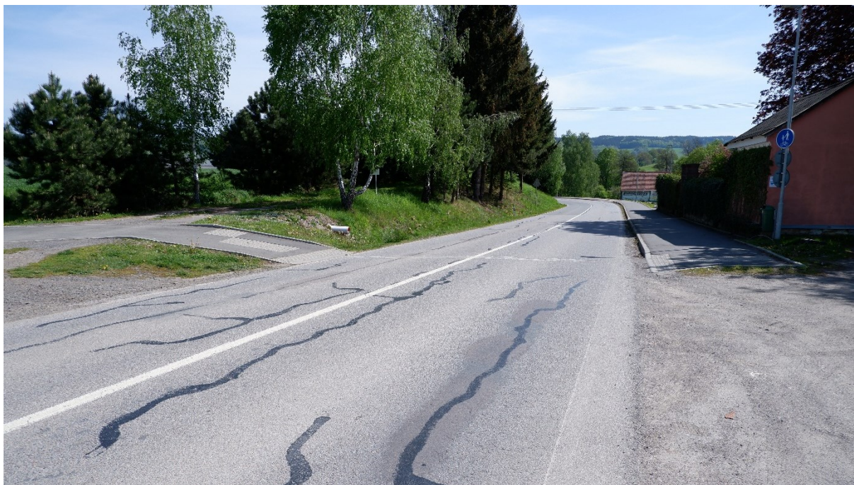
Obrázek 35 Pohled na křížení ze silnice II/315 směrem z Lanškrouna
