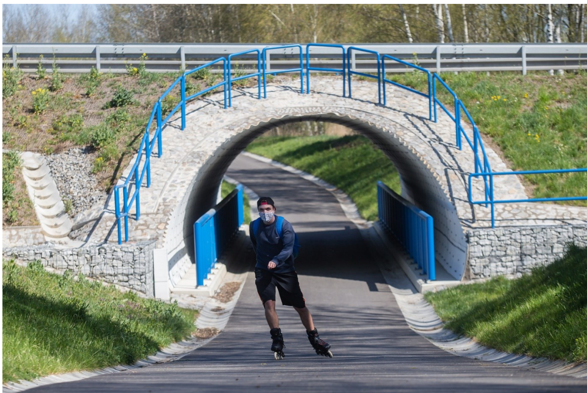
Obrázek 2 Mimoúrovňové křížení cyklostezky a silnice
