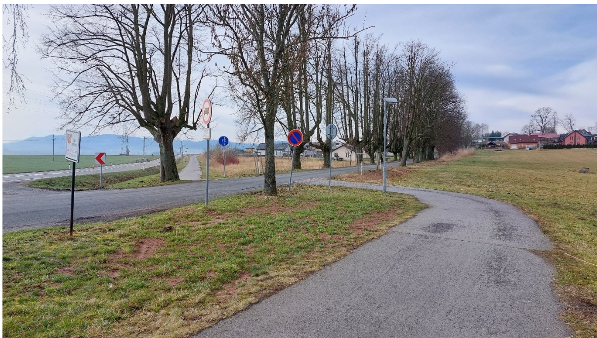
Obrázek 32 Příjezd na křižení směrem od Lanškrouna
