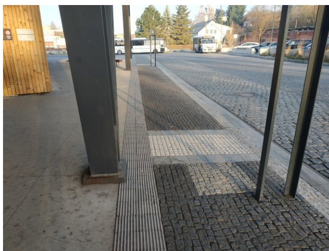
Obr. 11 Špatné napojení signálního pásu a nedodržení volného prostoru kolem umělé vodící linie
