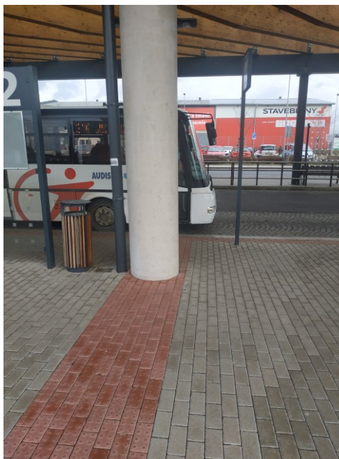
Obr. 9 Prerušený signální pás vedoucí k označníku
