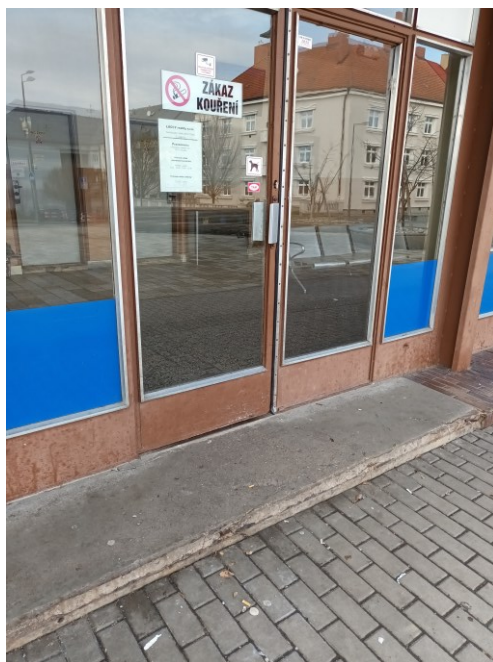
Obr. 4 Vchodové dveře do čekárny
