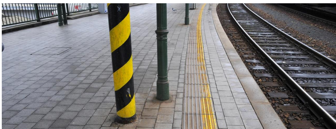
Obrázek 15 Sloupky zastřešení a trakčního vedení u VLVP
