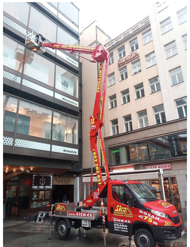
Čištění za pomoci pracovní plošiny
