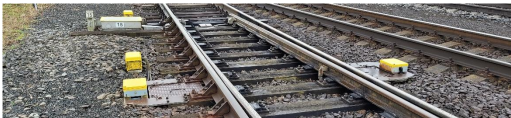
Obr. 4 Výhybka s přestavníkem a snímačem polohy
