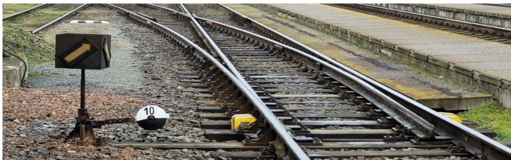
Obr. 5 Ruční výhybka mezi pátou a sedmou kolejí
