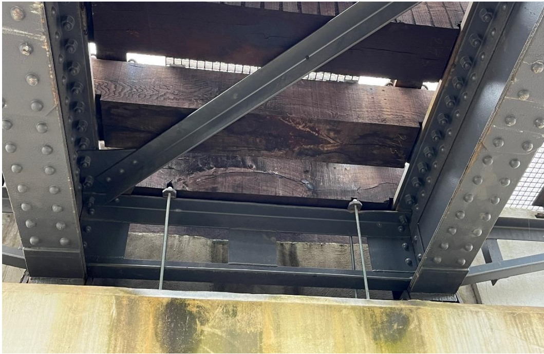
Obrázek 5 – pohled na závitové tyče zamezující svislému posunu
