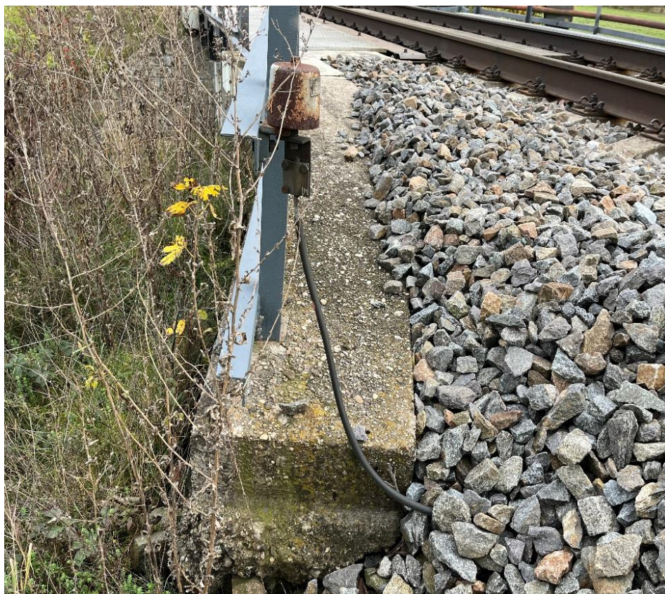
Obrázek 10 – uzemnění zábradlí
