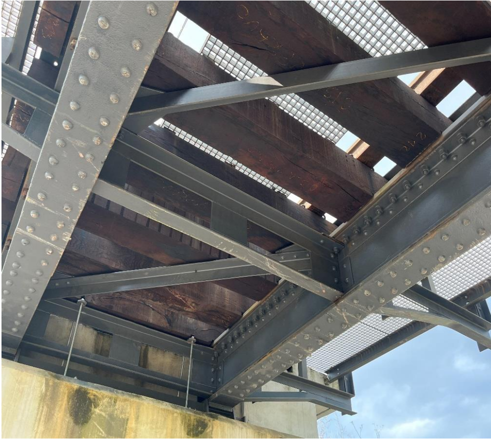
Obrázek 7 – pohled na příčnky a zavětrování
