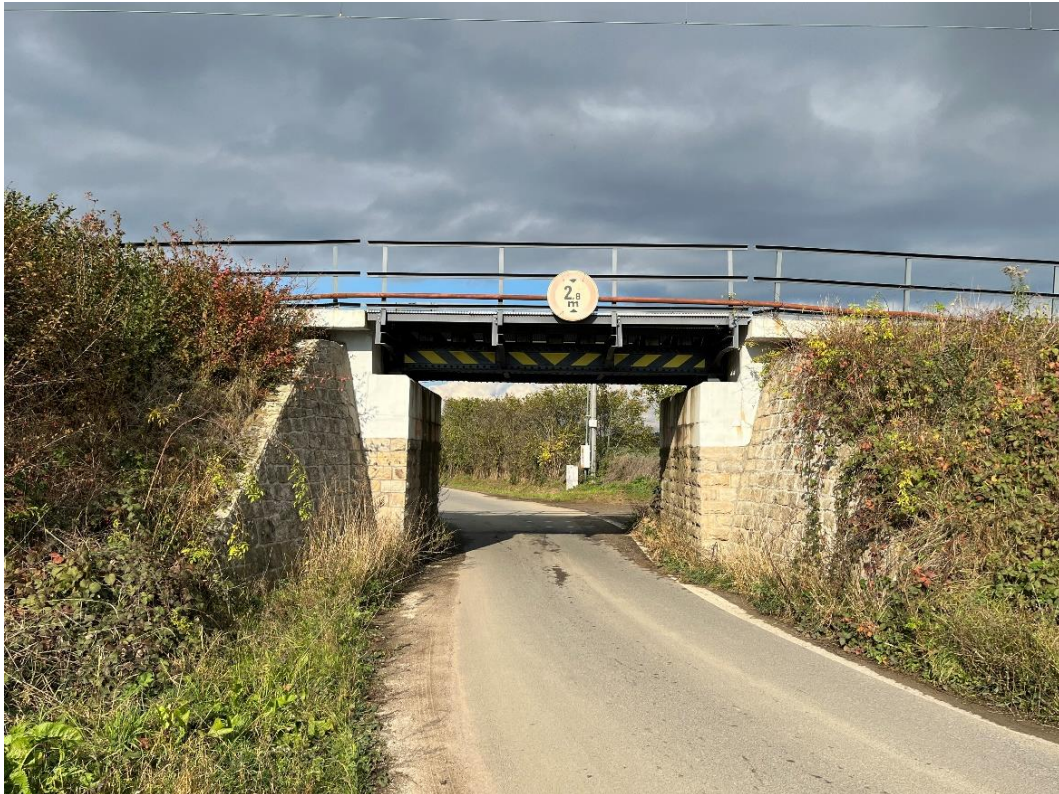
Obrázek 1 – pohled na konstrukci směr Slatina
