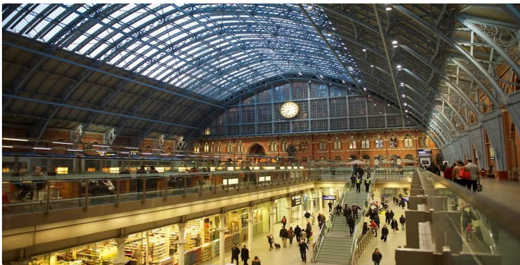
Obr. 30: Nákupní centrum, restaurace a hotel St Pancras International [32]
