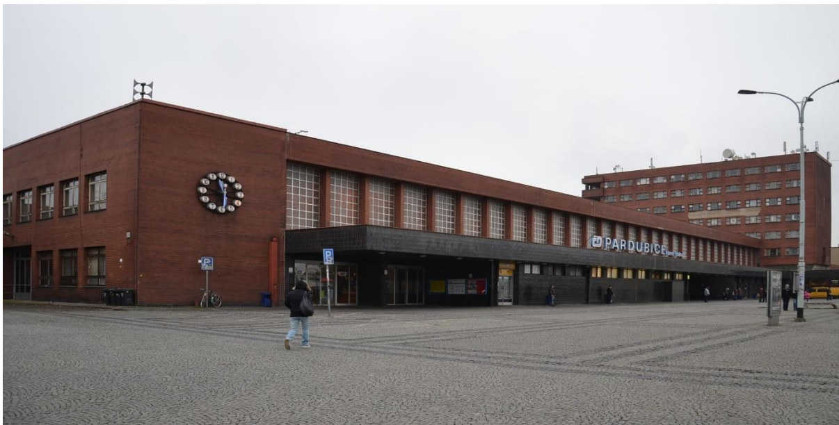
Obr. 36: Pohled na staniční budovu, stanice Pardubice [42]
