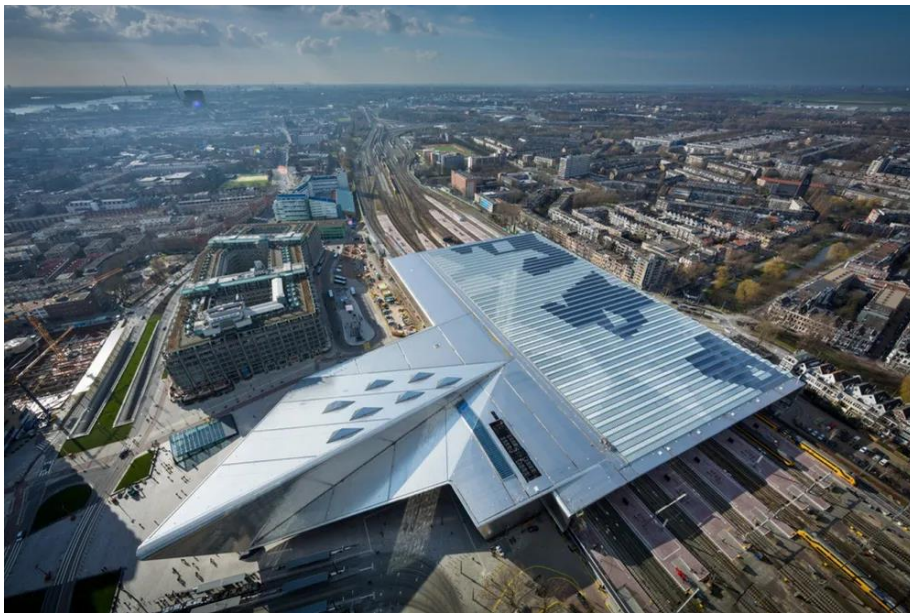
Obr. 32: Rotterdam Centraal Station v Nizozemsku [33]
