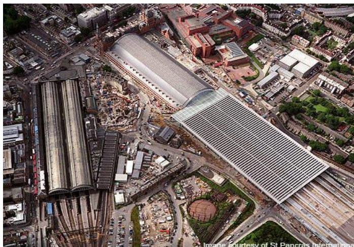
Obr. 34: Letecký pohled na mezinárodní stanici St Pancras [40]
