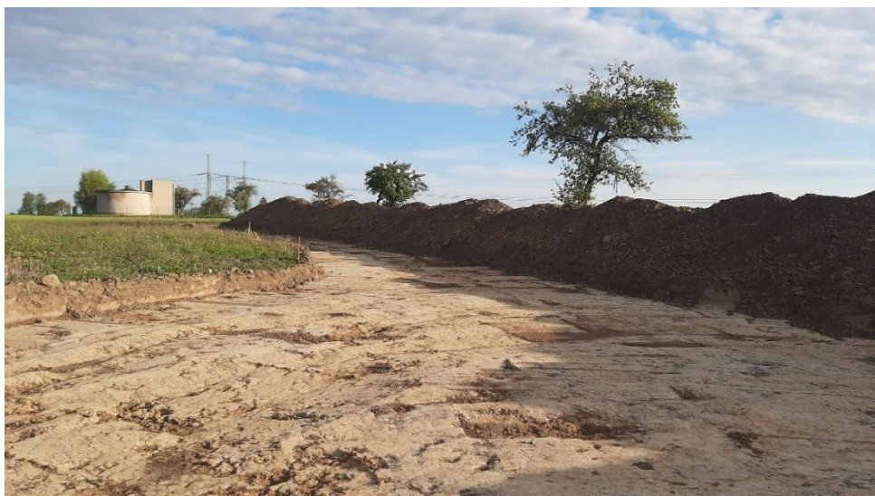
Obrázek F 2: Skrývka ornice podél stávající komunikace II/317
