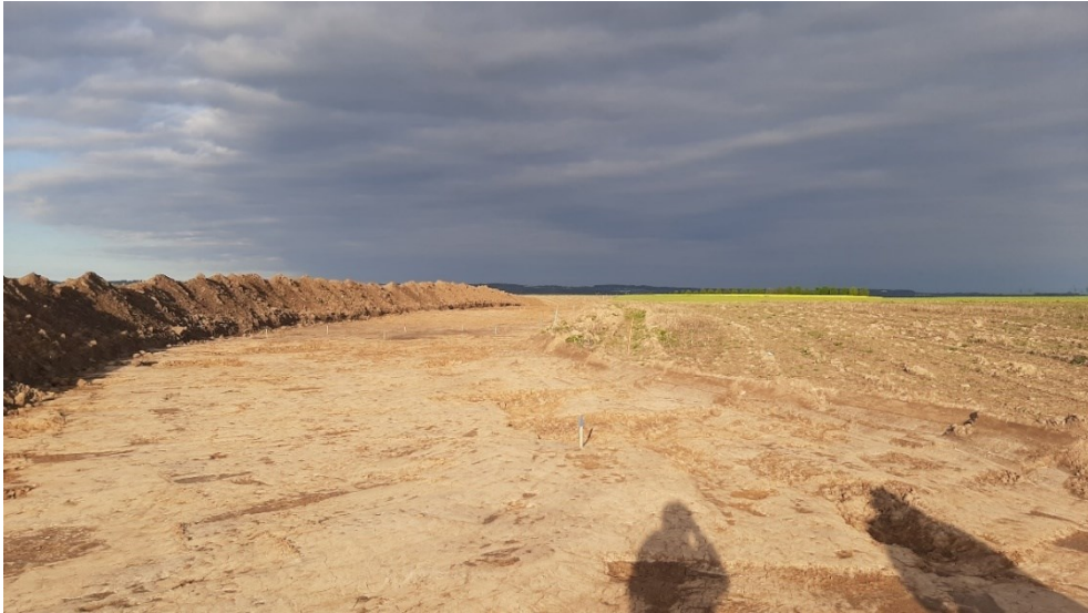
Obrázek F 4: Pohled na úsek 1 terénního průzkumu směr Vysoké Mýto
