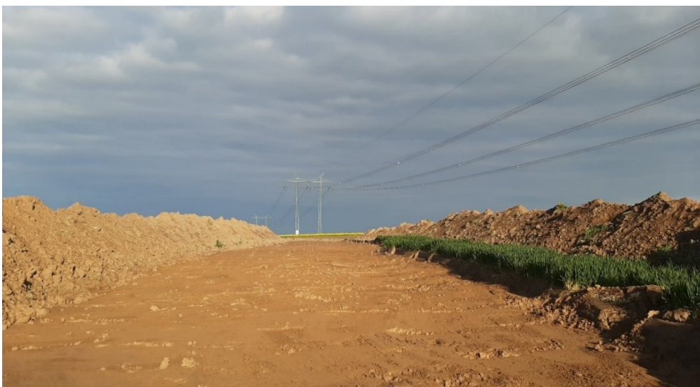
Obrázek F 12: Provedená skrývka ornice na úseku 2
