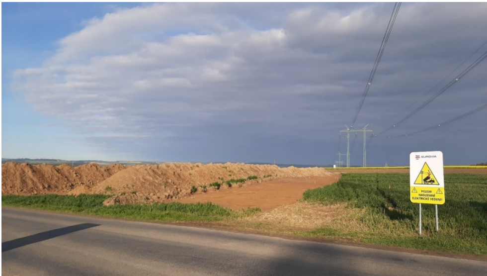
Obrázek F 11: Pohled na úsek 2 směr Vysoké Mýto
