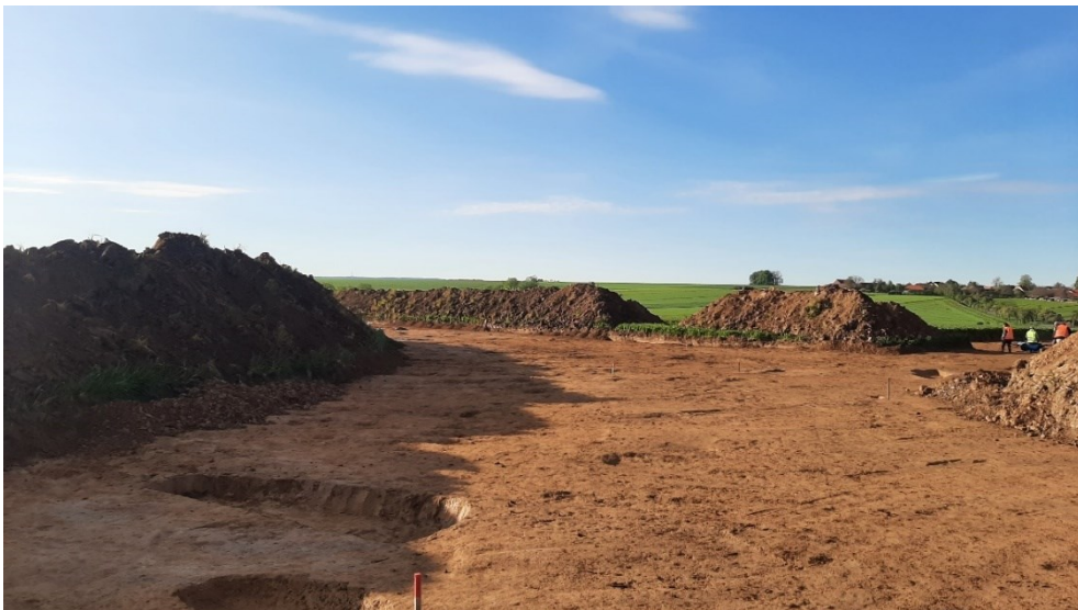
Obrázek F 17: Provedená skrývka, exkavace a pohled na deponie
