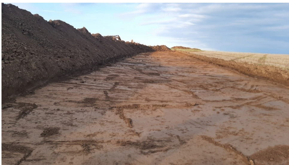
Obrázek F 3: Skrývka ornice v trase budoucí D35
