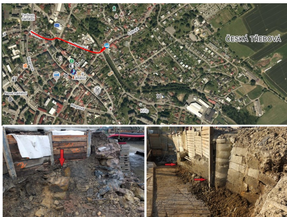
Obrázek 17: Rekonstrukce silnice III/31512 a mostu ev. č. 31512-1 Česká Třebová. Lokalita a fotografie z nálezové zprávy, kde jsou vyznačeny zbytky opěr původního kamenného mostu. [25; 64]
