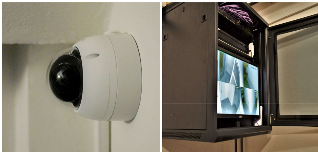
Obrázek 11 - Kamerový systém s ústřednou
