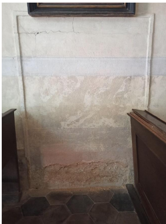
30. Zazděný vstup pod kruchtou na vřetenové schodiště
