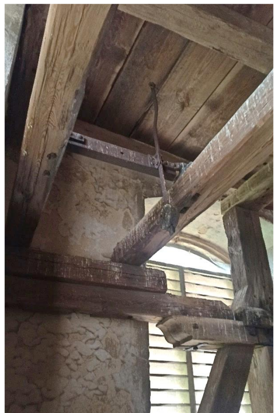
55. Severozápadní roh zvonového patra věže s prostorem pro umístění 4. zvonu
