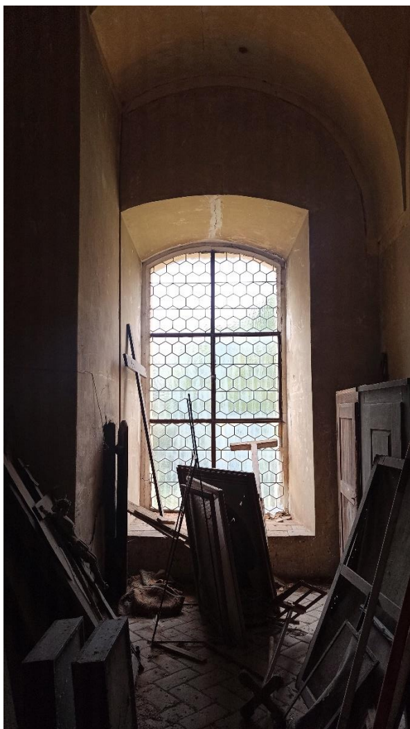
39. První patro věže – pohled k západu
