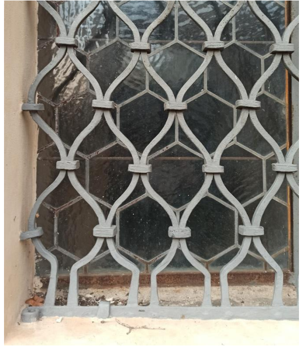
10. Detail okna s mříží na jižním průčelí věže
