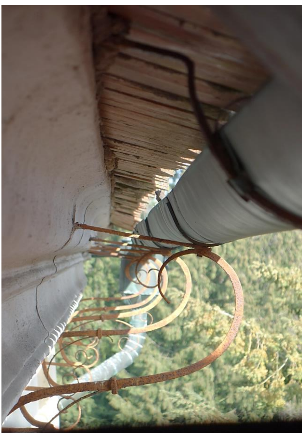
7. Zdobné podpěry okapových žlabů na východním průčelí presbytáře
