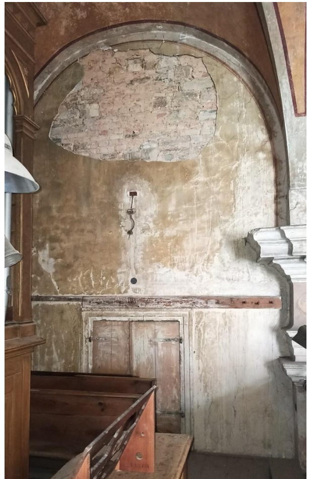
34. Celkový pohled na prostor krucht, zřetelná degradovaná omítka na severní stěně a dvířka do prostoru zaniklého vřetenového schodiště
