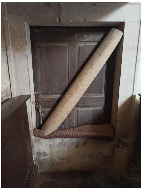
29. Polozazděný vstup pod kruchtou k zaniklému vřetenovému schodišti
