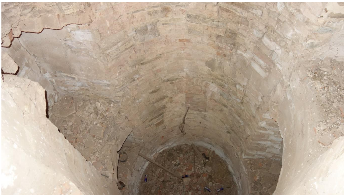
37. Prostor zaniklého vřetenového schodiště – pohled do přízemí, uprostřed zřejmé zazděné okénko
