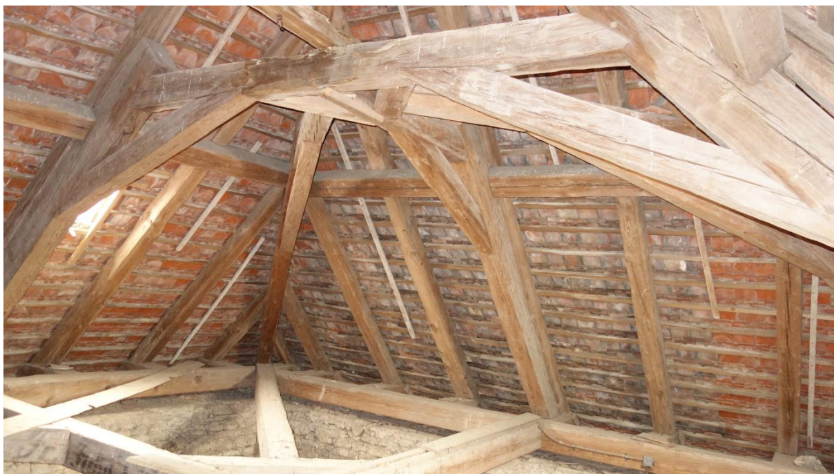
45. Pohled do krovu nad presbytářem
