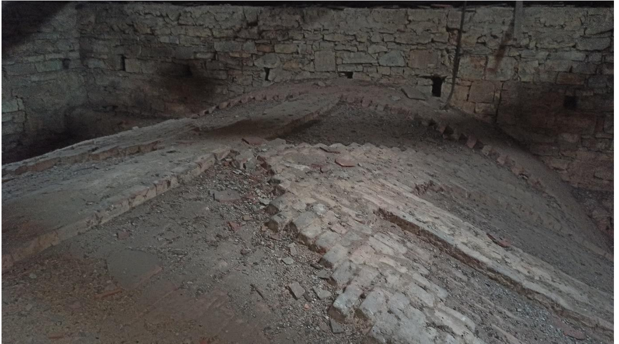
48. Klenba presbytáře a obvodové zdivo s kapsami na půdě kostela
