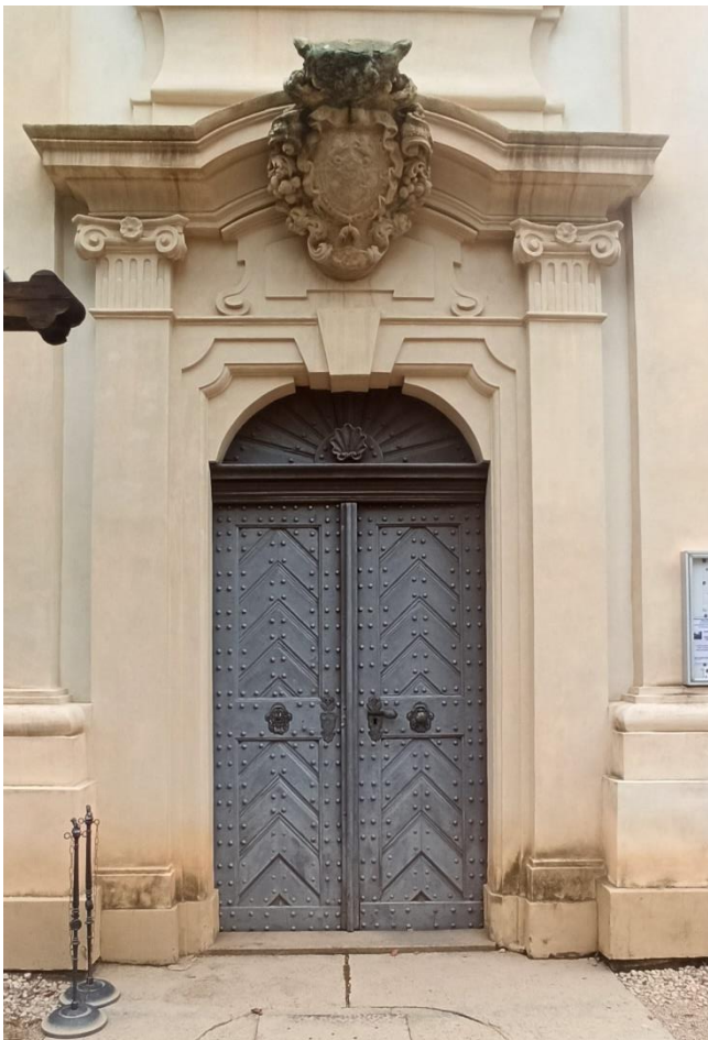
11. Hlavní vstup pod věží s detaily kování
