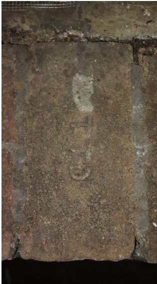
56. Detail parapetu zvonového patra věže – cihla s vyraženou značkou TTD
