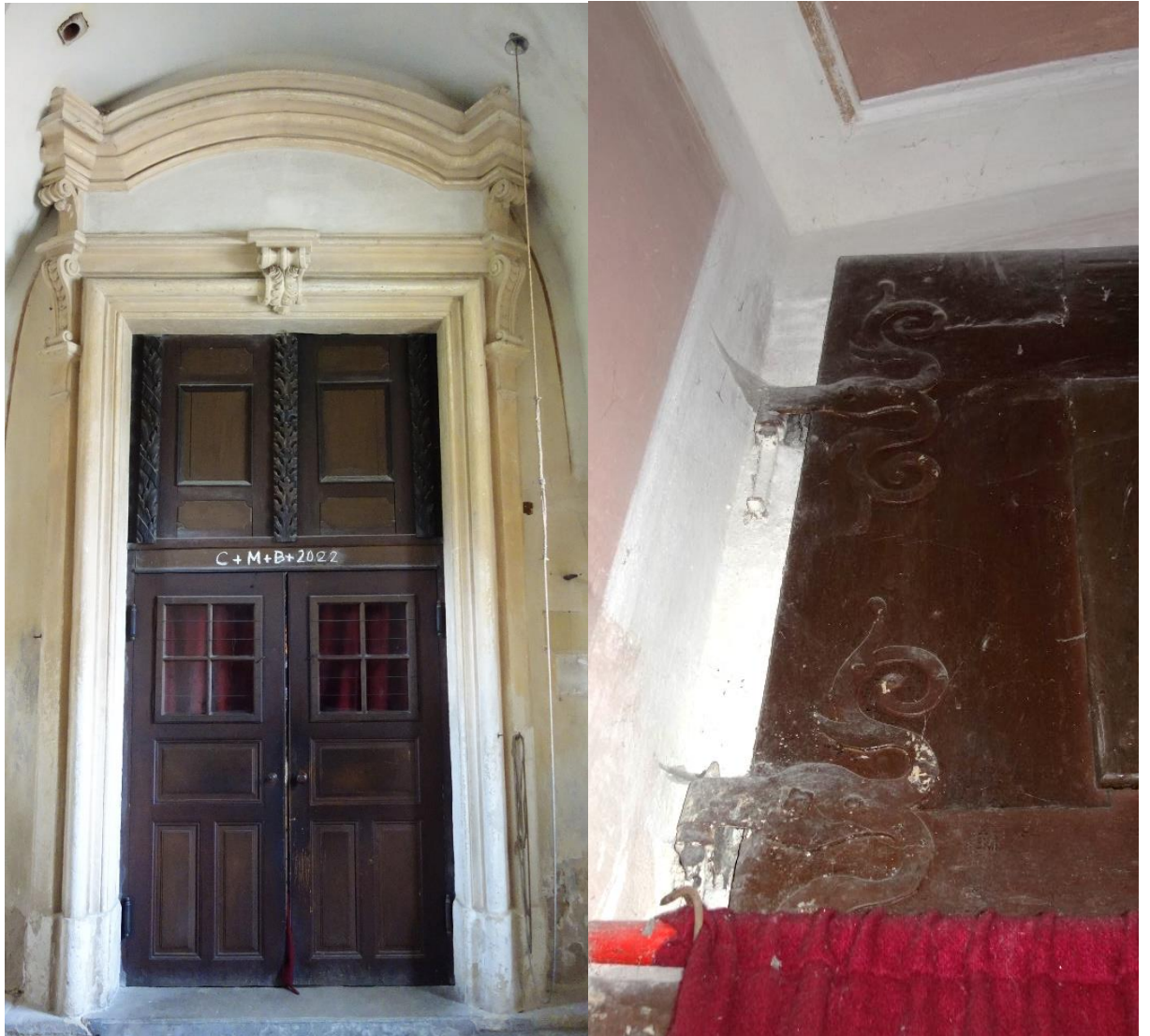
16. Portál v podvěží s detaily kování horního dílu
