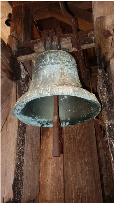
54. Jižní část zvonové stolice – za zvonem šachta pro závaží hodinového stroje
