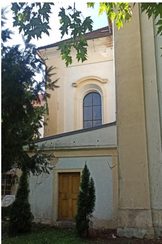
5. Severní průčelí presbytáře a sakristie
