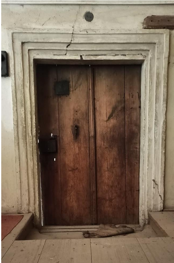
33. Vstup na kruchtu z vřetenového schodiště
