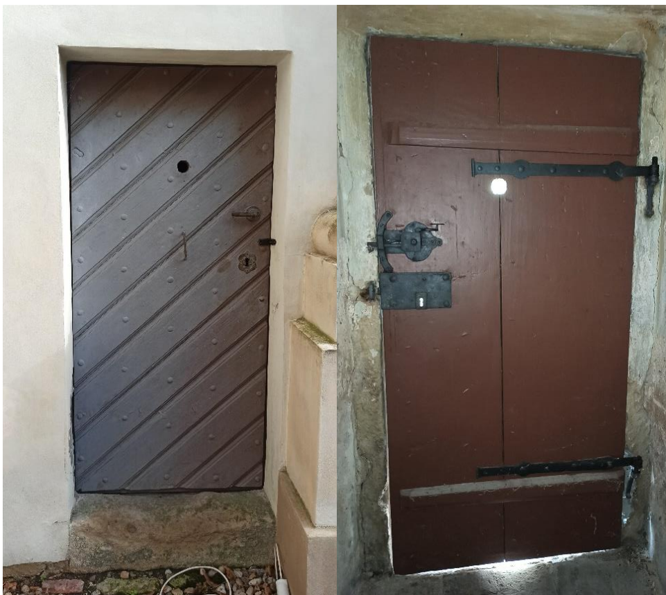
15. Vstup na vřetenové schodiště z exteriéru a interiéru
