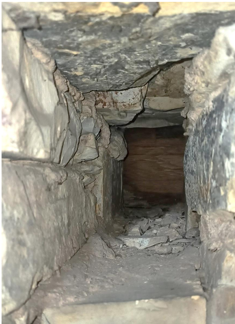
49. Detail jedné z kaps v obvodovém zdivu kostela – zřetelný trámový věnec
