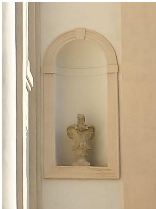
6. Detail niky s pískovcovou vázou na západním průčelí lodi
