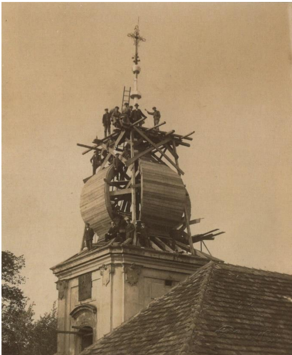
6. Věž kostela během stavby nového krovu, 1923
