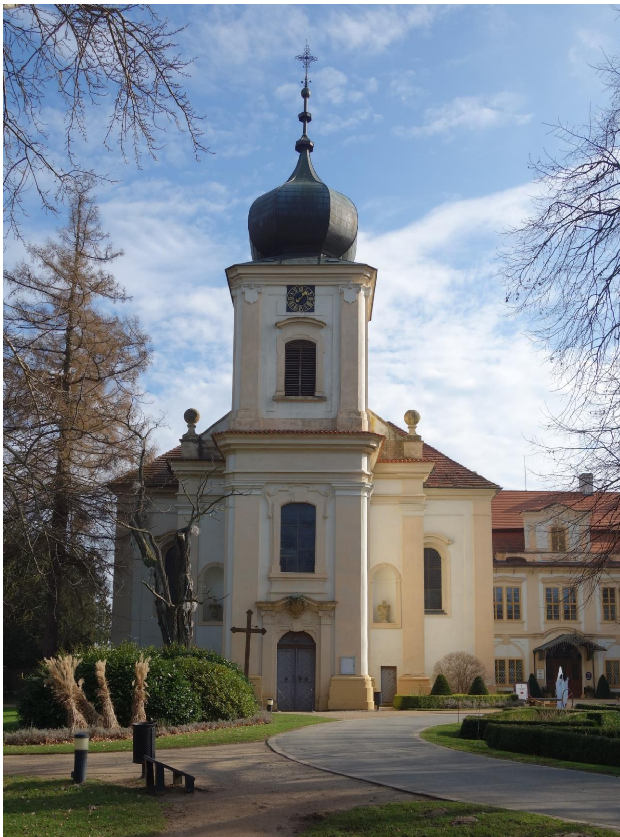
1. Kostel od severozápadu.
