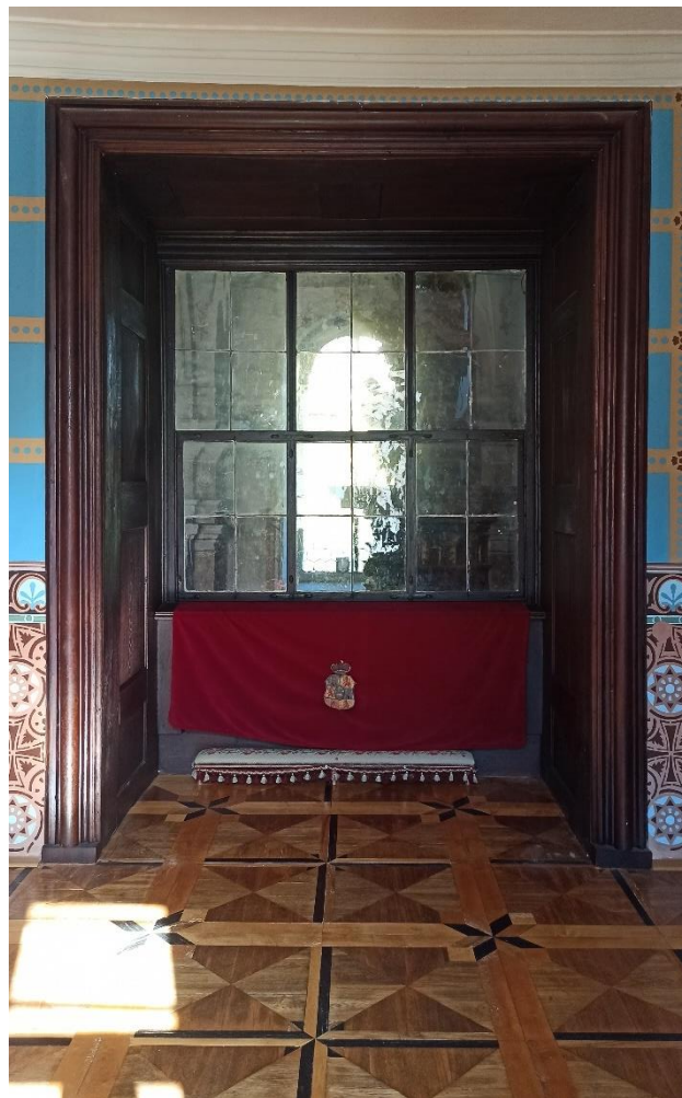
27. Okno horní oratoře z jejího interiéru
