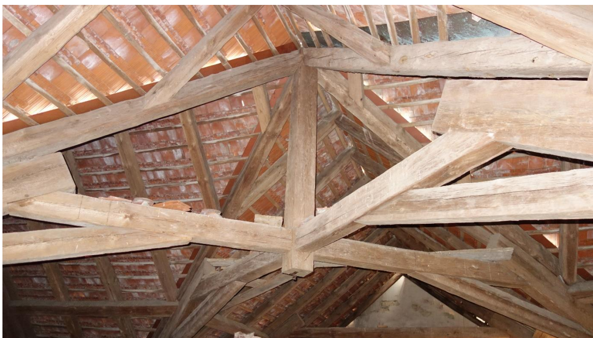
44. Krov nad střední částí lodi od východu
