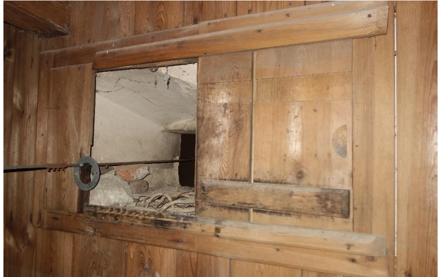
57. Detail obložení prostoru s hodinovým strojem - posuvné okenice
