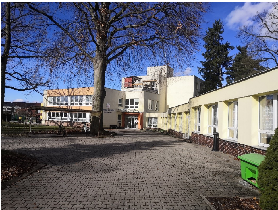
Obrázek 11: nový moderní pavilon domova důchodců v Borohrádku – místo, kde původně stávala tvrz v Borohrádku, pavilon se spojovací chodbou k objektu bývalého zámku pochází z 80. let 20. století, pohled od jihu; vlastní fotografie (24.2. 2024)
