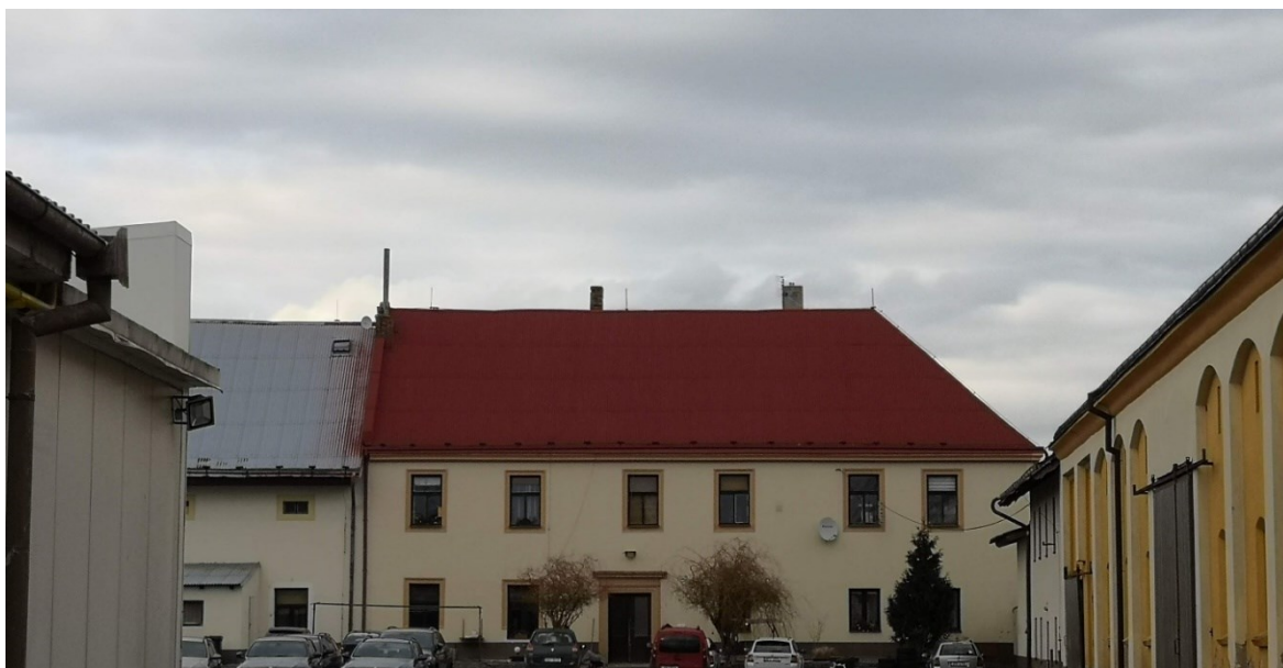
Obrázek 55: zámek Nabočany, jižní průčelí, dnes součástí komplexu ZD, Nabočany č.p. 61; vlastní fotografie (17.2.2024)
