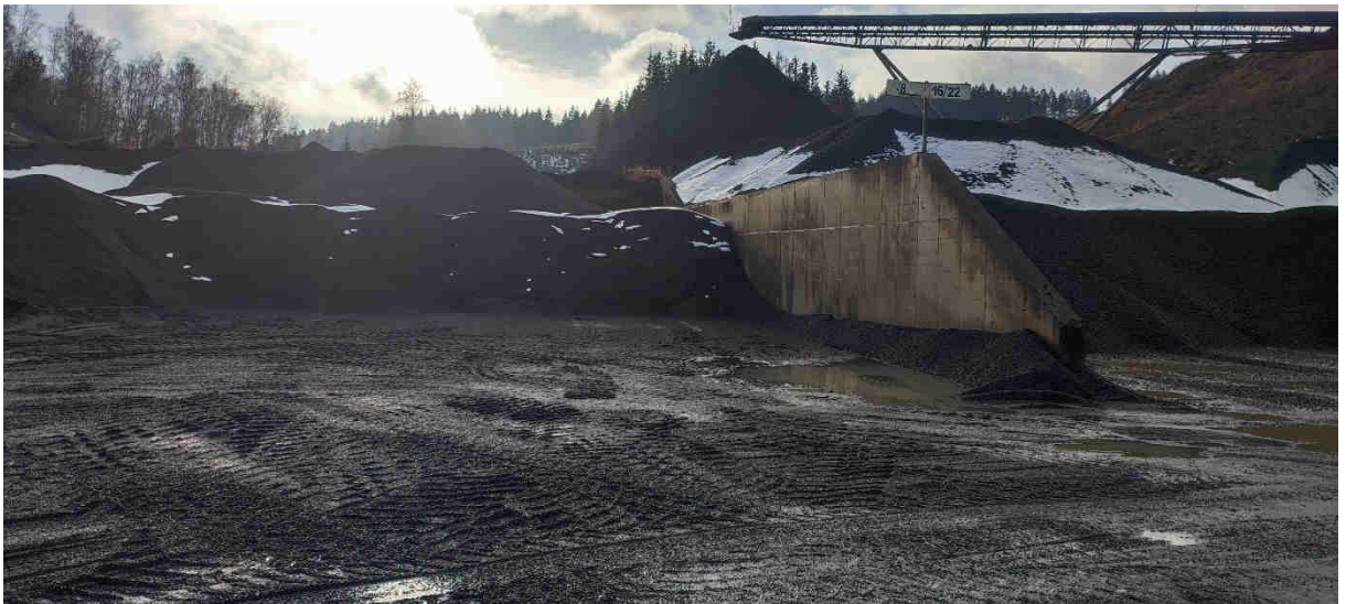
Obrázek 8 – stávající skladovací box – pohled na opěrnou stěnu (zdroj: vlastní fotografie )
