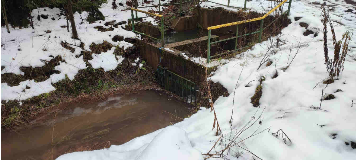
Obrázek 15 – stávající vtokový objekt - pohled na vtok a česle (zdroj: vlastní fotografie )
