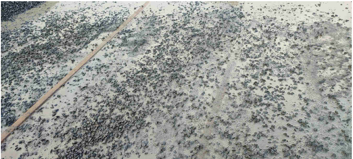
Obrázek 6 – stávající skladovací box – pohled na kolejnice (zdroj: vlastní fotografie )
