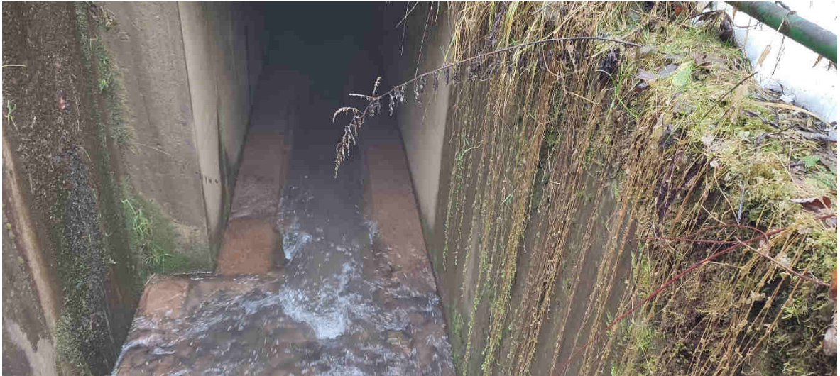
Obrázek 13 - stávající vtokový objekt - vstup dostávajícího zatrubnění (zdroj: vlastní fotografie )
