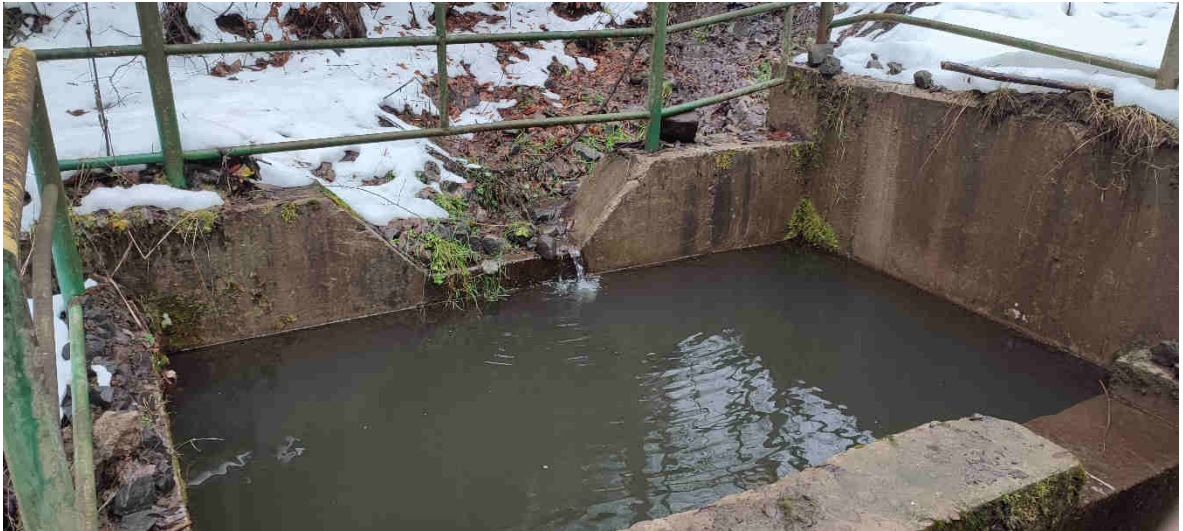
Obrázek 14 – stávající vtokový objekt - napojení rigolu do záchytné jímky (zdroj: vlastní fotografie )
