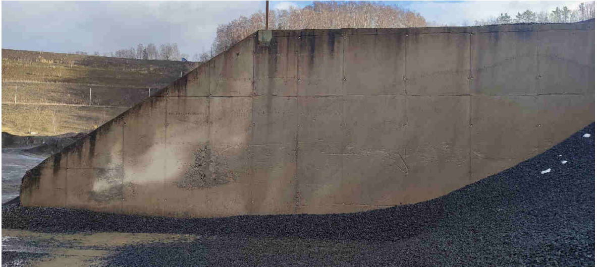
Obrázek 7 – stávající skladovací box – pohled na opěrnou stěnu (zdroj: vlastní fotografie )
