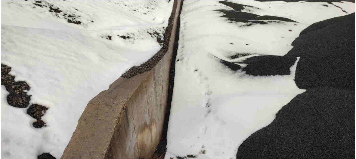
Obrázek 5 – stávající skladovací box – pohled na opěrnou stěnu shora (zdroj: vlastní fotografie )
