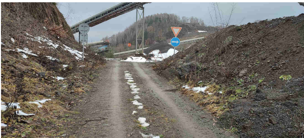
Obrázek 10 – Napojení komunikace – pohled od koryta (zdroj: vlastní fotografie )
