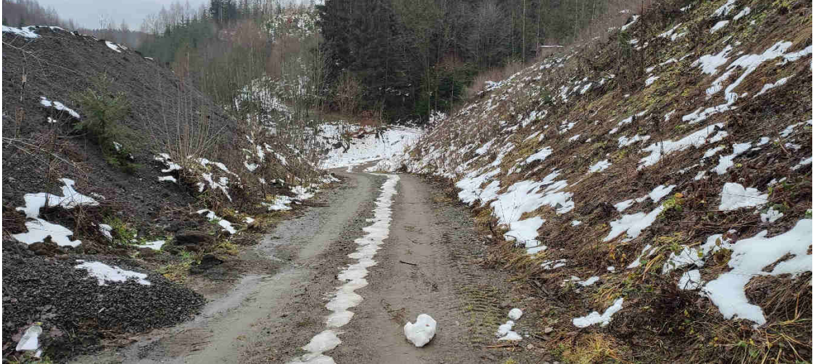
Obrázek 11 – Napojení komunikace – pohled ke korytu (zdroj: vlastní fotografie )
