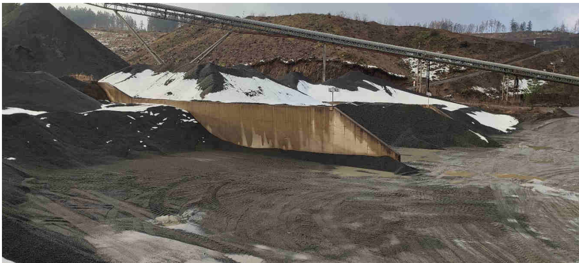
Obrázek 3 – stávající skladovací box – pohled na opěrnou stěnu (zdroj: vlastní fotografie )
