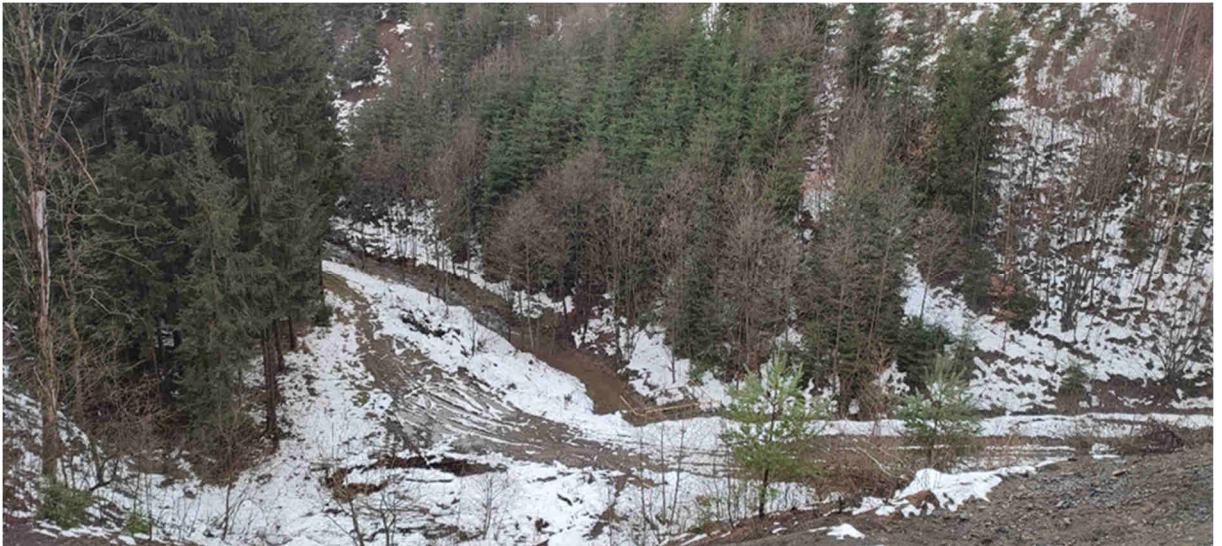
Obrázek 12 - stávající vtokový objekt a stávající koryto (zdroj: vlastní fotografie )
