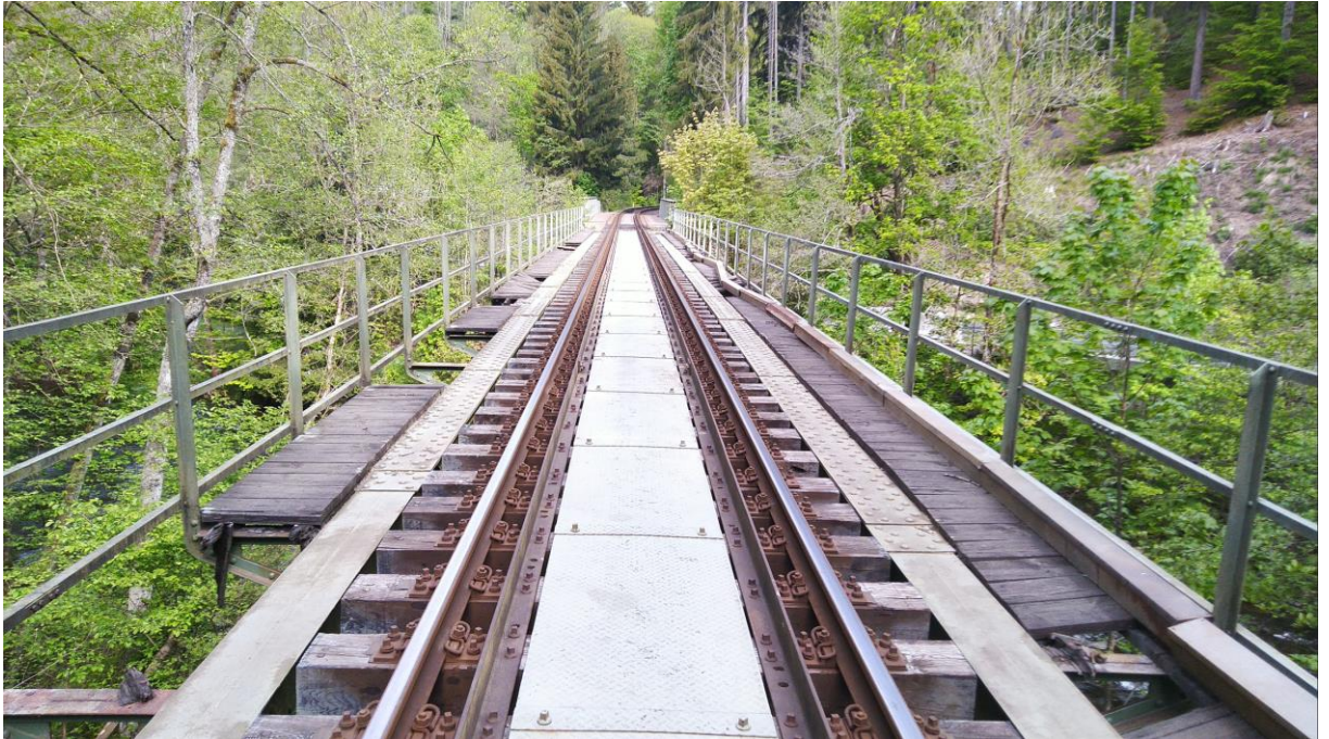
Obrázek 1 Pohled na mostní svršek
