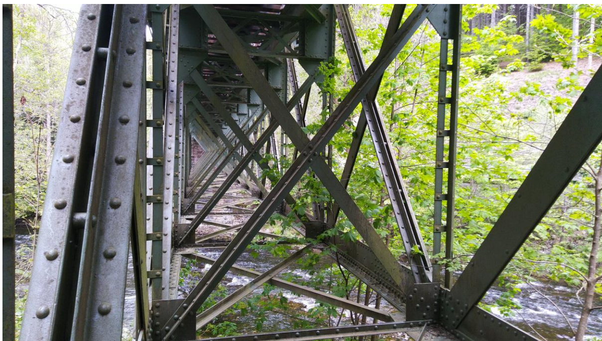
Obrázek 3 Pohled na příhradovinu mostu zevnitř
