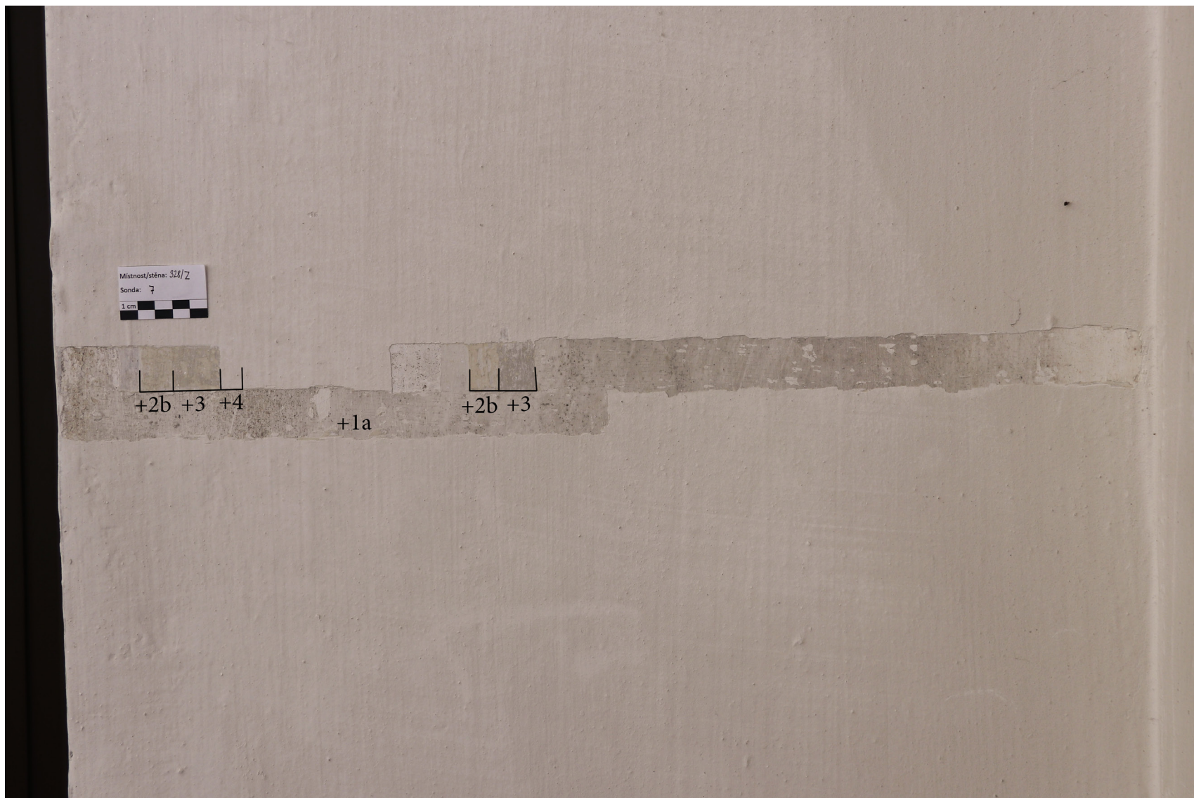
Obr. 18: Sonda č. 7, západní stěna místnosti č. 328.
