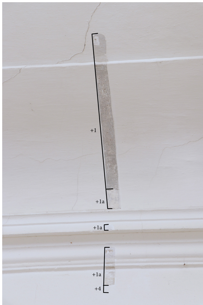
Obr. 07: Sonda č. 3b a 3c, východní stěna míst- nosti č. 328.
