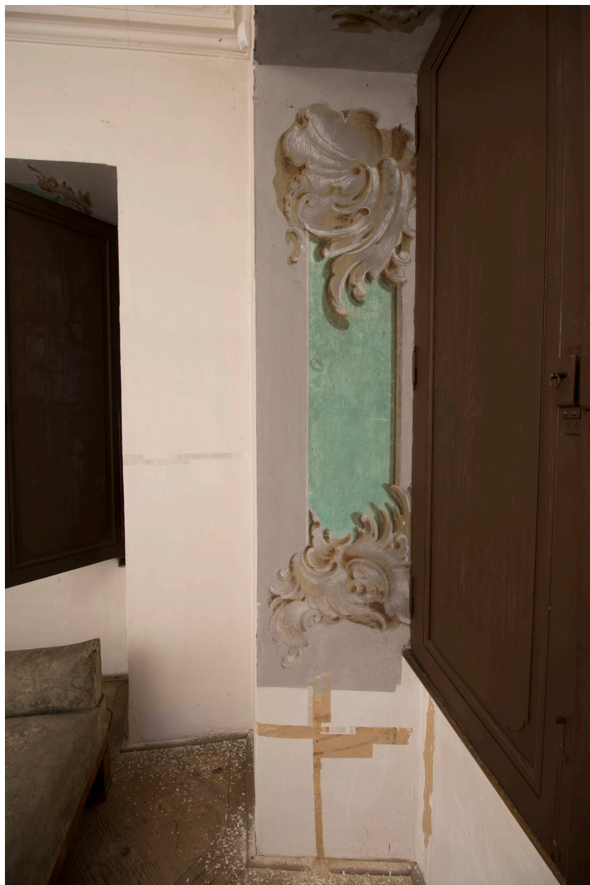
Obr. 04: Pohled na západní špa- letu severního okna v míst- nosti č. 328 v rozptýleném umělém bílém světle.
