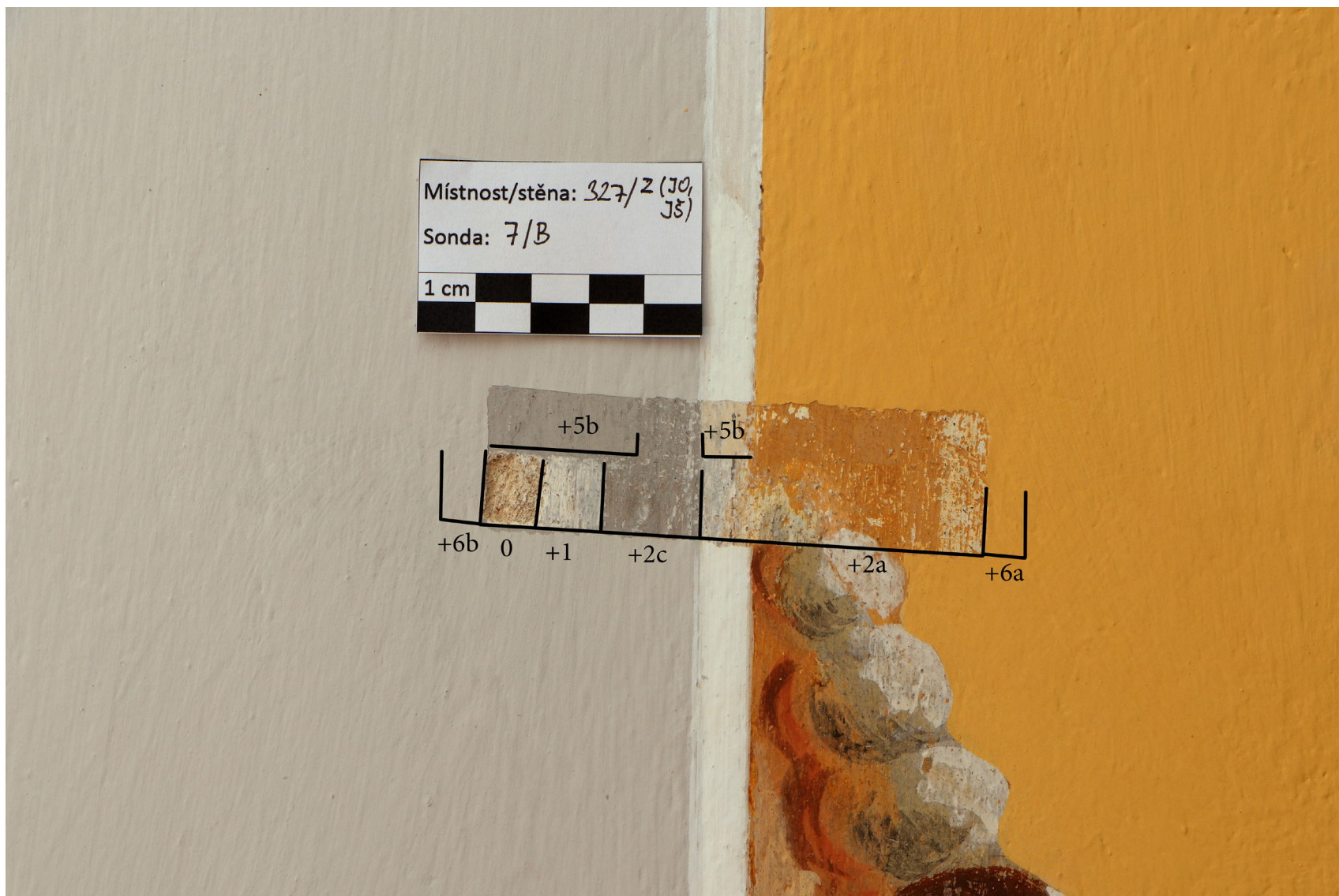
Obr. 37: Sonda č. 7b, západní stěna míst- nosti č. 327, severní okno, jižní okenní špaleta.
