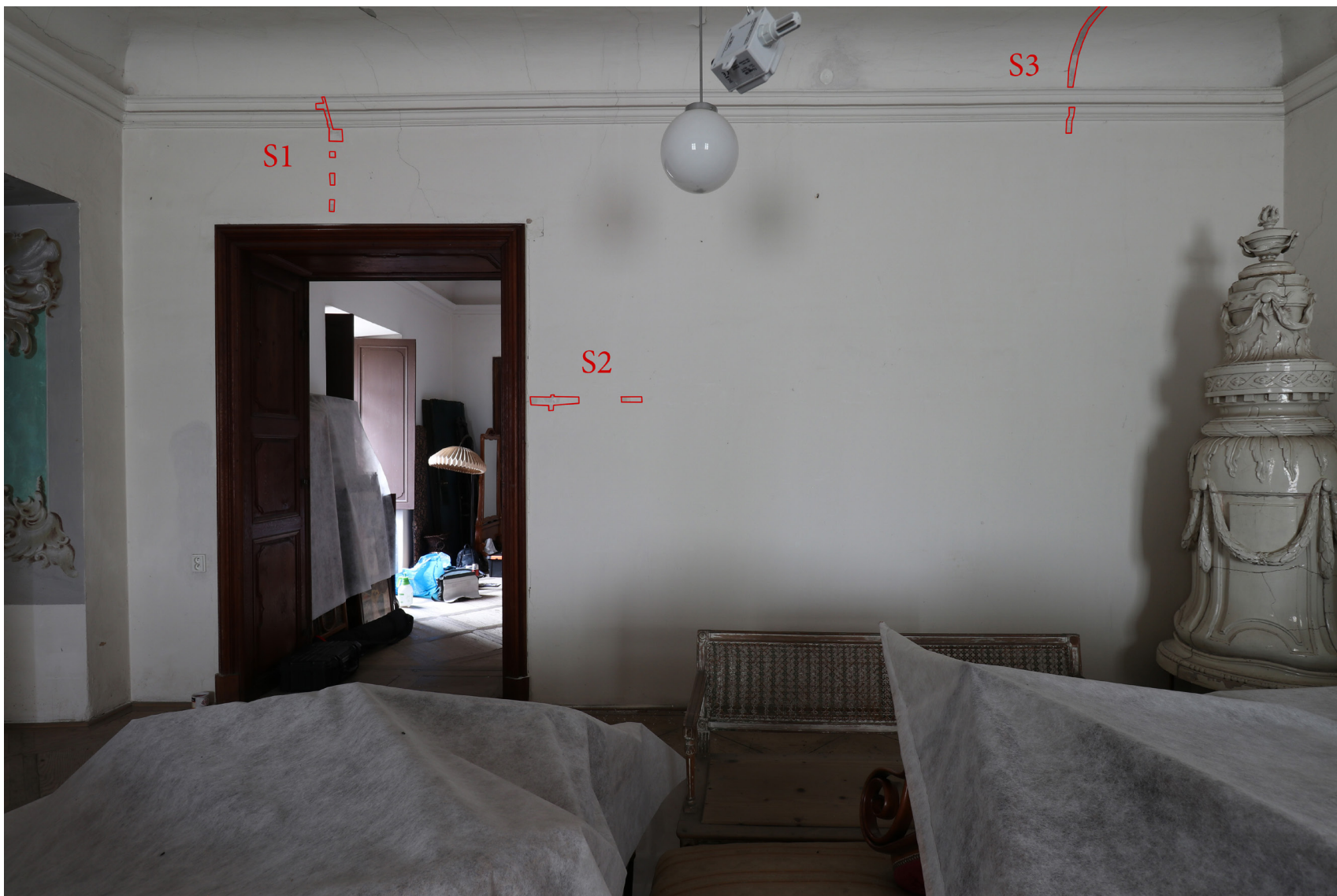
Obr. 01: Grafické vy- značení sond, východní stě- na místnosti č. 328.
