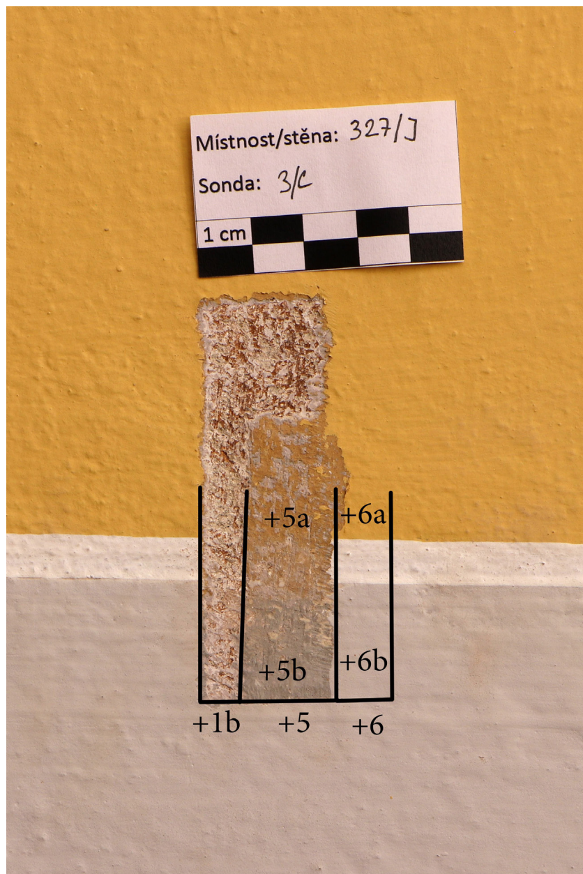
Obr. 32: Sonda č. 3c, jižní stěna místnosti č. 327.
