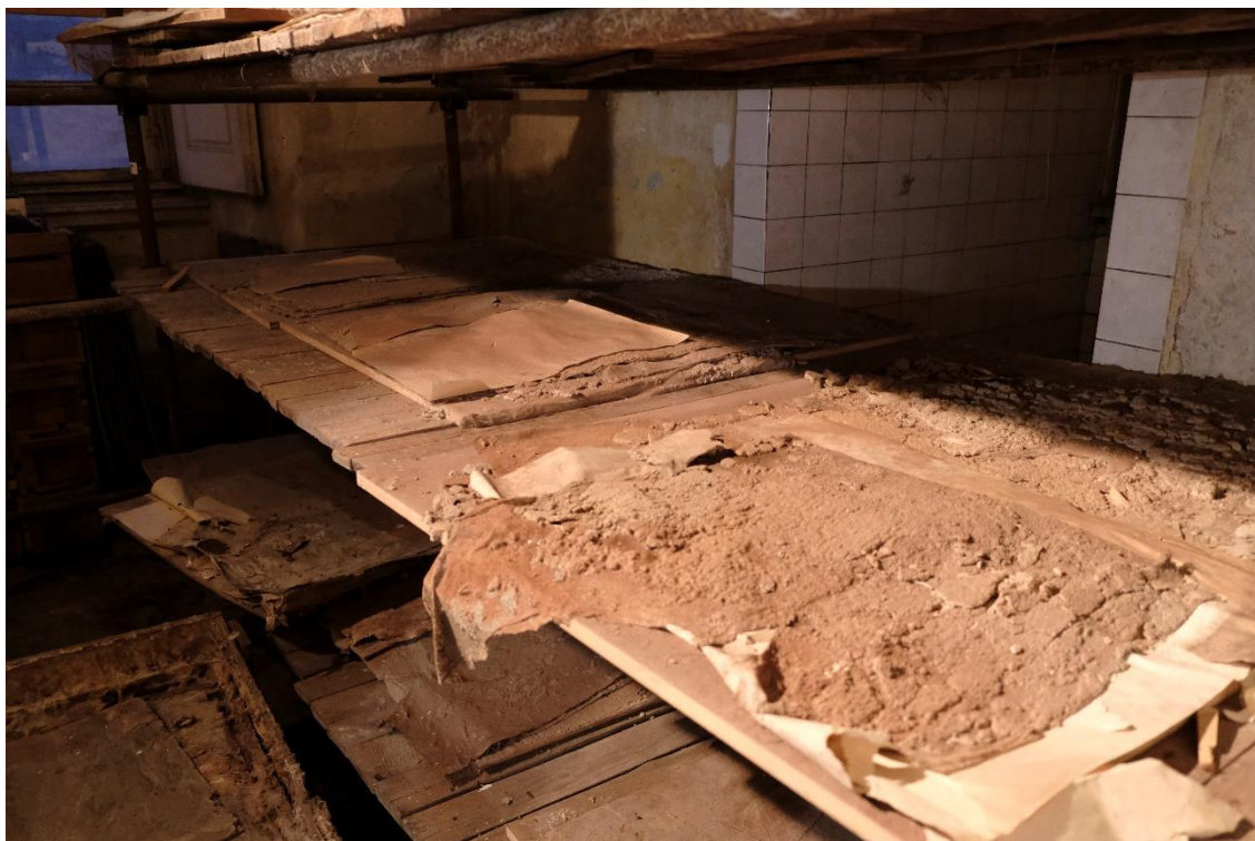
Obr. 4 Stav transferů na lešení v místnosti 1 – zaprášené, popraskané a rozpadlé
