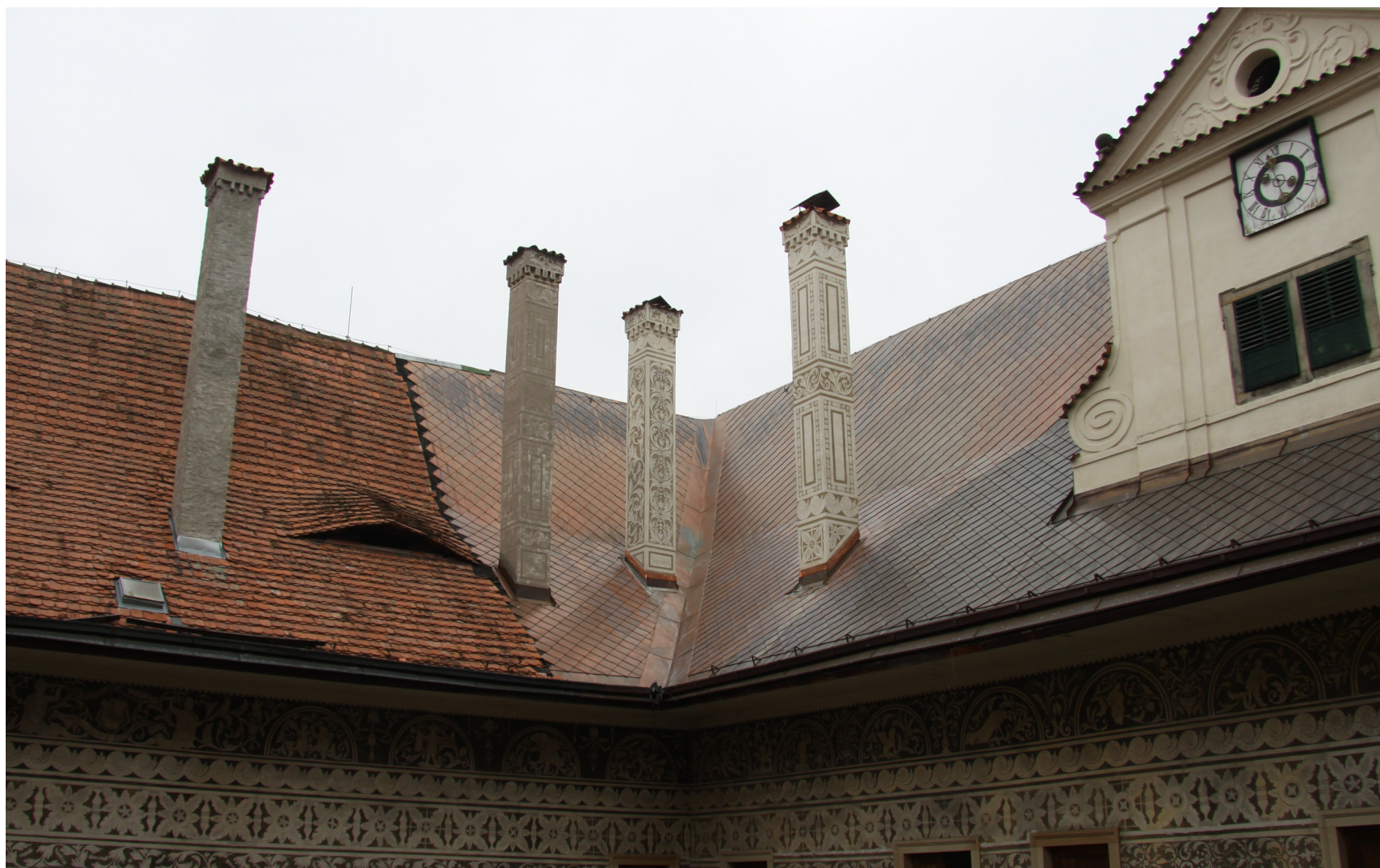
Obr. 88: Pohled na komíny v severozápadním koutu nádvoří. Stav po restaurování a rekonstrukci sgrafitové výzdoby.
