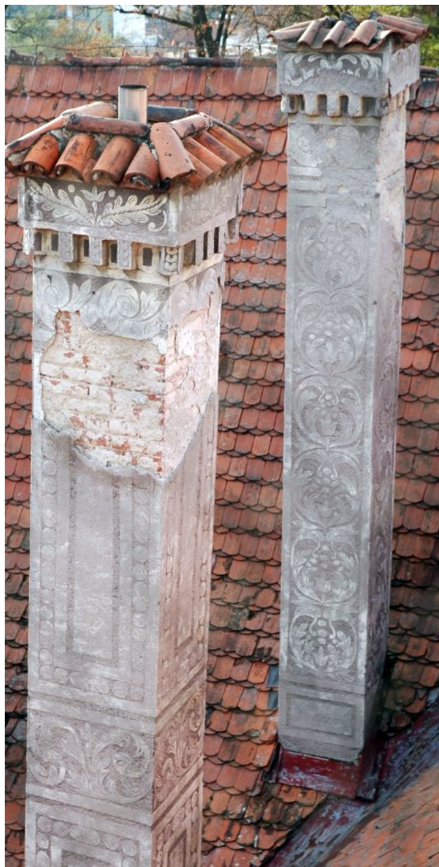
Obr. 05: Komíny č. 1 a 2. Stav v roce 2014. Komín č. 1 před stržením. Foto J. Červinka.
