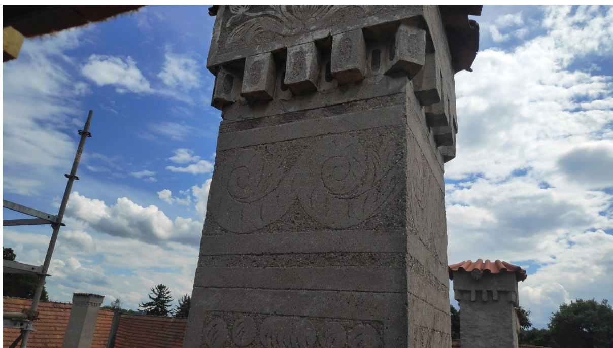
Pohled na hlavu komína
