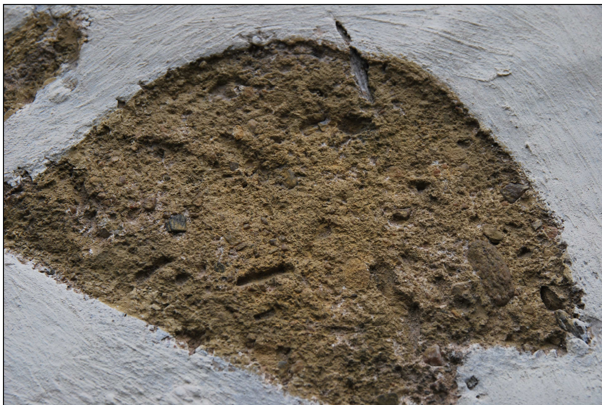
Detail textury původního sgrafita z vnějšího pláště s kobercovým ornamentem
