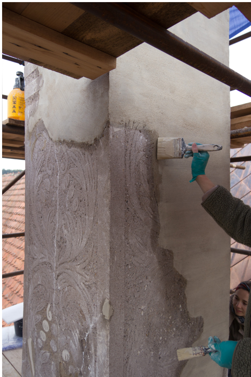
Obr. 58: Komín č. 2, jižní a východní strana v průběhu nanášení intonaca bianca na rekonstruované části.
