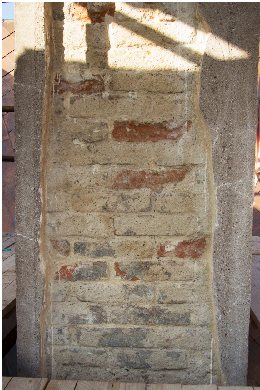
Obr. 48: Komín č. 2, jižní strana, detail po odstranění nesoudržné omítky, strukturálním zpevnění, injektáži a zajištění okrajů defektu tmelením.
