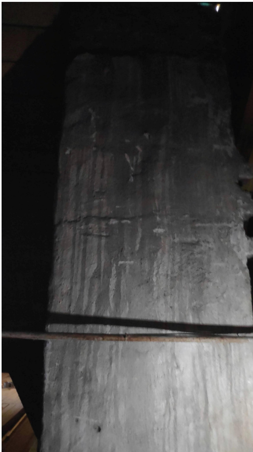
Pohled na komín v půdním prostoru bez viditelných poruch
