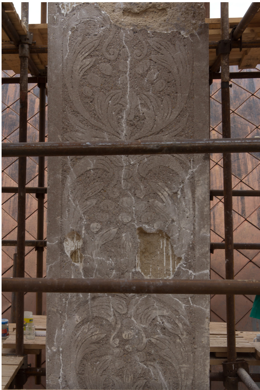
Obr. 50: Komín č. 2, východní strana, po strukturálním zpevnění a injektáži.
