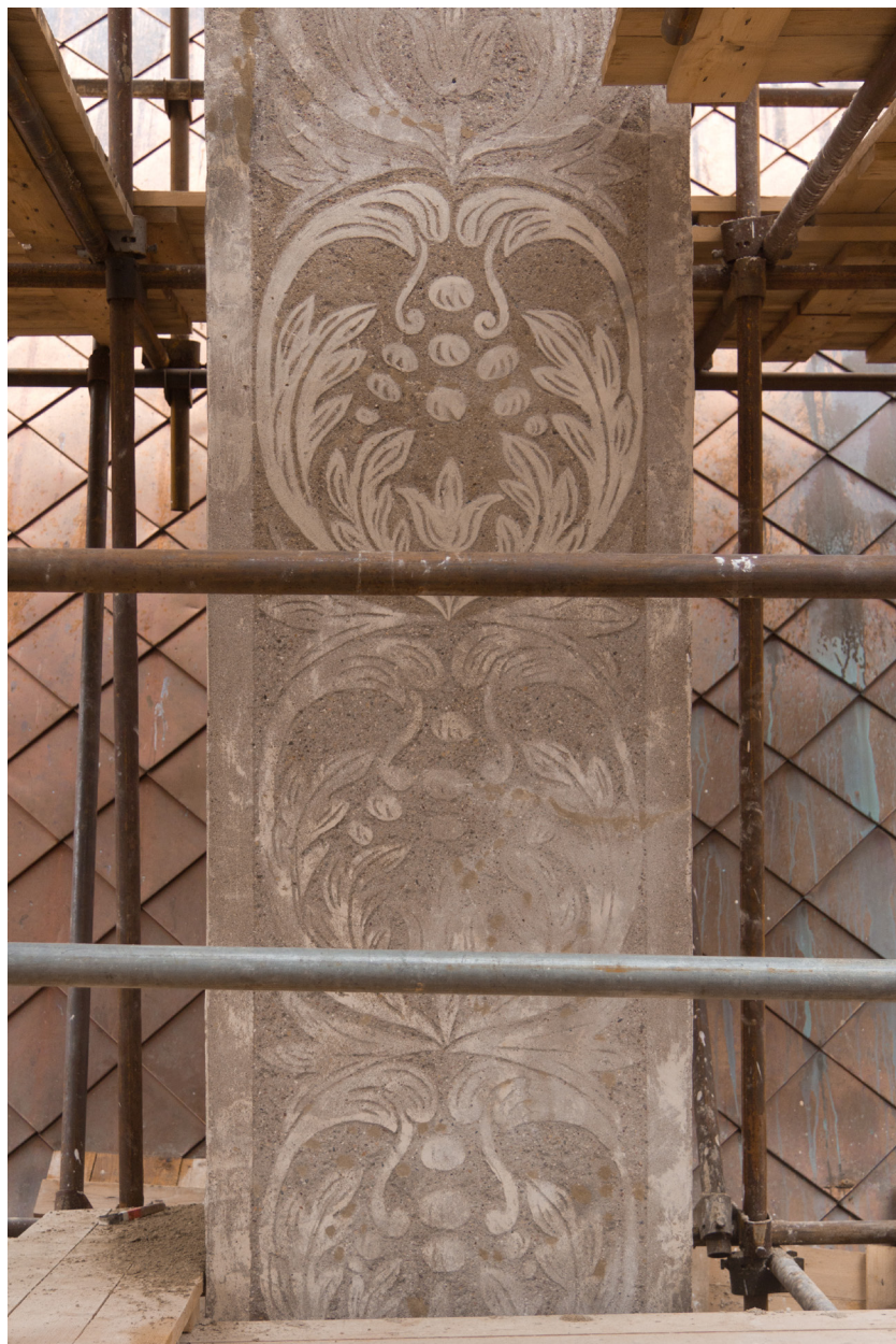
Obr. 66: Komín č. 2, východní strana. Stav po konzervaci, vytmelení defektů a provedení rekonstrukce chybějících částí.
