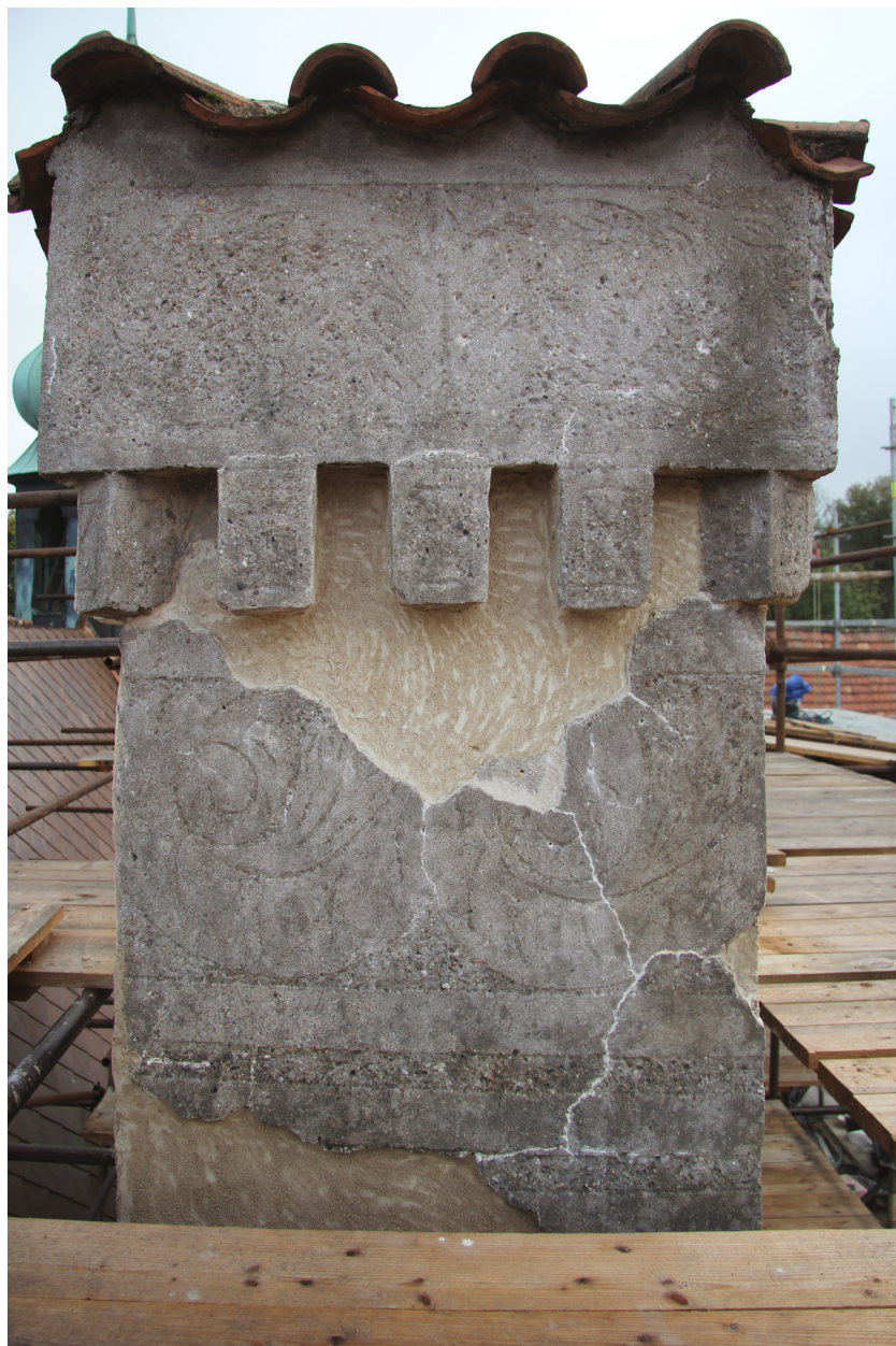
Obr. 56: Komín č. 2, západní strana, stav po vytmelení defektu jádrovu omítkou.
