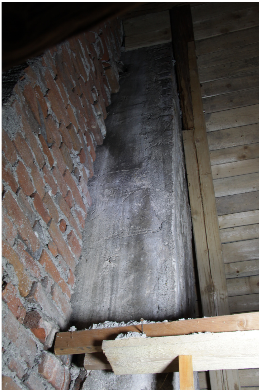
Obr. 92: Část původní sgrafitové výzdoby na zrušeném komínovém tělese, foto v bočním světle. Z výzdoby je patrná část stylizované mořské vlny a perlovce.
