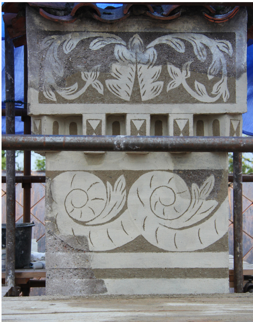
Obr. 64: Komín č. 2, východní strana. Stav po konzervaci, vytmelení defektů a provedení rekonstrukce chybějících částí.
