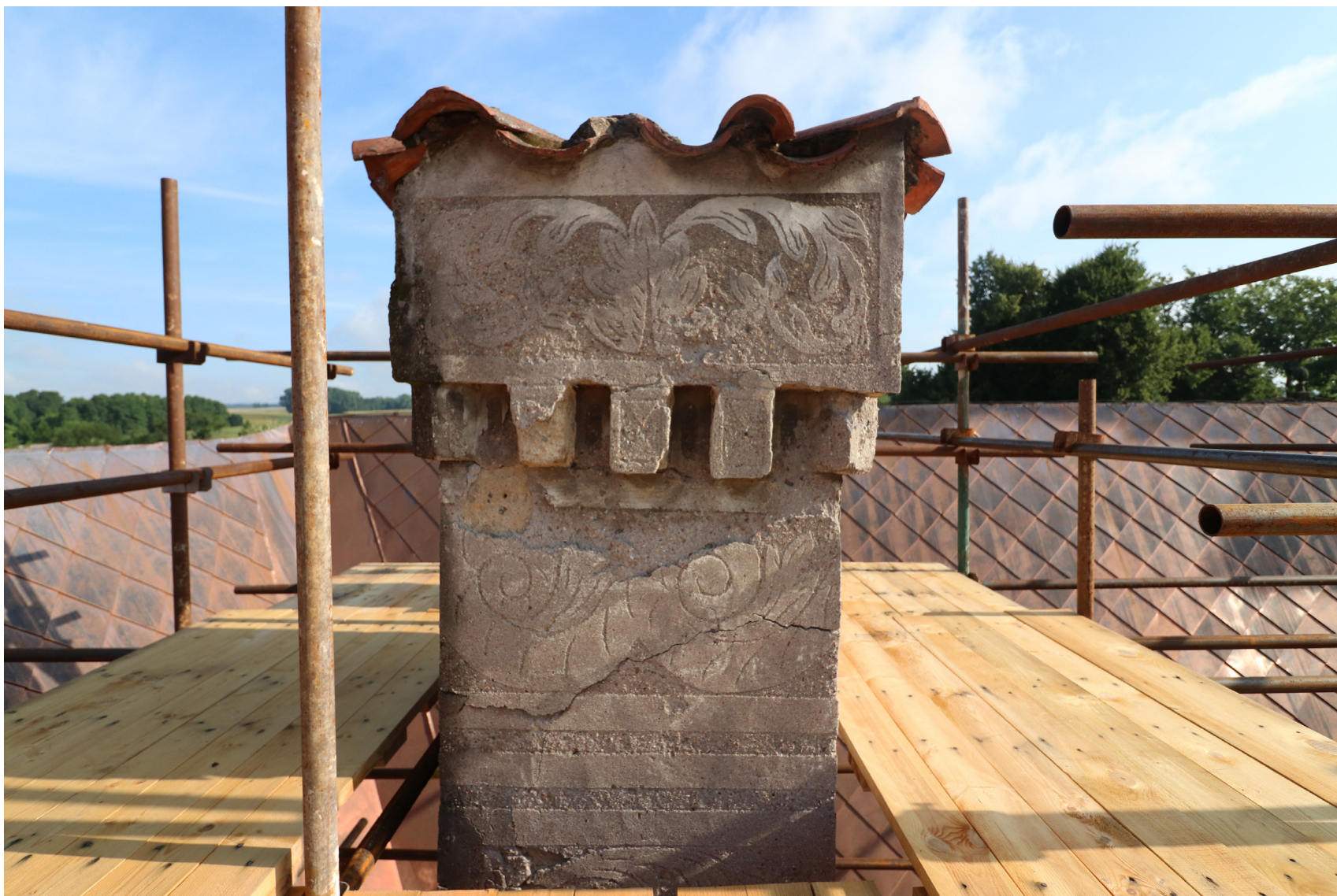
Obr. 20: Horní část komínu č. 2, jižní strana. Stav před restaurováním.
