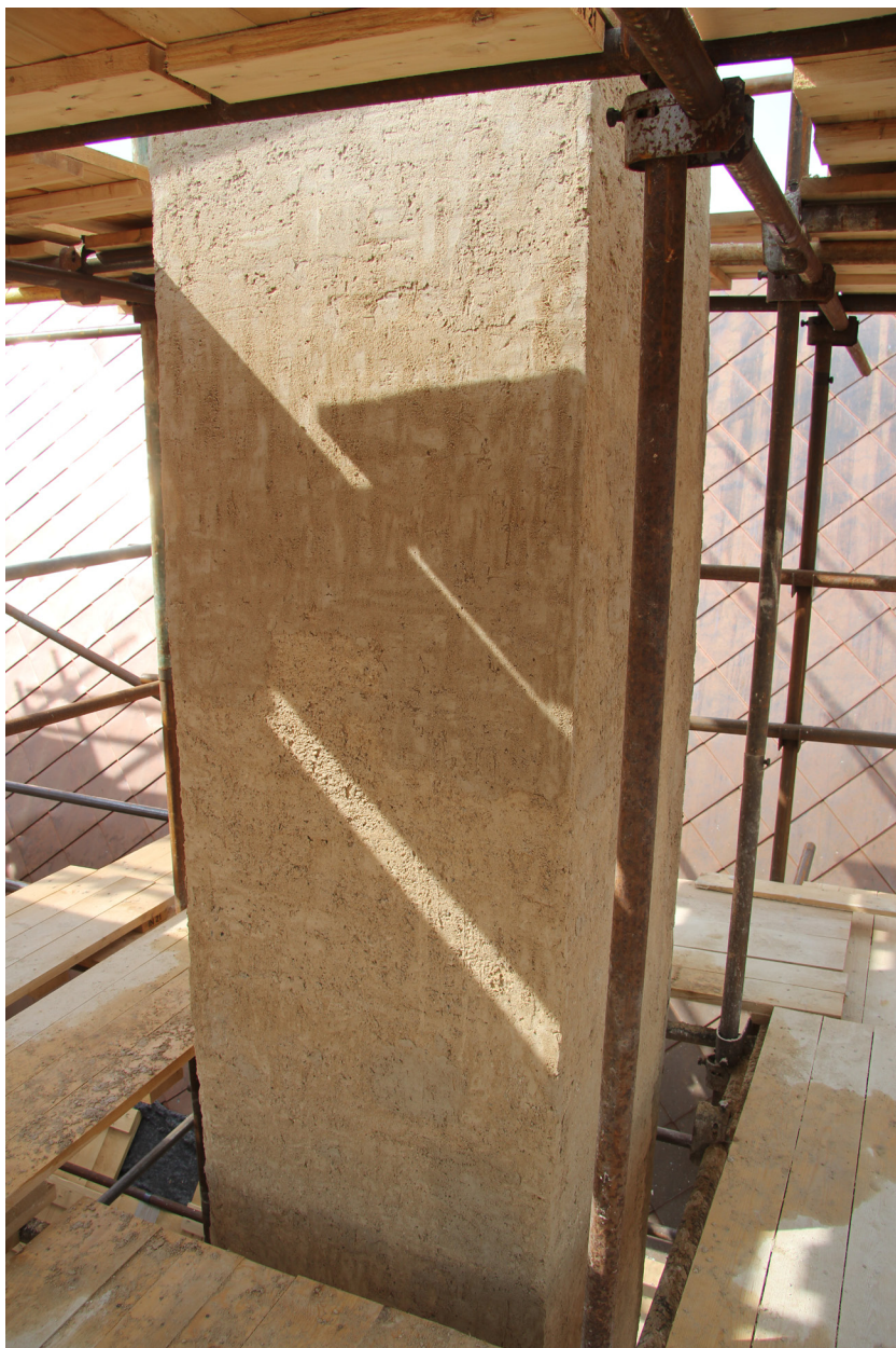
Obr. 07: Střední část znovu postaveného komínu č. 1 omítnutá jádrovou omítkou.
