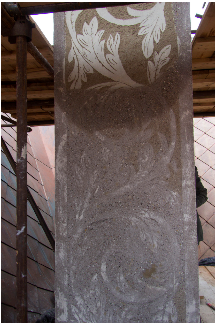
Obr. 62: Komín č. 2, jižní strana. Stav po konzervaci, vytmelení defektů a provedení rekonstrukce chybějících částí.
