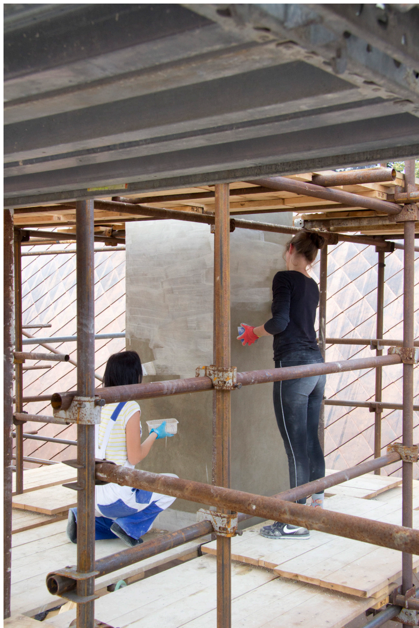
Obr. 09: Průběh rekonstrukce sgrafitové výzdoby na komínu č. 1. Nanášení intonaca bianca.
