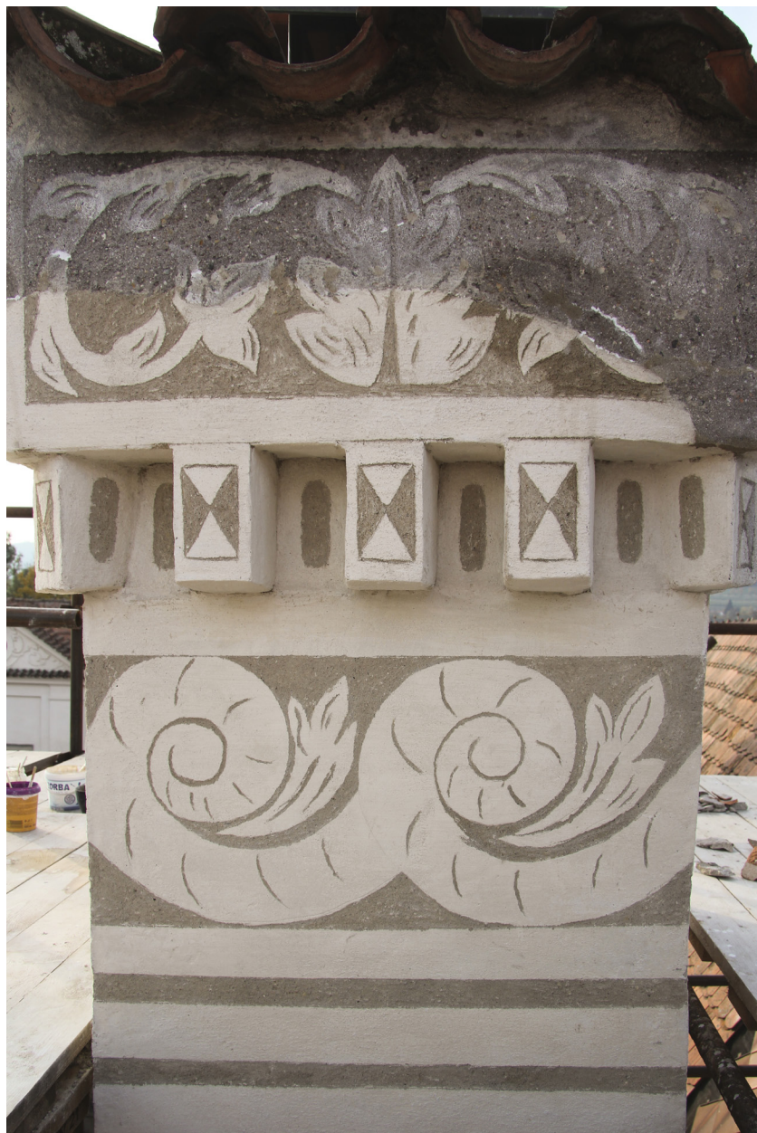
Obr. 72: Komín č. 2, severní strana. Stav po konzervaci, vytmelení defektů a provedení rekonstrukce chybějících částí.
