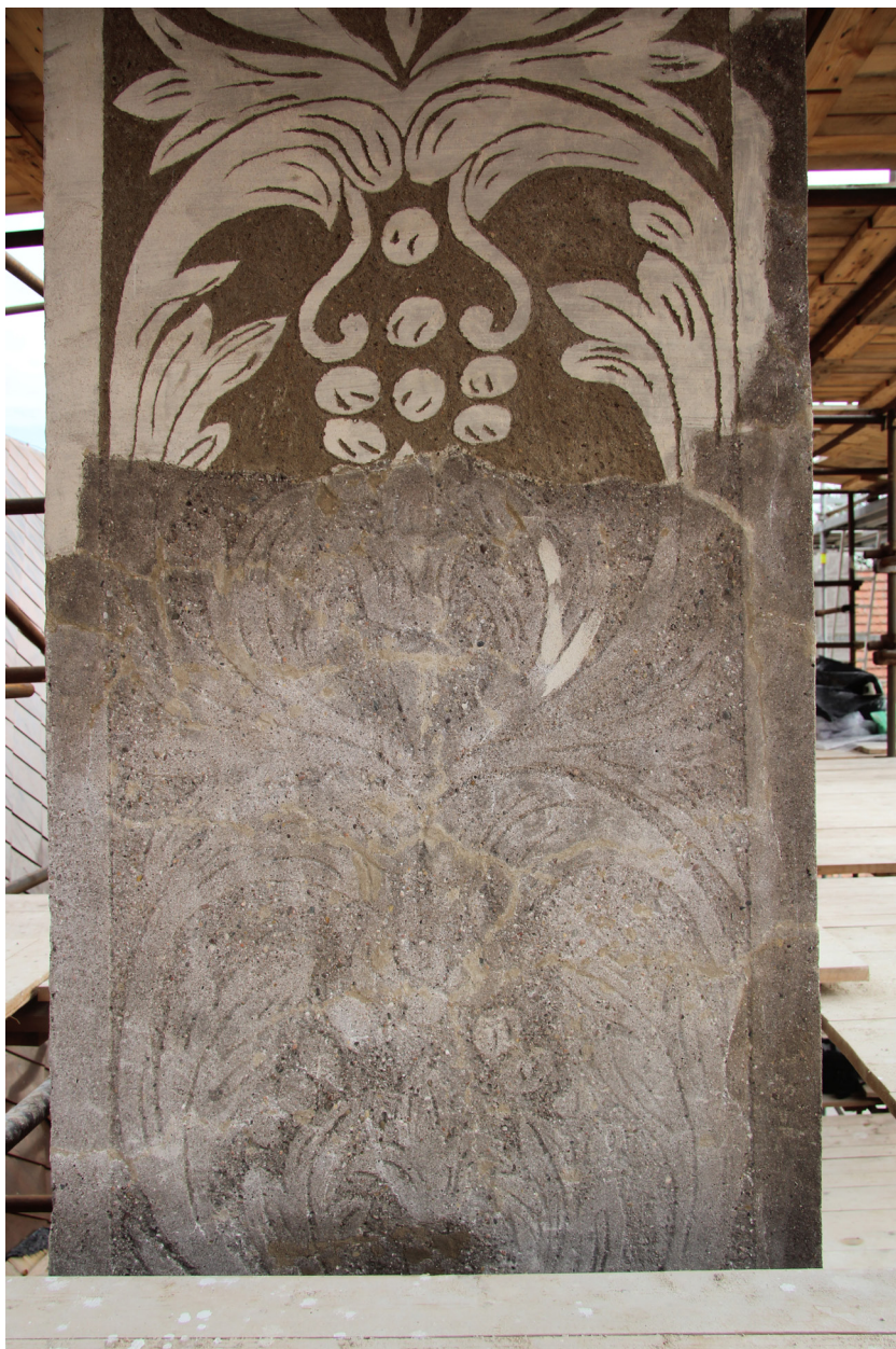
Obr. 70: Komín č. 2, západní strana. Stav po konzervaci, vytmelení defektů a provedení rekonstrukce chybějících částí.
