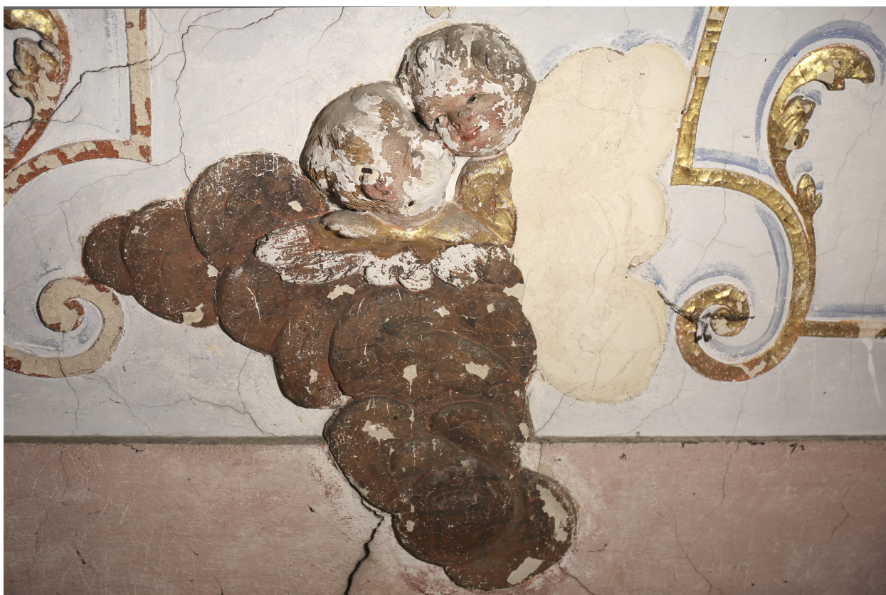
Obr. 83: Snímek dokumentující detail chybějících fragmentů štukové výzdoby. Na snímku lze pozorovat rytou podkresbu provedenou do suché, či zavadlé omítky. Také je vidět degradovaný (zčernalý) povrch plátkového stříbra a lokální ztráty vrstvy metalu.
