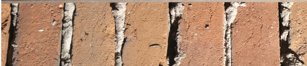
Obr. 40: Detail dřevěného parapetu zazděného otvoru do oratoře.
