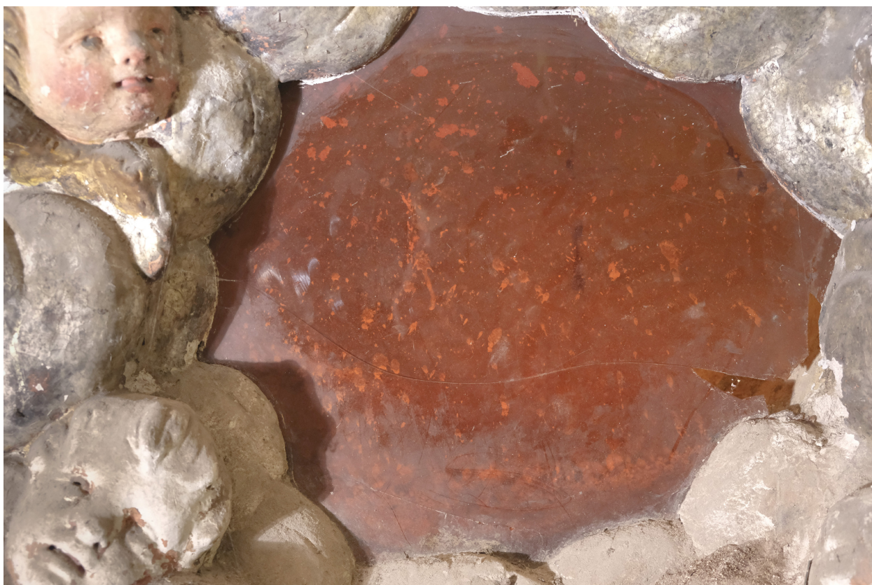
Obr. 49: Snímek dokumentující detail malby, výjev „Putování mudrců za hvězdou“. V otevřených defektech lze pozorovat červený poliment, který patrně sloužil jako podklad. Severní stěna zámecké kaple.
