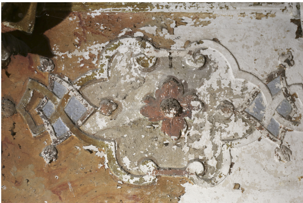
Obr. 72: Větší detail štukové výzdoby na ploše pilastru. Na snímku lze pozorovat ztrátu barevné vrstvy až na křídový podklad. Rovněž lze vidět šupinkovatění barevné vrstvy a zároveň degradovaný povrch stříbra a metalu.
