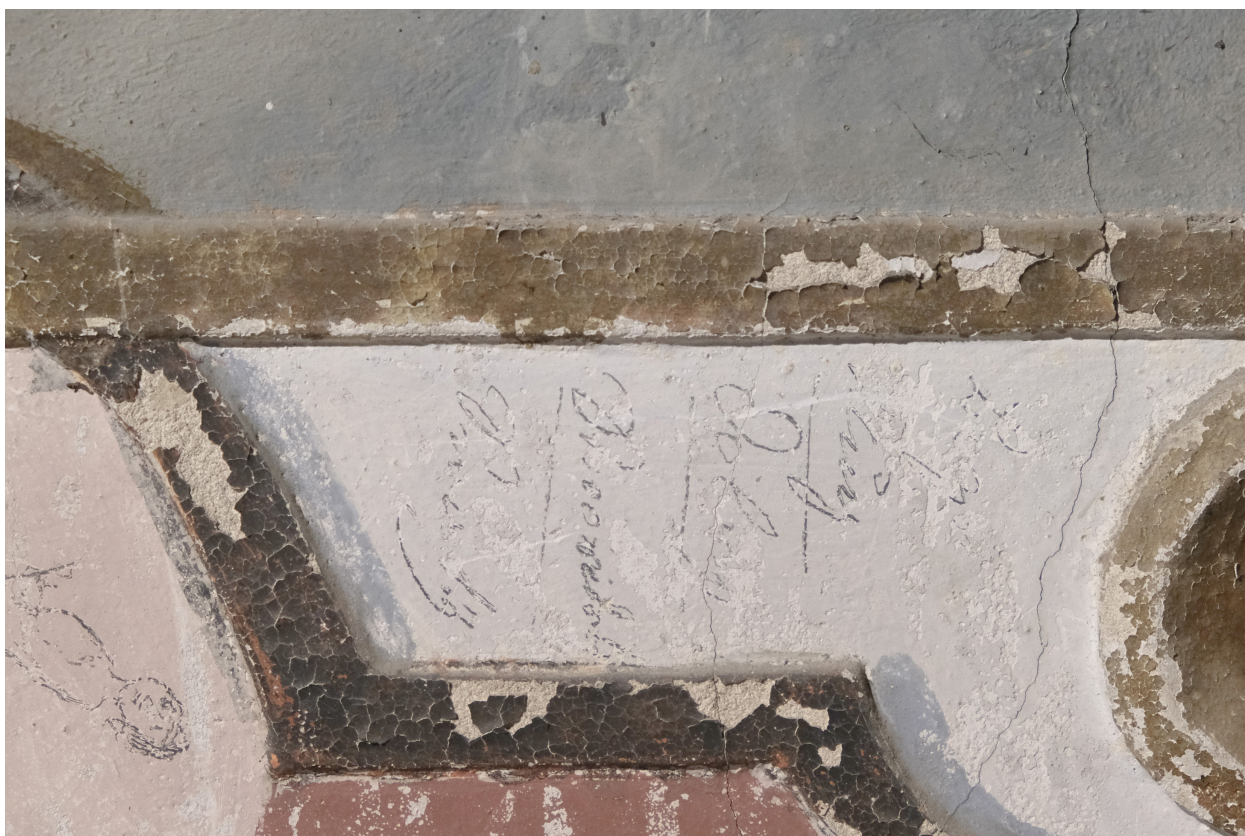
Obr. 61: Snímek dokumentující oblast s druhotnými grafity a nápisy nejspíše olůvkem, či grafitovou tuhou. Severní stěna zámecké kaple.
