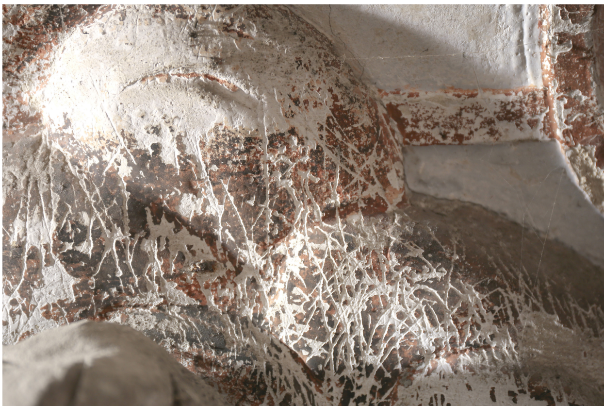
Obr. 80: Větší detail poškození štukové výzdoby. Na povrchu štuku lze vidět velké množství vyrytých čar do materiálu, pravděpodobně se jedná o škrábance od ptačích drápů. Také skrz defekty lze pozorovat relativně hladkou strukturu povrchu křídového podkladu.
