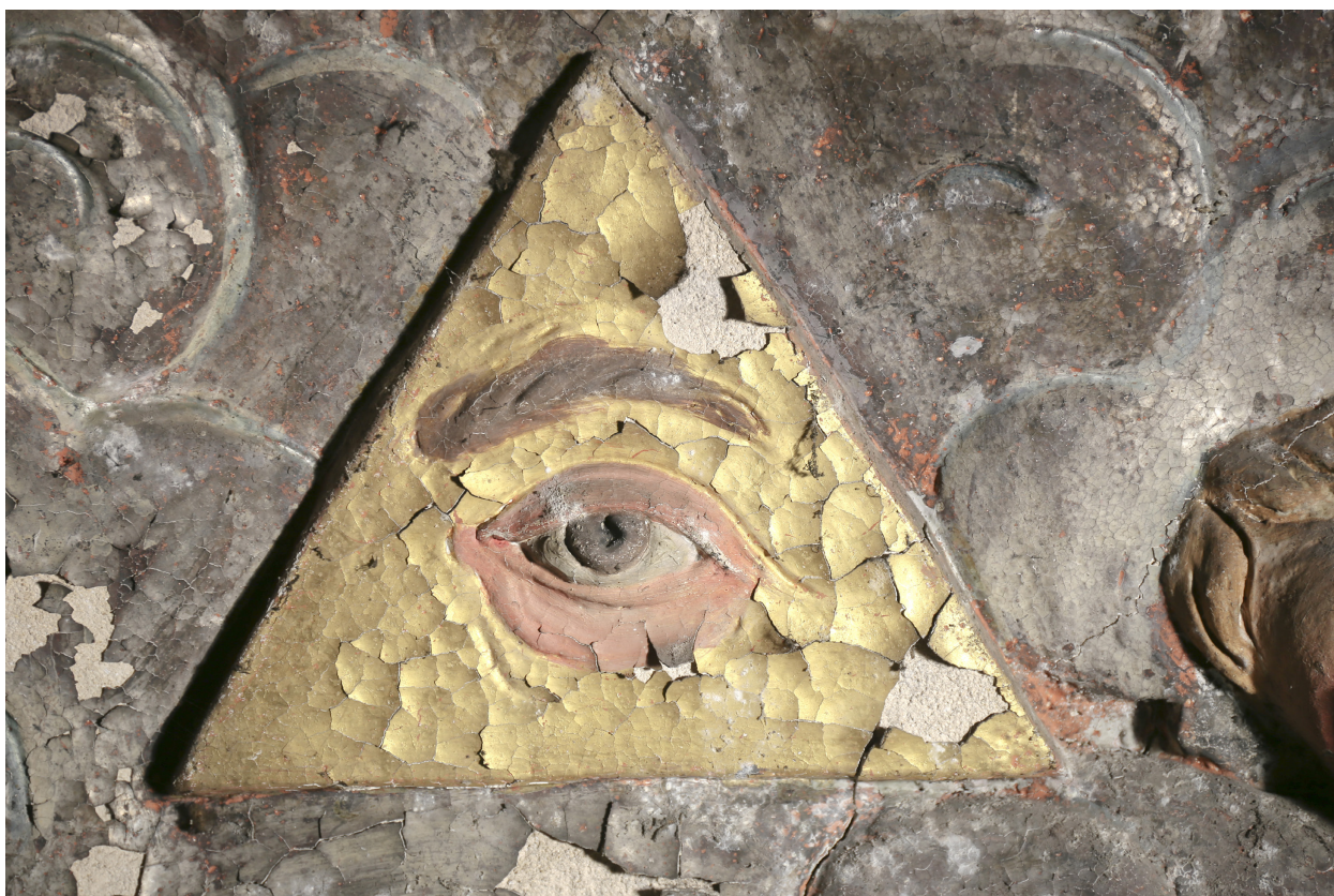
Obr. 74: Detail štukové výzdoby s degradovanou vrstvou plátkového zlata. Na snímku lze vidět šupinkovatení a krakeláž vrstvy zlata, nebo úplnou ztrátu vrstvy až na křídový podklad.
