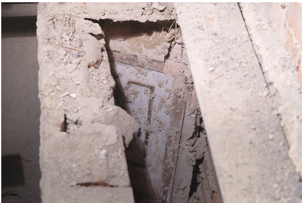
Obr. 53: Snímek dokumentující pohled za zadržku dveří s původní štukovou výzdobou na špaletě. Zadržka byla odstraněna v prosinci 2021. Východní stěna zámecké kaple.
