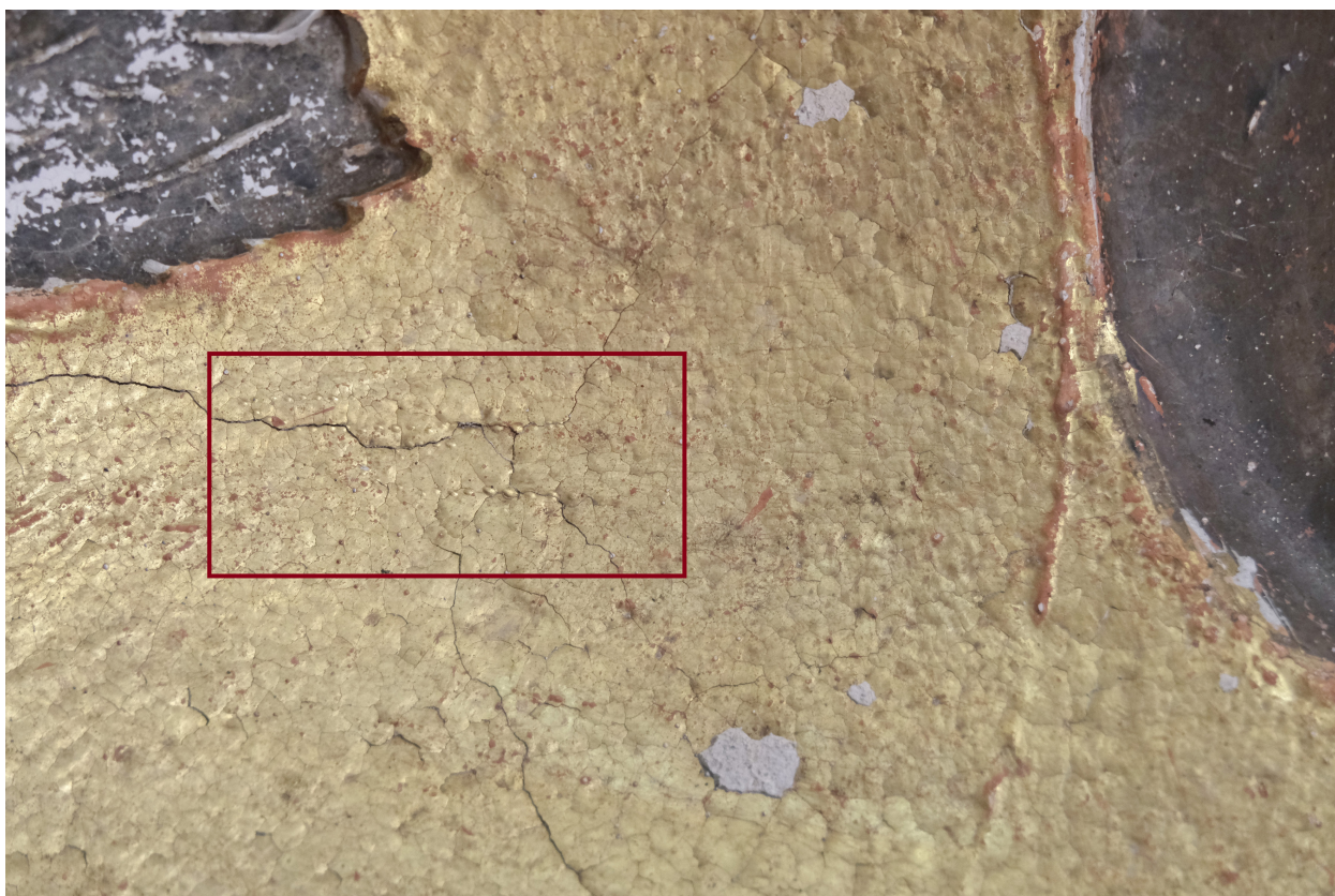
Obr. 26: Snímek dokumentující drobné vpichy vyskytující se lokálně v oblasti pozlacené plochy nad centrální holubicí. Nástrovní štuková výzdoba.
