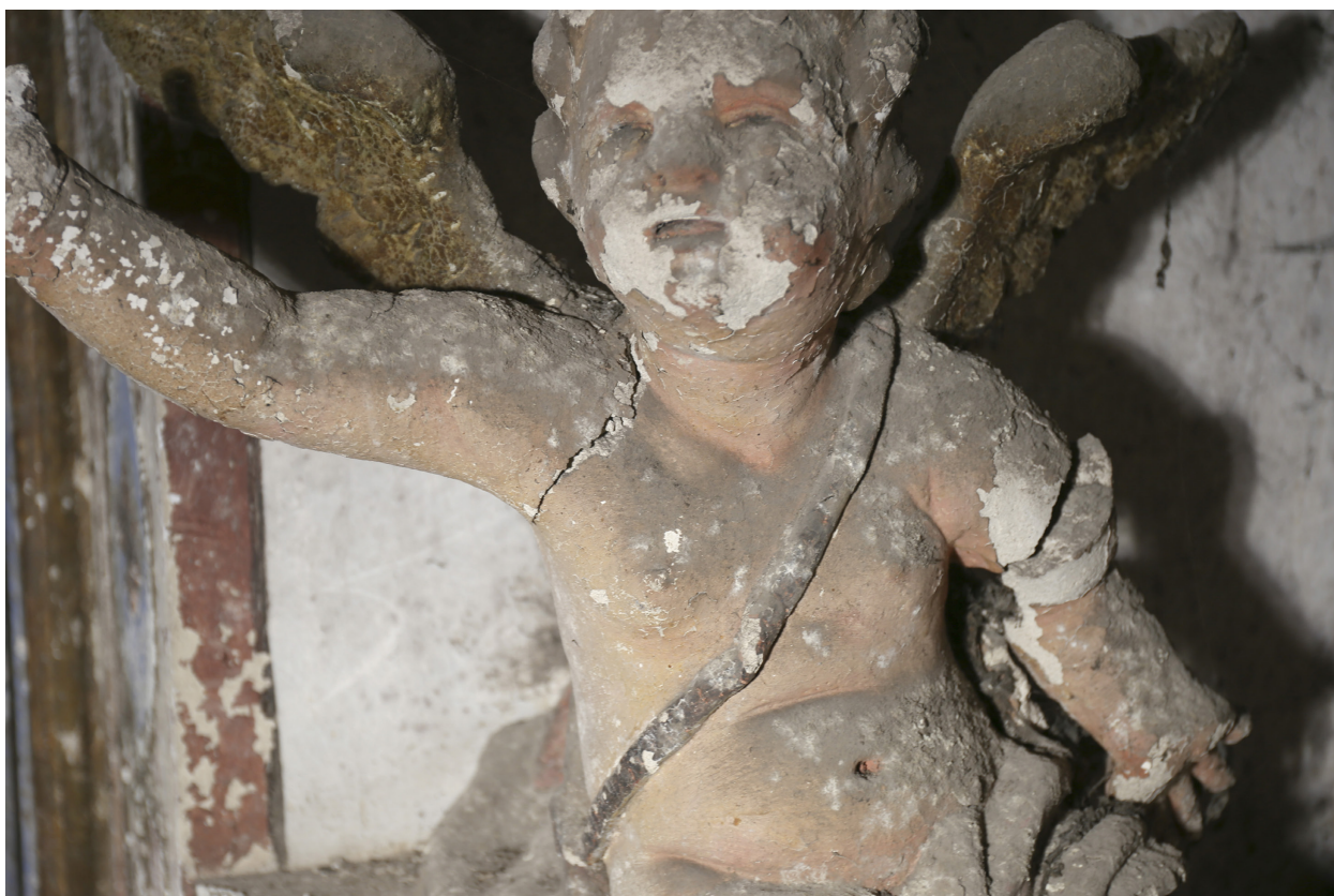
Obr. 87: Snímek dokumentující detail mechanického poškození sochy anděla, zejména odlomení části štuky. Na snímku je vidět drátěné armatury vedoucí skrz anděla. V oblasti hlavičky anděla jsou viditelné lokální ztráty vrstvy polychromie. Povrch sochy je značně zaprášený.
