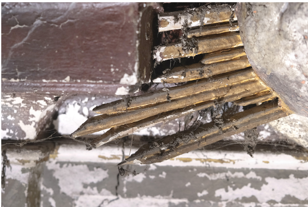
Obr. 38: Snímek dokumentující detail drátěné armatury vedoucí skrz paži anděla.
