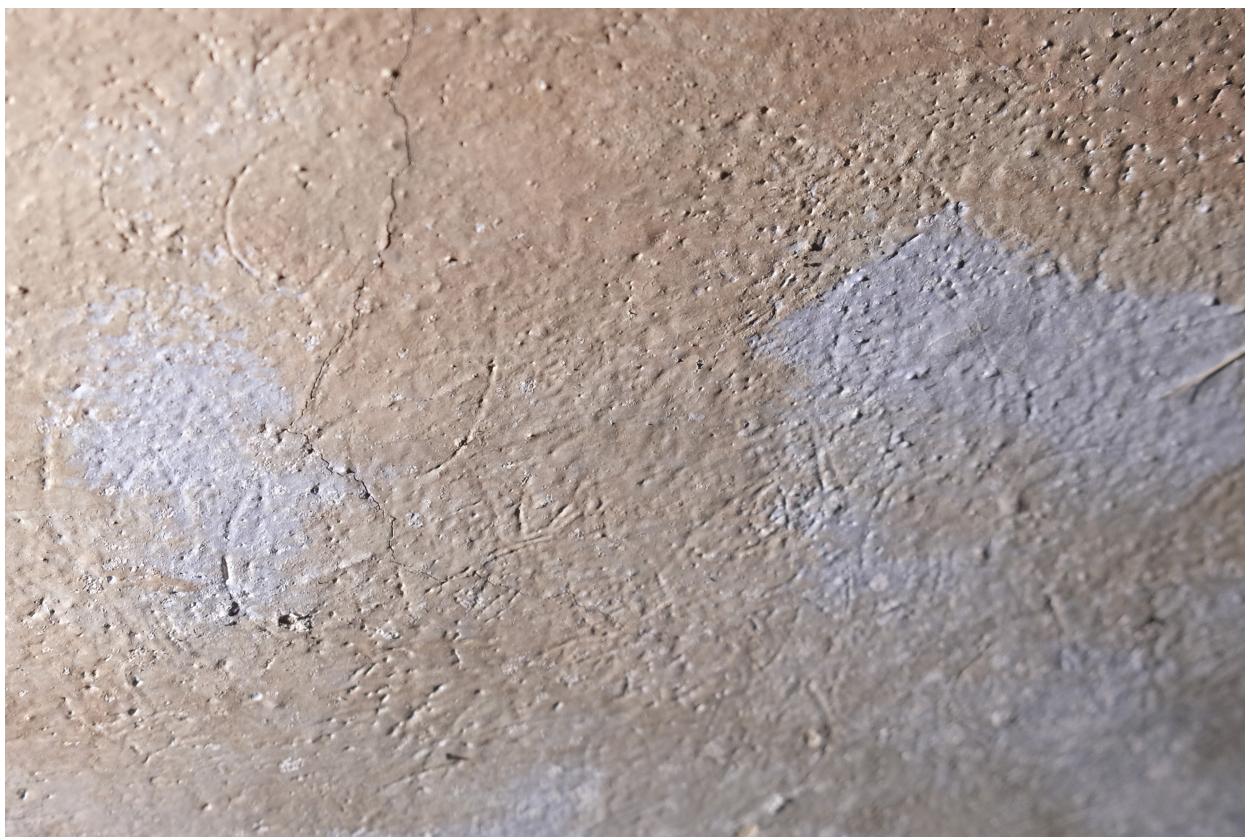
Obr. 14: Detail struktury omítky v klenební oblasti. Ostré boční nasvícení zdůrazňuje zatočení krouživými tahy charakteristické po utažení dřevem.
