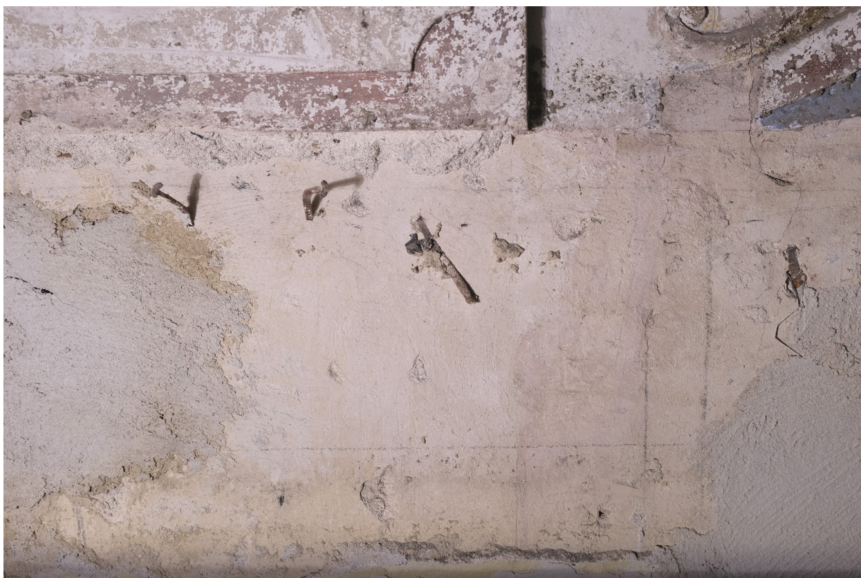
Obr. 42: Kombinace hřebíku a drátu sloužící jako armatura pro štukovou výzdobu. Spodní část jižní stěny zámecké kaple.
