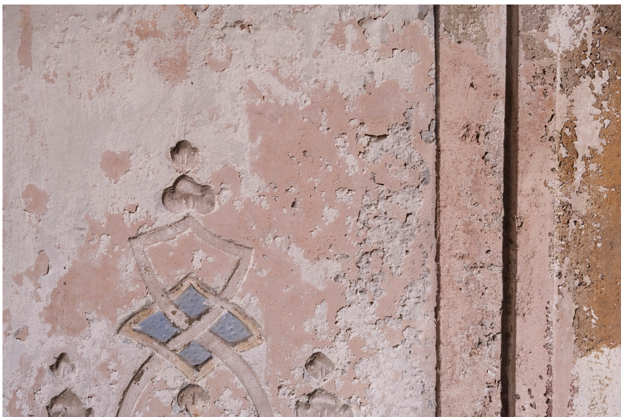
Obr. 12: Rozhraní pravděpodobně denního dílu v ostrém umělém bočním nasvícení. Zřetelná rozdílná barevnost omítek. Jižní stěna.
