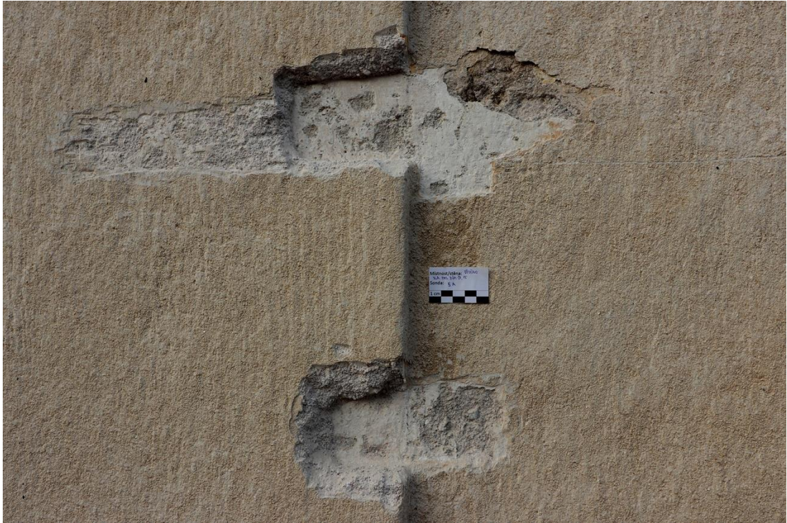
Obr. 2: Sonda S5A na pravé straně prvního patra domu, ve které je patrné pozdější přidání zvýšeného profilu nároží.
