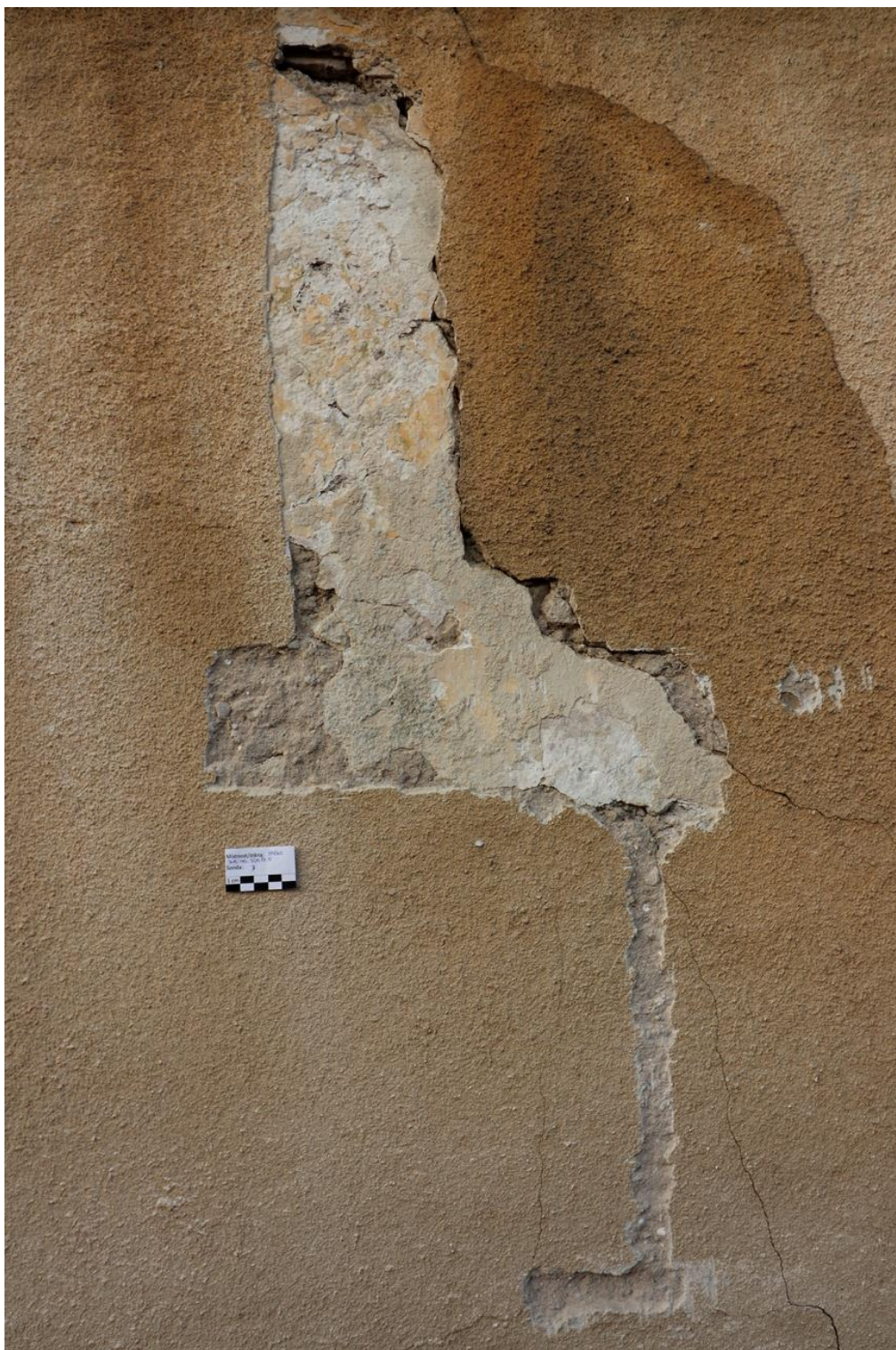
Obr. 6: Sonda S7 v prvním patře domu nad prostředním oknem bez známek dochování sgrafit.
