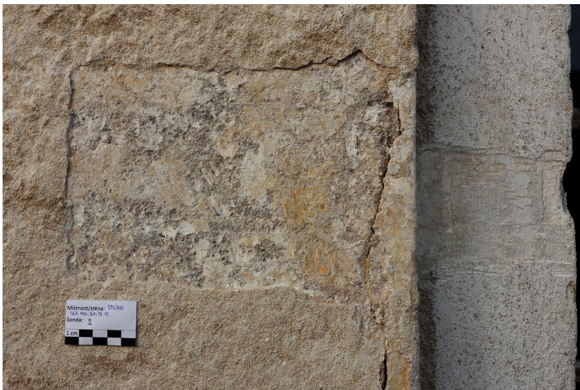
Obr. 03: Sonda S2 vedle orámování levého okna na štítu domu.
