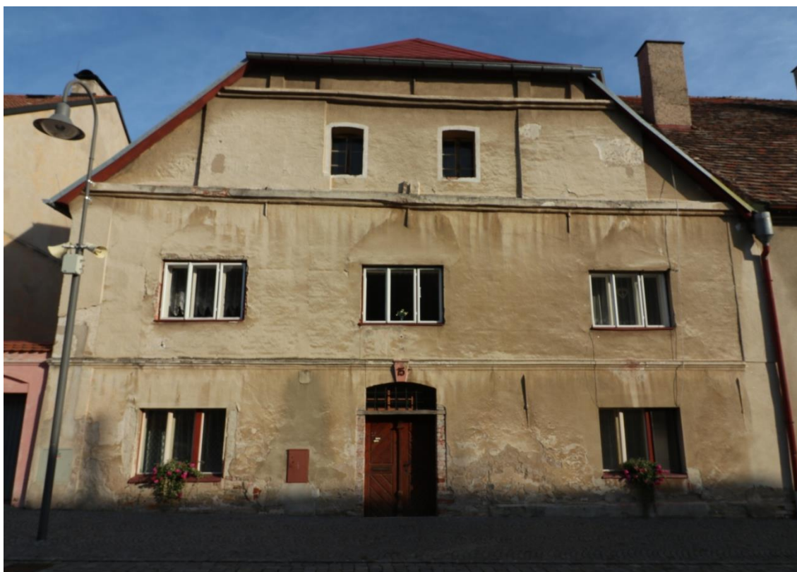
Obr. 21: Celkový pohled na průčelní fasádu domu č. p. 15 na Trčkově náměstí.
