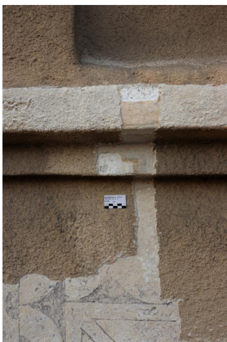
Obr. 08: Sonda S4C na štítu v pravé části domu fasády (levá a pravá část sondy).
