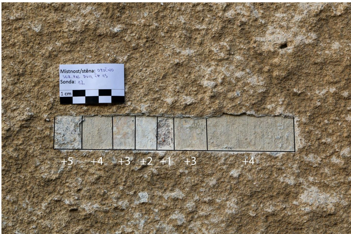
Obr. 19: Stratigrafická sonda S12 v pravé části přízemí domu.
