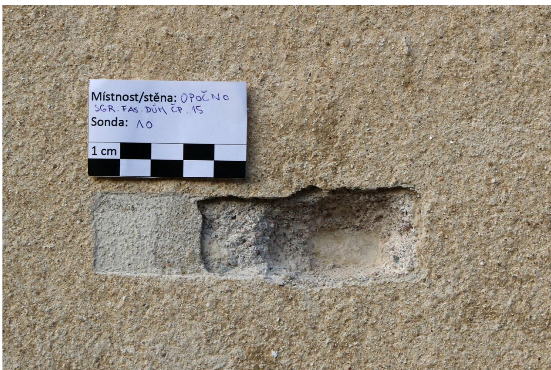
Obr. 17: Stratigrafická sonda S10 na levé straně v přízemí domu.
