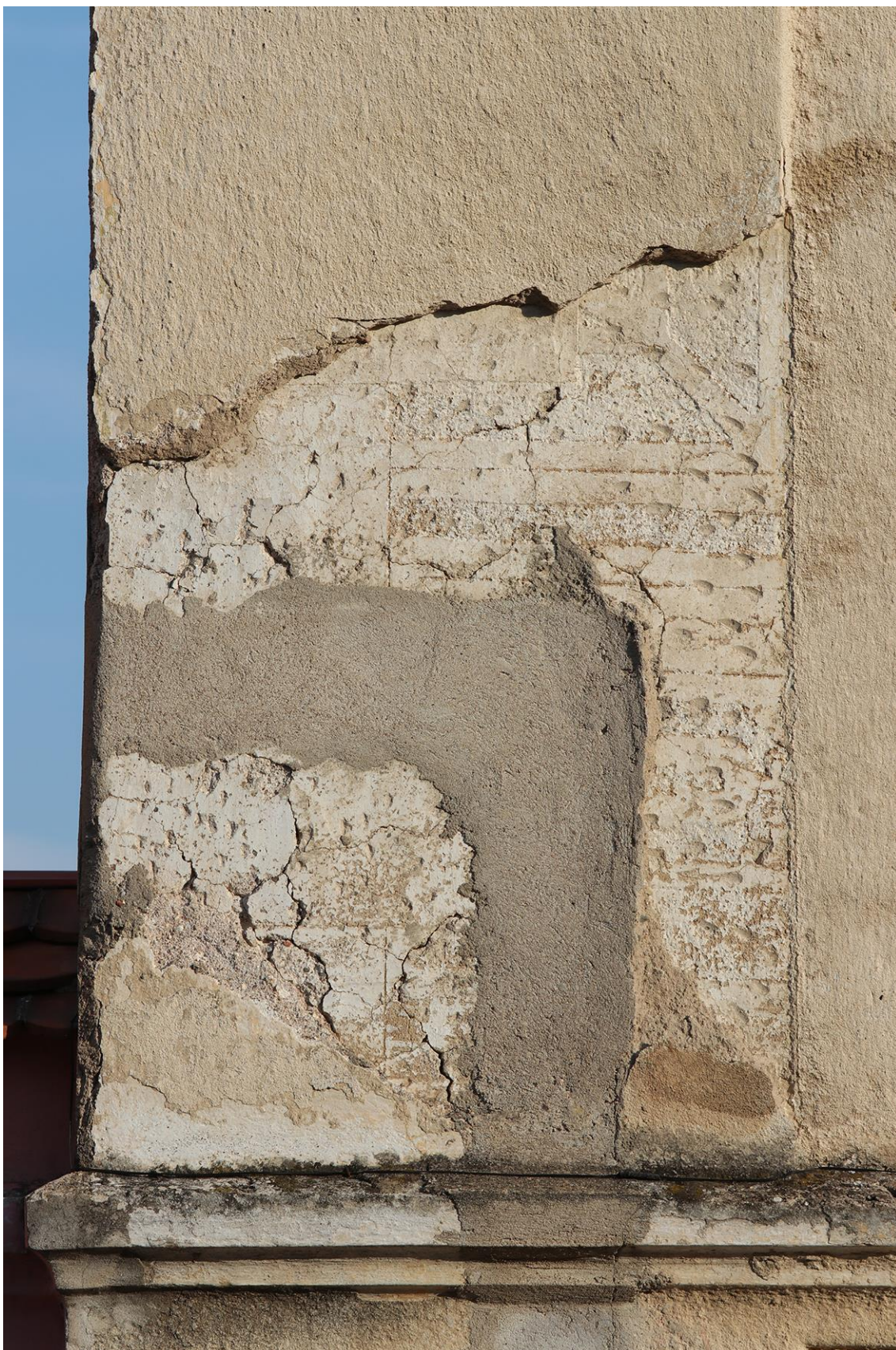
Obr. 25: Detail odhalení sgrafitové výzdoby na levém nároží prvního patra domu.
