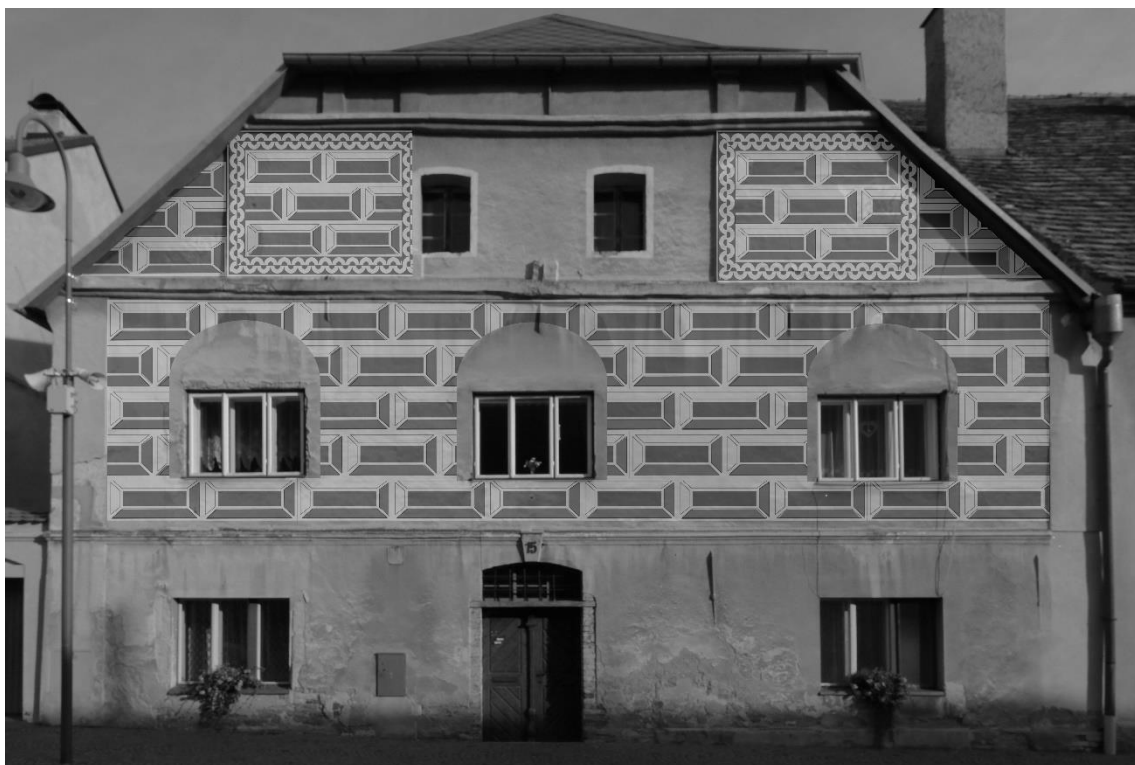
Obr. 30: Grafická vizualizace možné podoby domu s odhalenou sgrafitovou výzdobou se zjednodušeným provedením jednotlivých psaníček. Nákres je pouze orientační, rozmístění sgrafit se může lišit, především pak v oblasti nad okny prvního patra. Rovněž ozdobné pásy s půlkruhovými prstenci se mohou vyskytovat i na dalších místech fasády.
