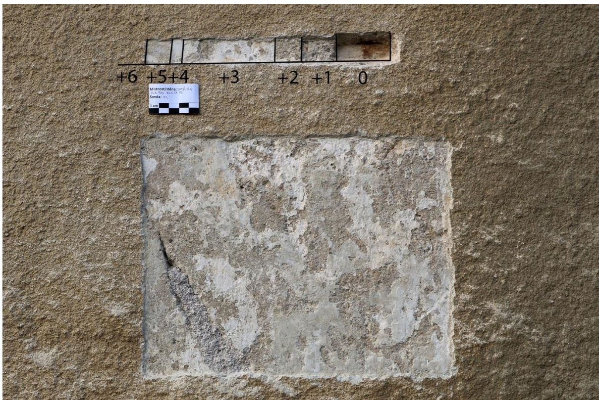
Obr. 18: Statigrafická sonda S11 v levé části přízemí domu.
