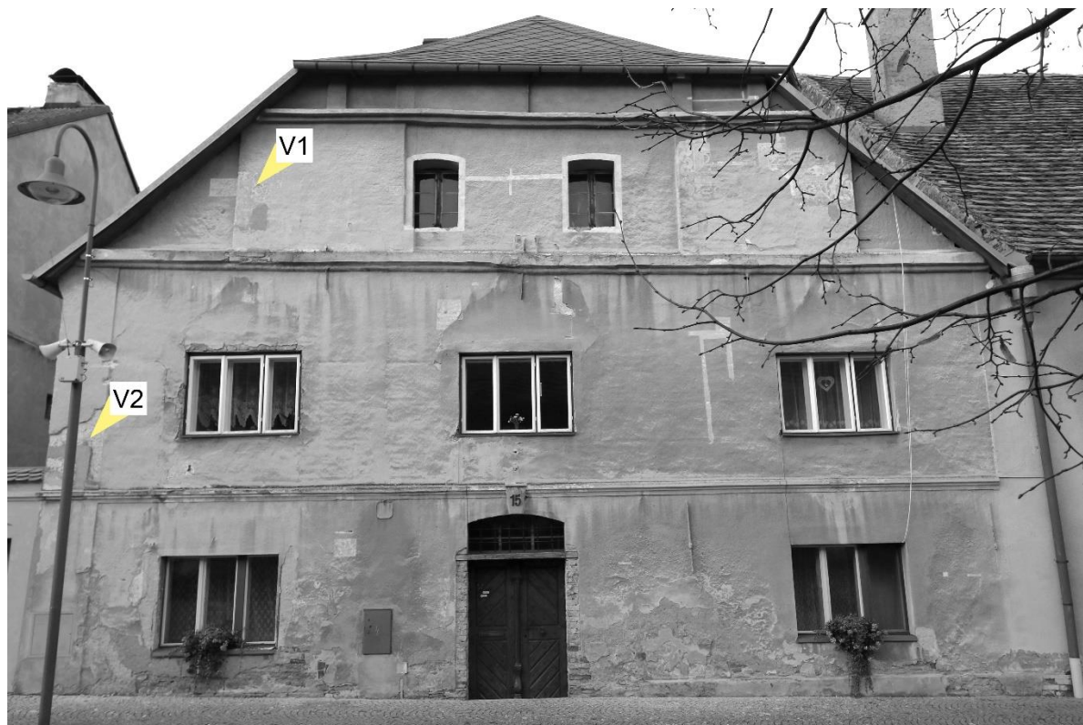
Obr. 30 Lokalizace odběru vzorků na fasádě.
