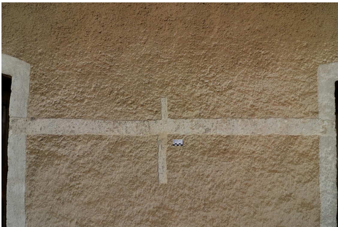
Obr. 04: Sonda S3 mezi okny ve štítu fasády domu se špatně dochovaným povrchem. Zde výskyt sgrafitové výzdoby nepředpokládáme.
