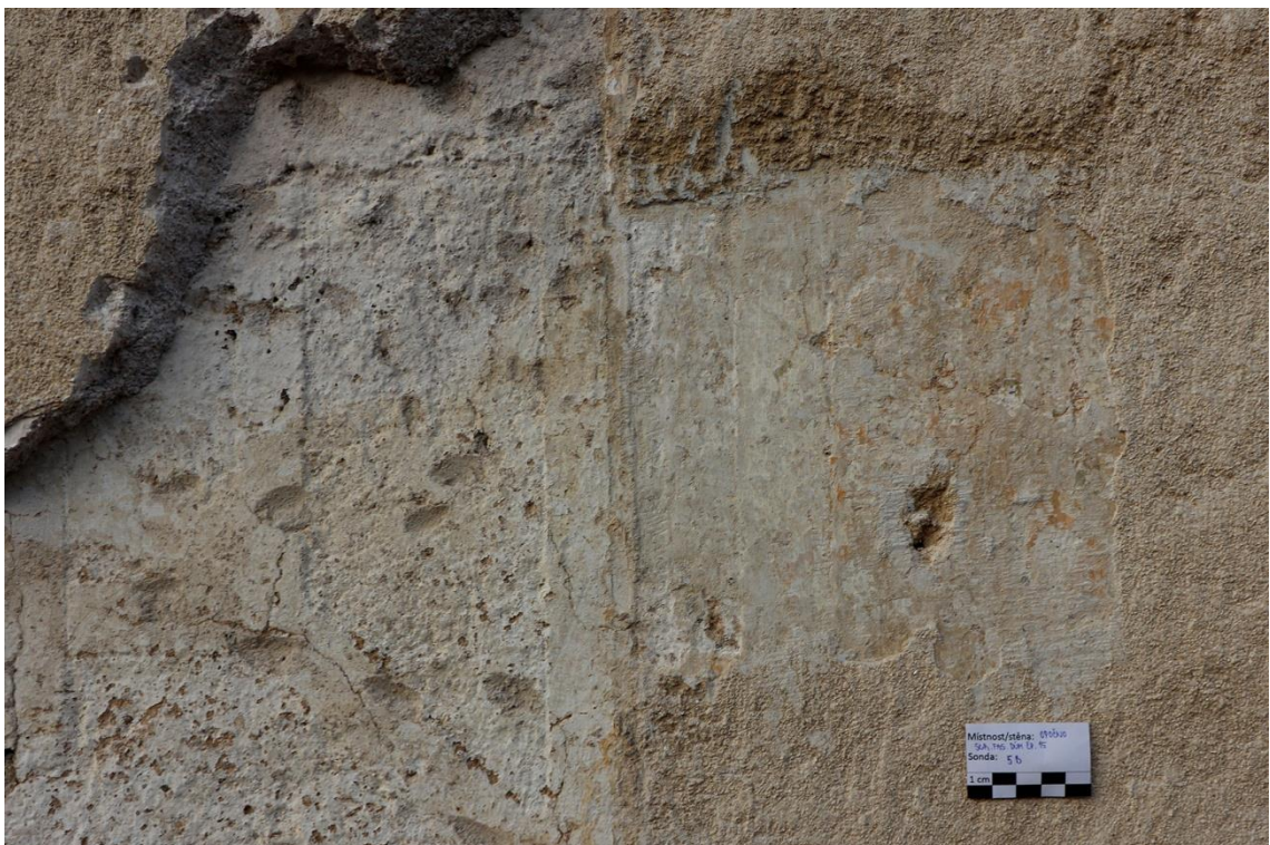
Obr. 3: Sonda S5B na pravé straně prvního patra domu. Detail dochovaných sgrafit pod silnější vrstvou pozdější omítky.
