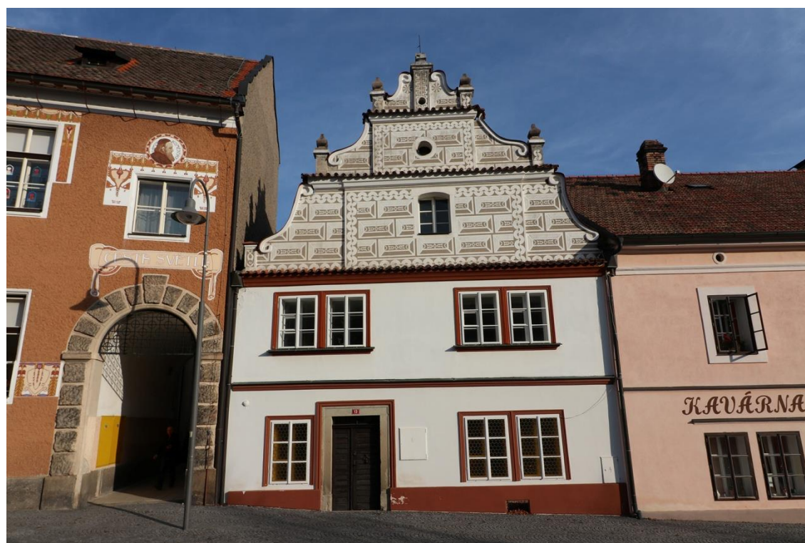
Obr. 22: Obdobná sgrafitová výzdoba domu č. p. 13 na Trčkově náměstí. Na atikovém štítu byly provedeny plné rekonstrukce, které mohly způsobit dezinterpretaci motivů.
