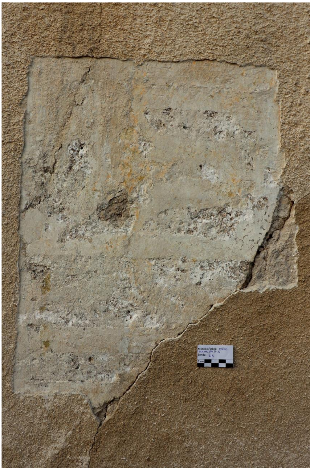
Obr. 4: Sonda S6A v prvním patře domu nad prostředním oknem. Odhalená sgrafitová psaníčka, která byla v první fázi zakryta pouze zabílením.
