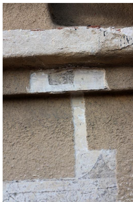
Obr. 08: Sonda S4C na štítu v pravé části domu fasády (levá a pravá část sondy).
