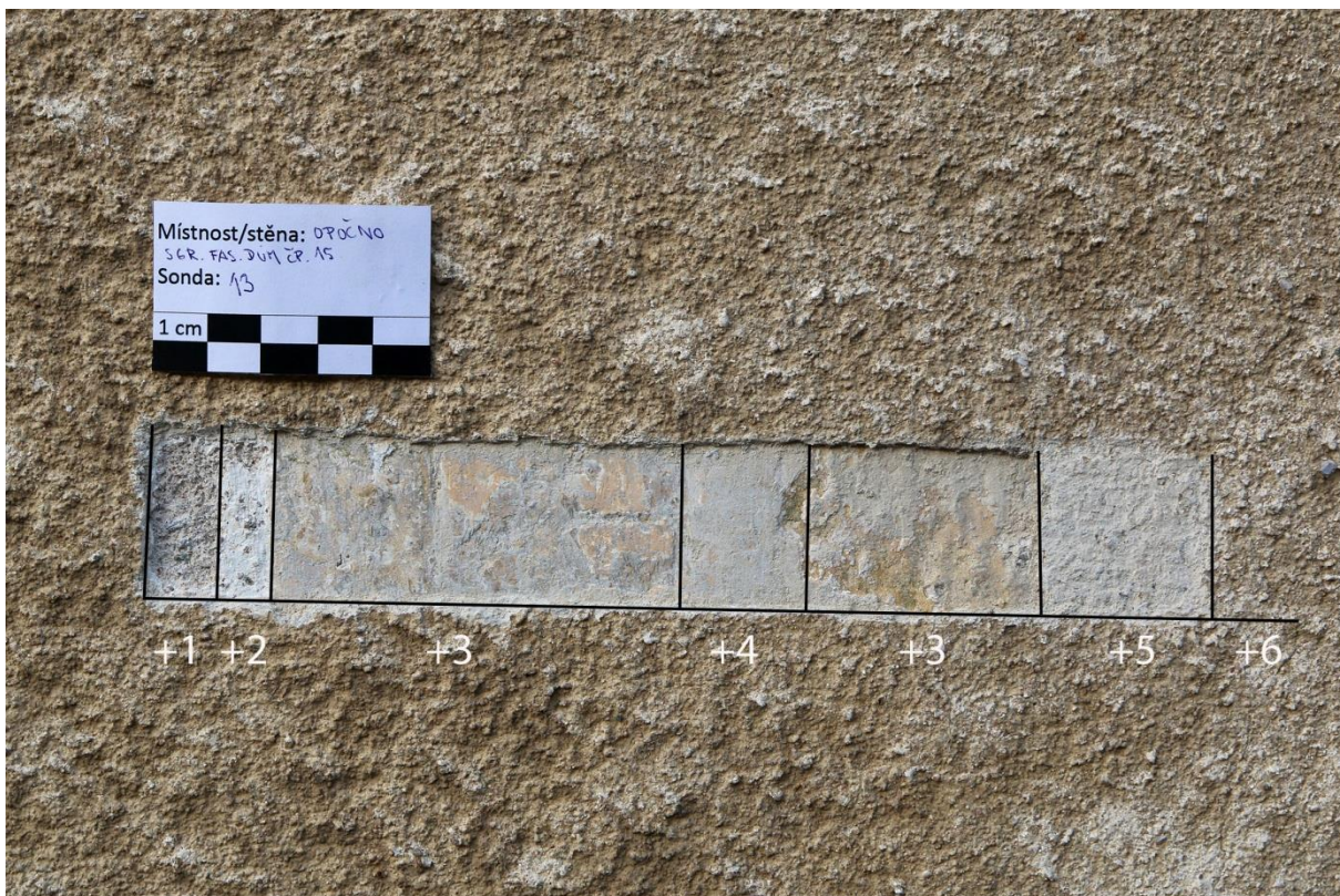
Obr. 20: Stratigrafická sonda S13 v pravé části přízemí domu.
