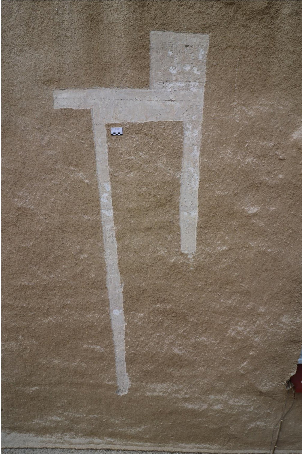
Obr. 15: Pásková sonda S8 na pravé straně domu v prvním patře zachycující rozsah dochování sgrafit.
