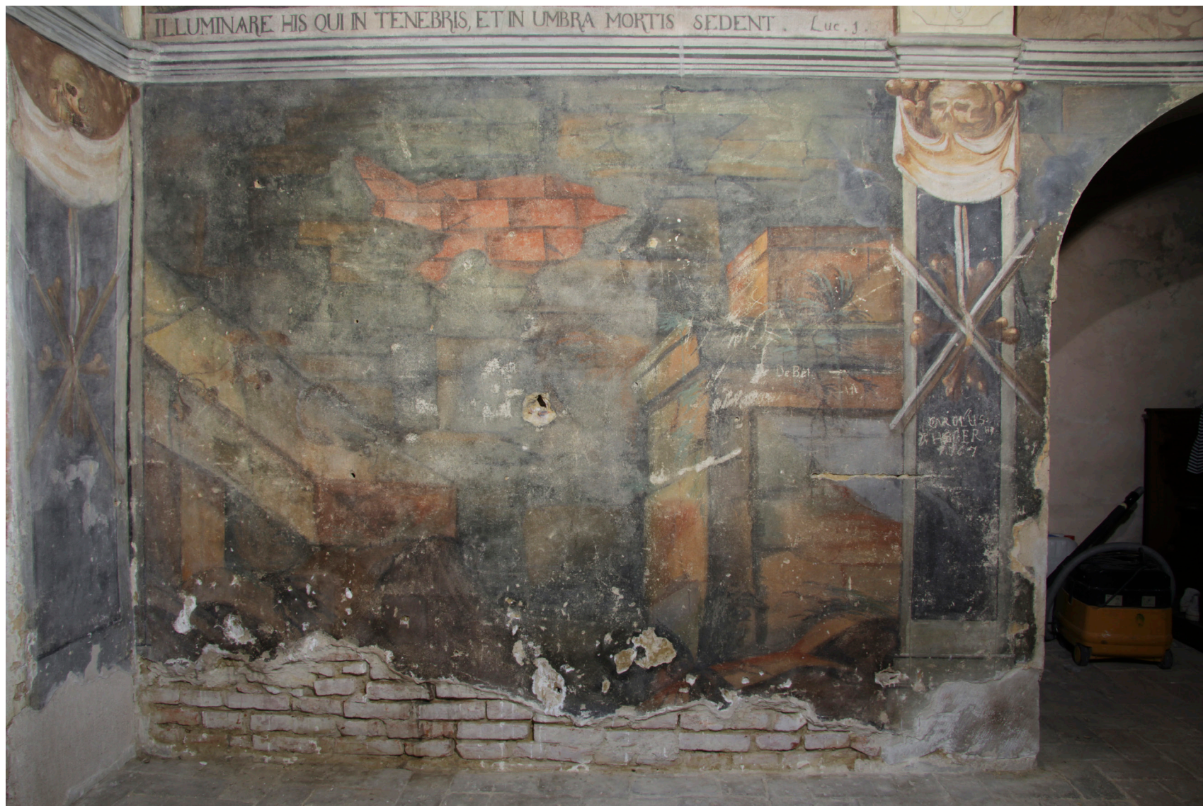
Obr. 85: JV stěna: celkový pohled na dolní část výmalby. Stav po čištění a odstranění druhotných zásahů.
