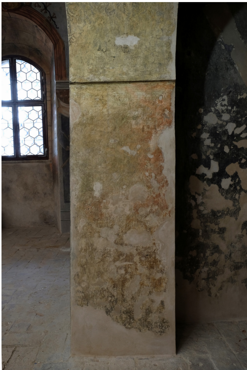
Obr. 99: JV stěna: levá část oblouku při vstupu do výklenku. Stav po čištění a tmelení.
