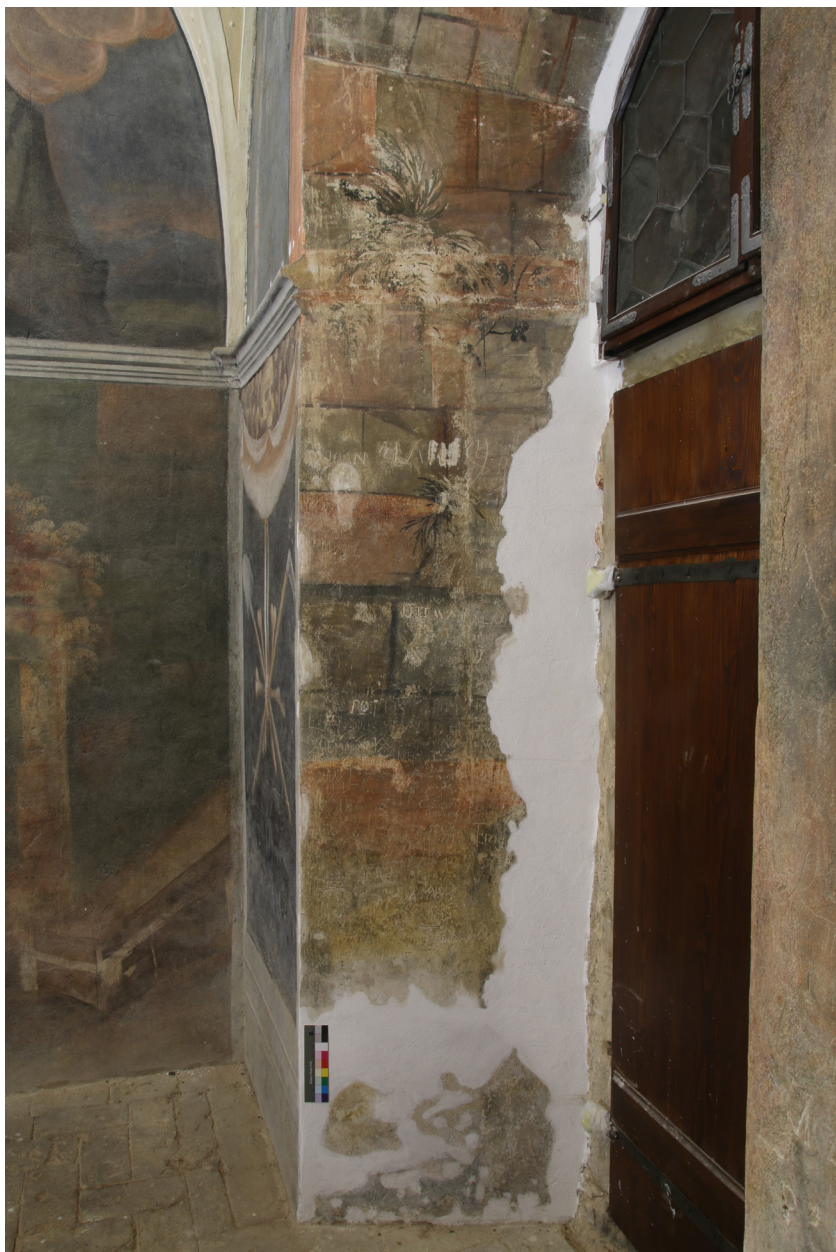
Obr. 94: SV stěna: pravá část dveřní špalety. Stav po čištění a tmelení.
