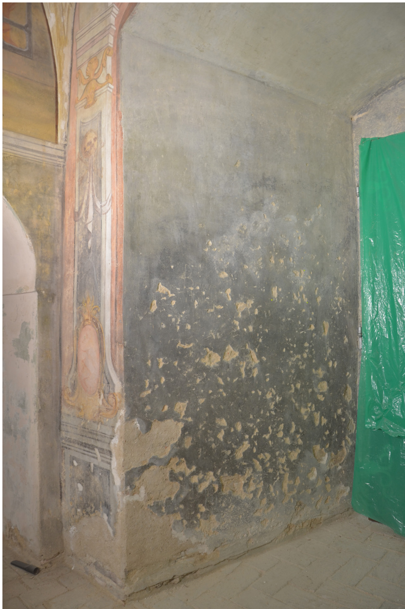
Obr. 86: JZ stěna, levá dveřní špaleta: Stav po odstranění druhotných, zřejmě sádrových vysprávek.
