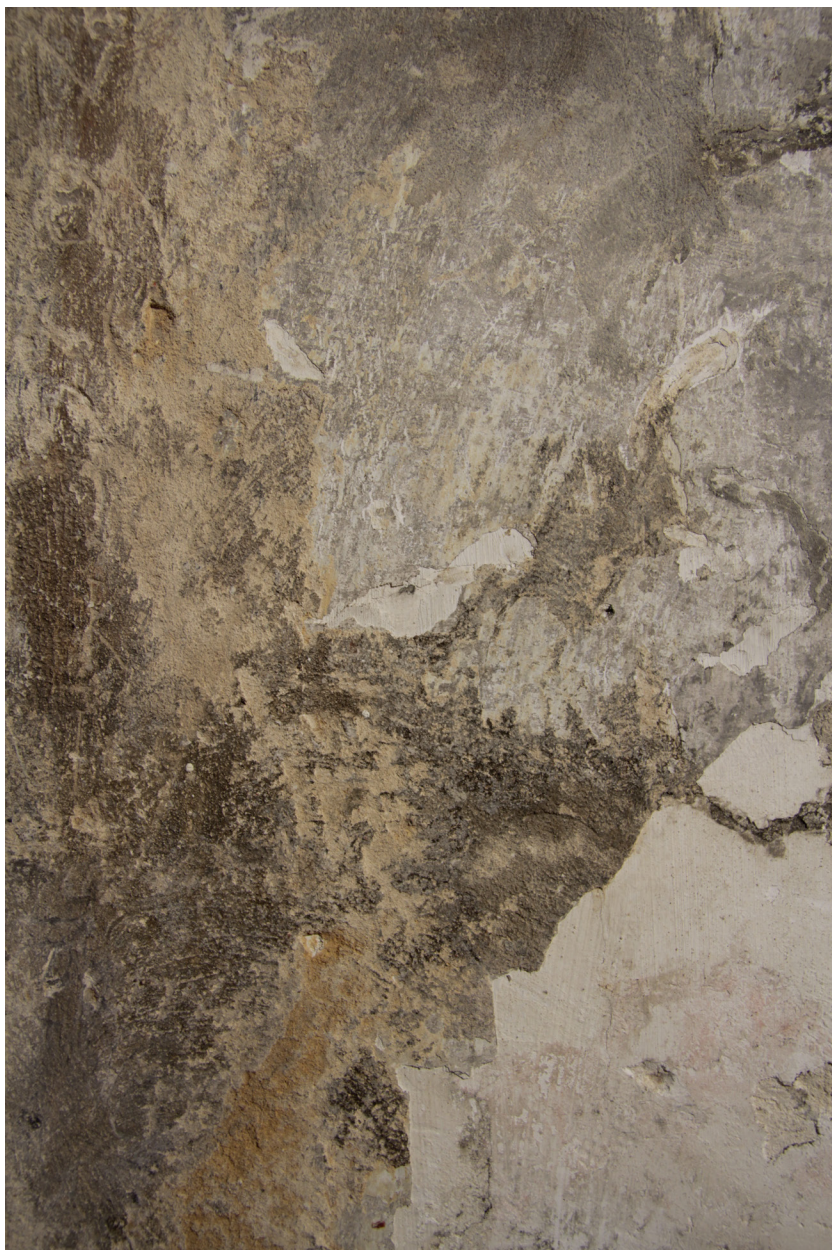
Obr. 31: SV stěna: luneta nad oknem. Detail rozhraní přemalby v podobě iluzivního kvádrování a originální modré barevné vrstvy v okolí stuhy s kostmi.
