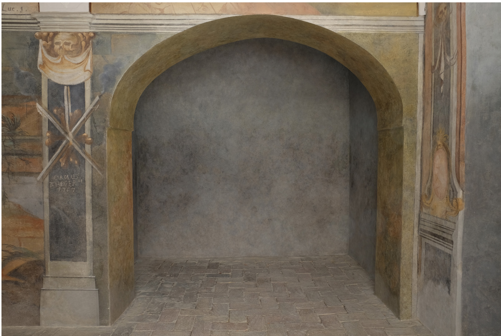
Obr. 119: JV stěna: celkový pohled na výklenek a zbylou výmalbu v dolní části stěny. Stav po restaurování.
