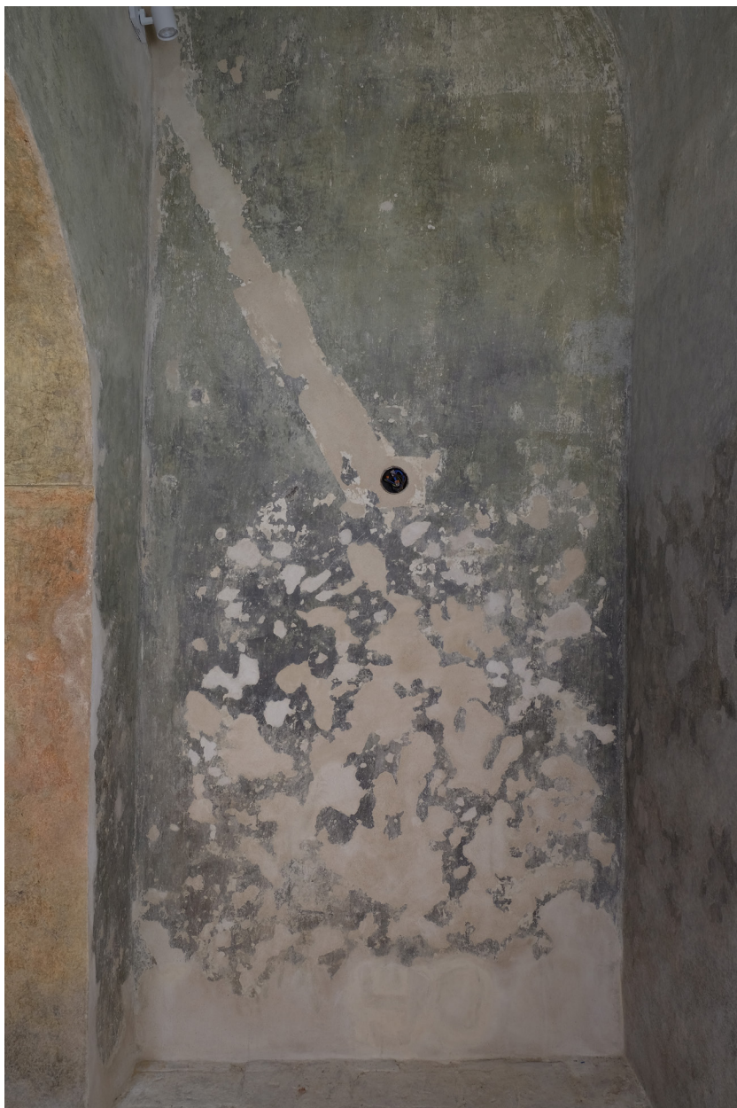
Obr. 103: JV stěna: levá část výklenku. Stav po čištění a tmelení.
