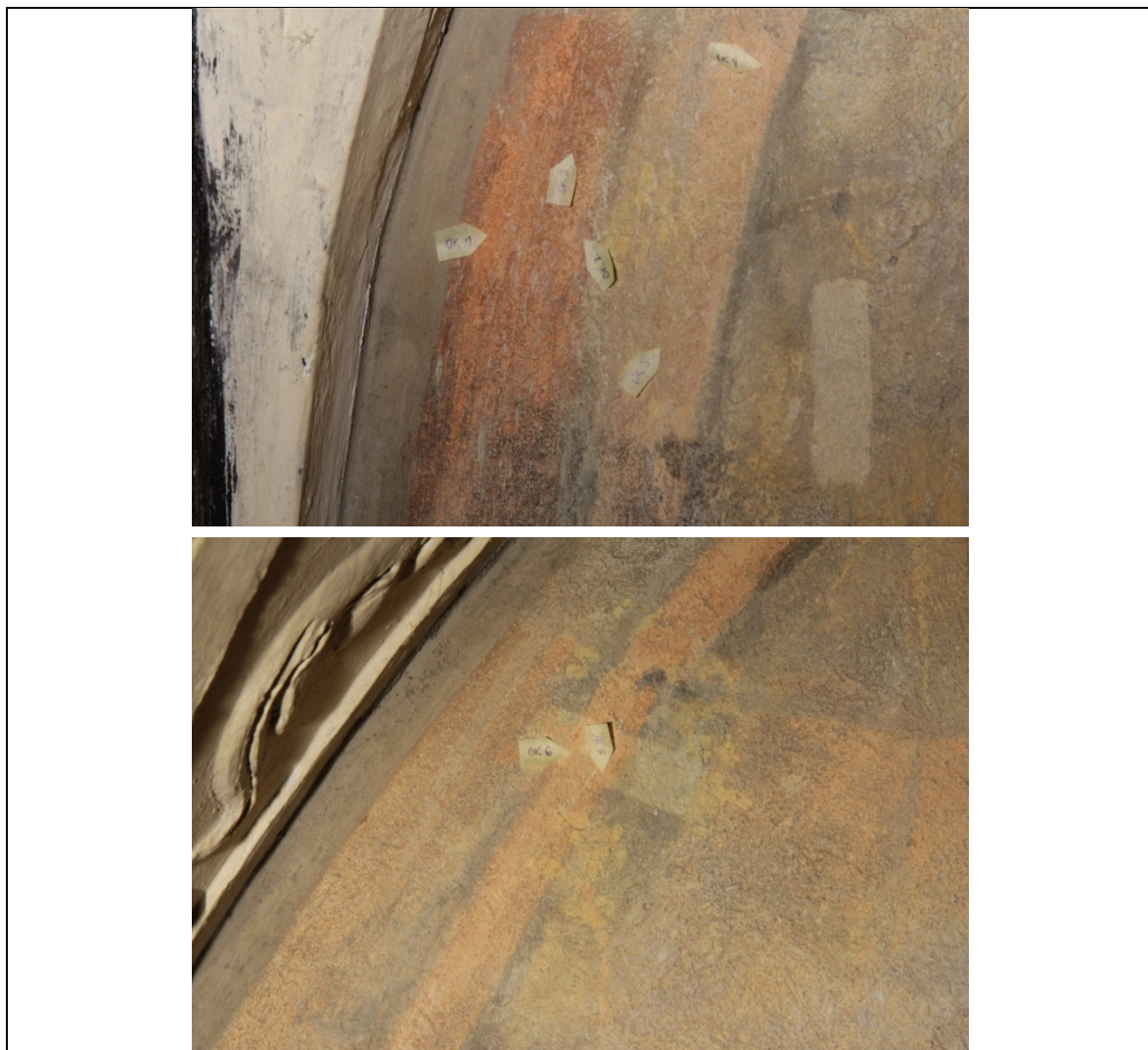
Obr. 1, 2 Lokalizace míst měření Ok 1–5, Ok 7 a Ok 8, pravá luneta, vnější rámování vlevo.
