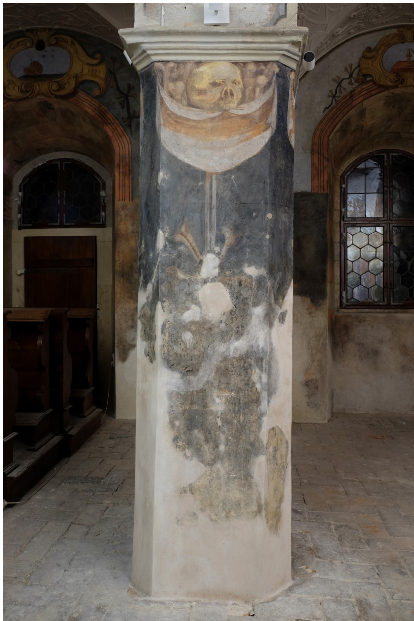
Obr. 110: Centrální pilíř: celkový pohled ze SZ. Stav po čištění a tmelení.
