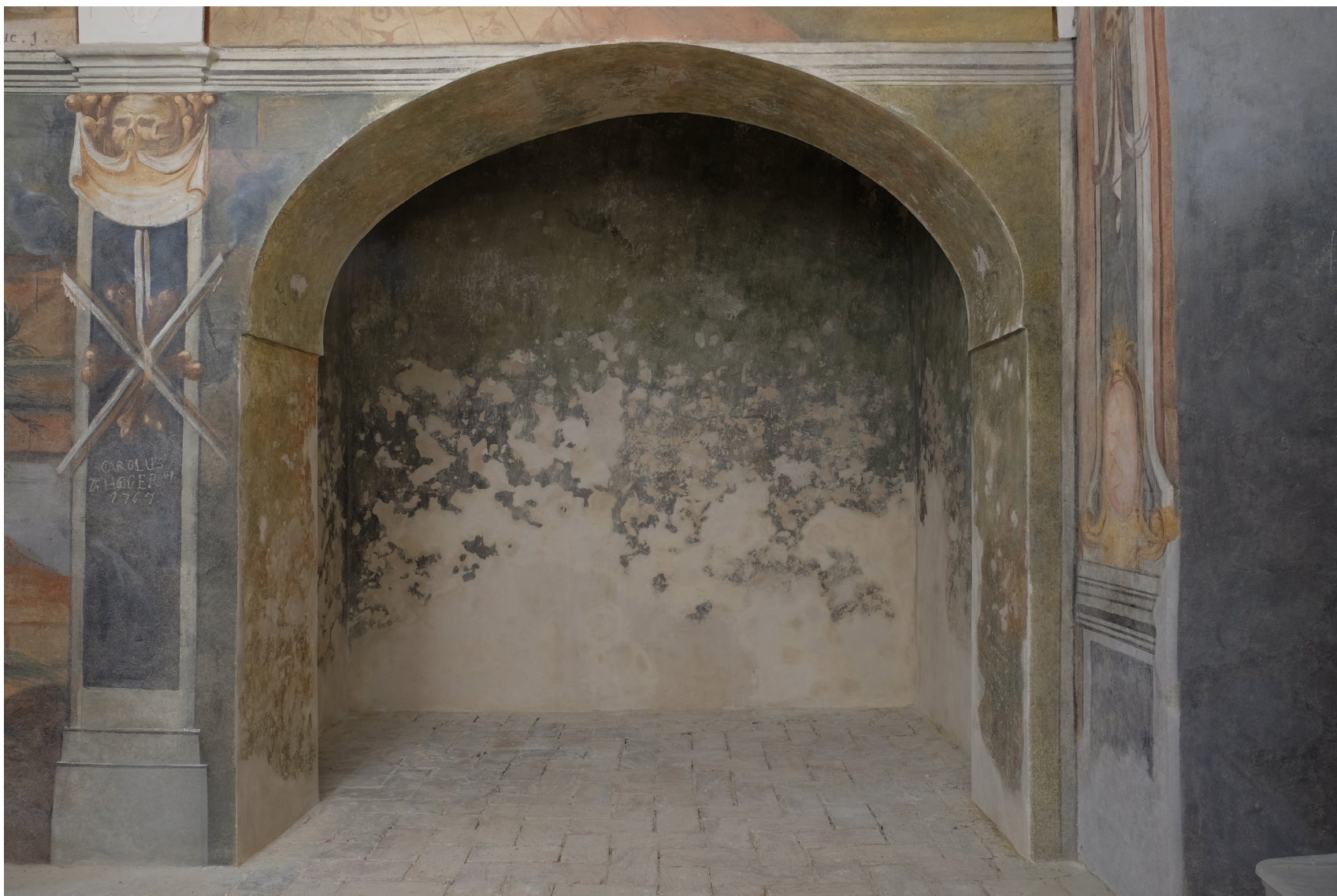
Obr. 98: JV stěna: celkový po- hled na výklenek. Stav po čištění a tmelení.
