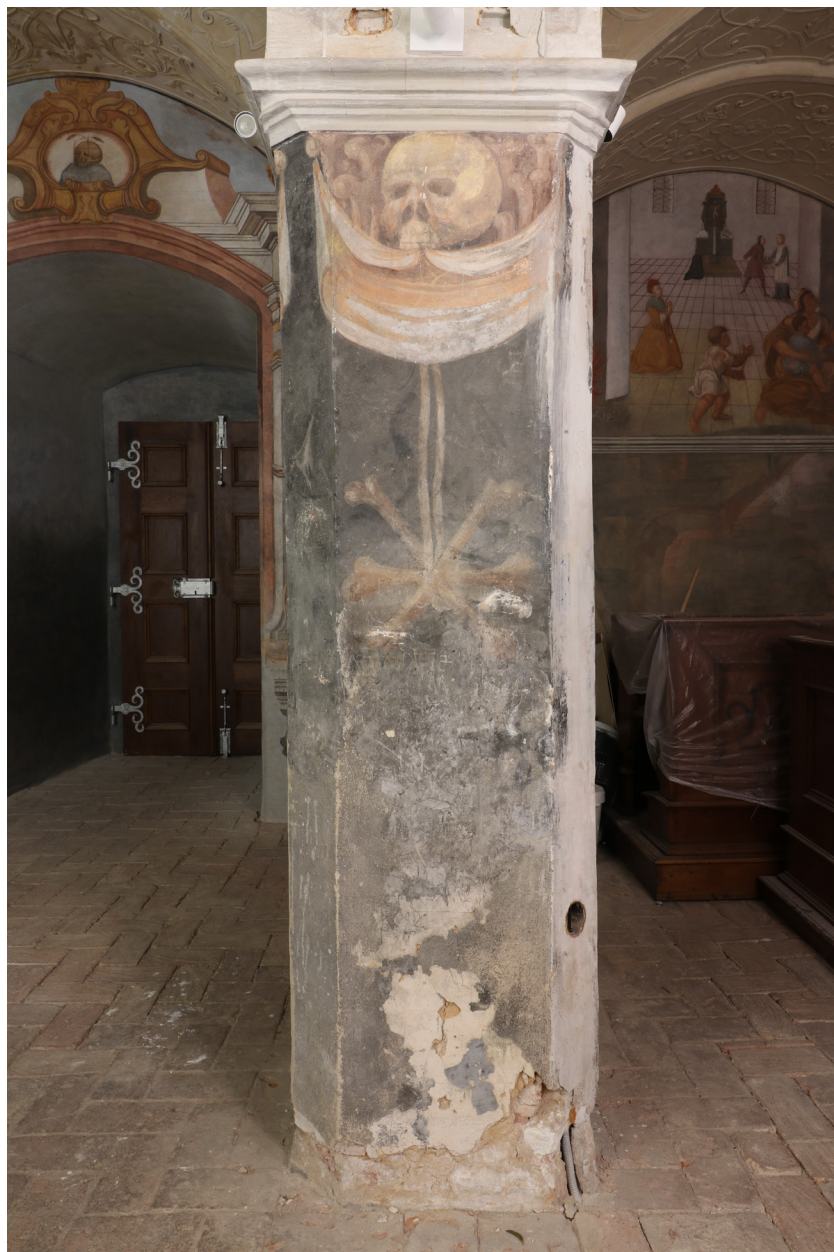
Obr. 10: Centrální pilíř: celkový pohled ze SV. Stav před restaurováním.
