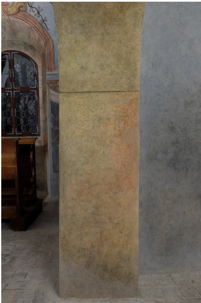
Obr. 121: JV stěna: pravá část oblouku při vstupu do výklenku. Stav po restaurování.
