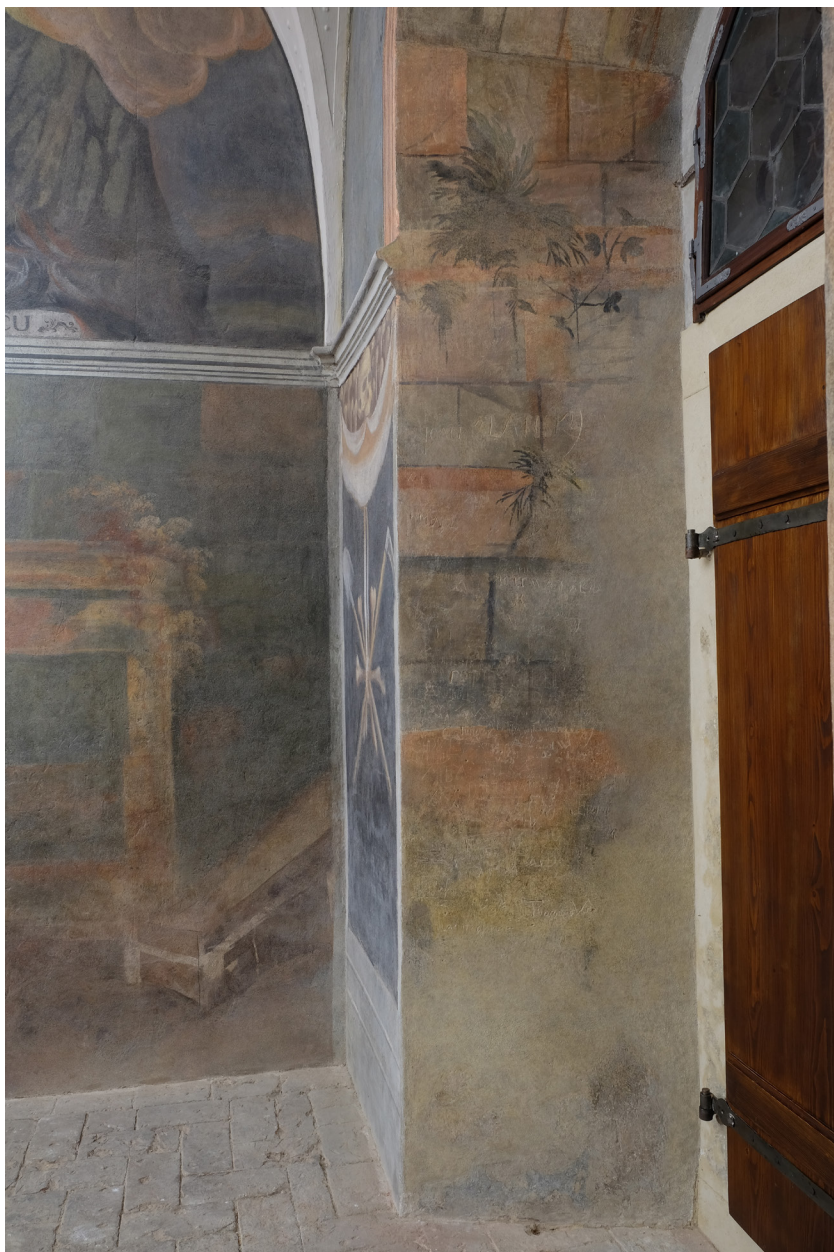
Obr. 114: SV stěna: levá část dveřní špalety. Stav po restaurování.
