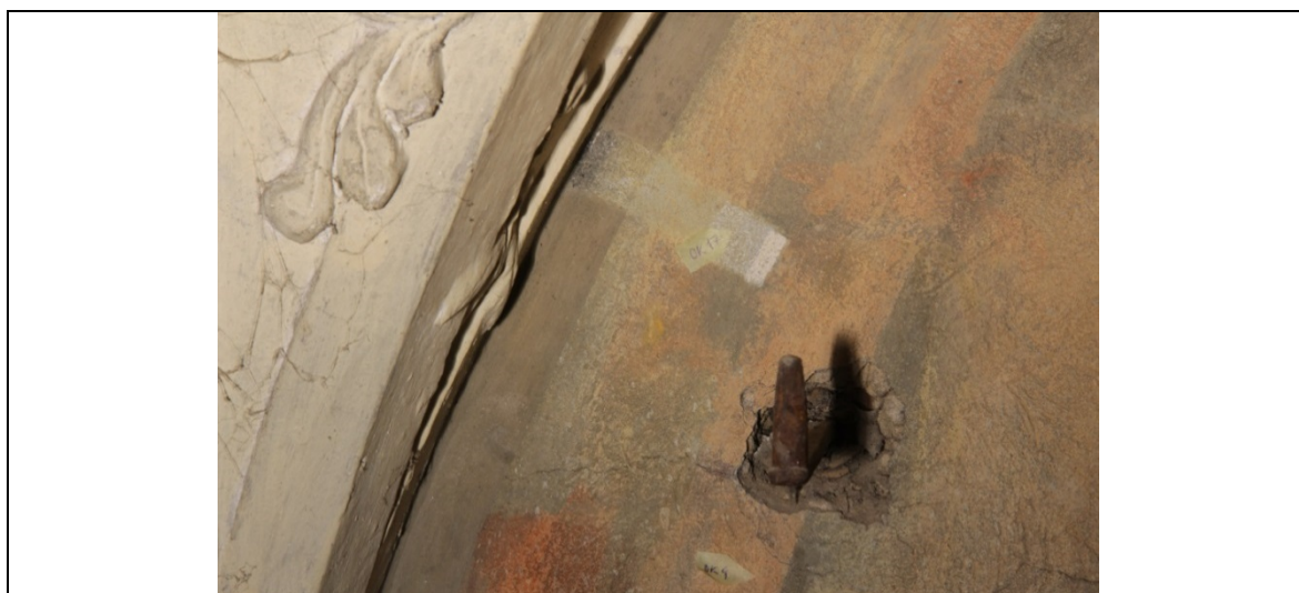
Obr. 6 Lokalizace míst měření Ok 17, pravá luneta vlevo, vnější rámování.
