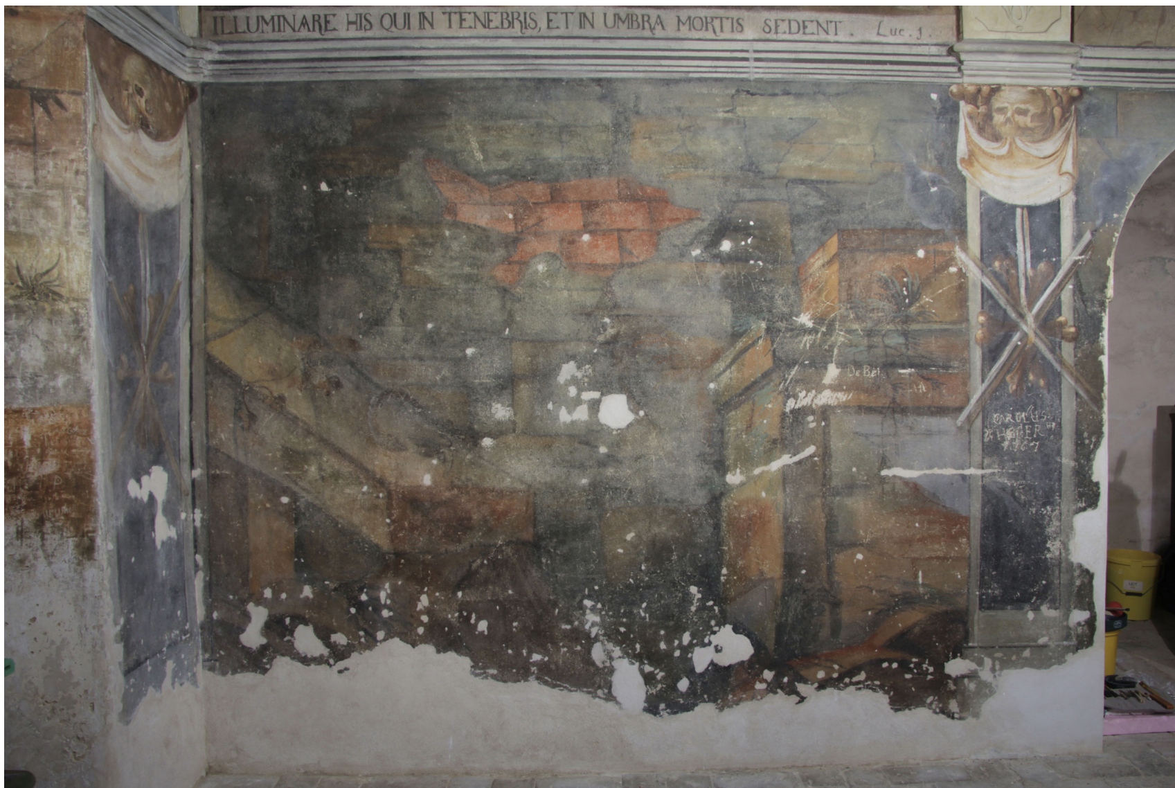
Obr. 97: JV stěna: celkový po- hled na dolní část výmalby. Stav po čištění a tmelení.
