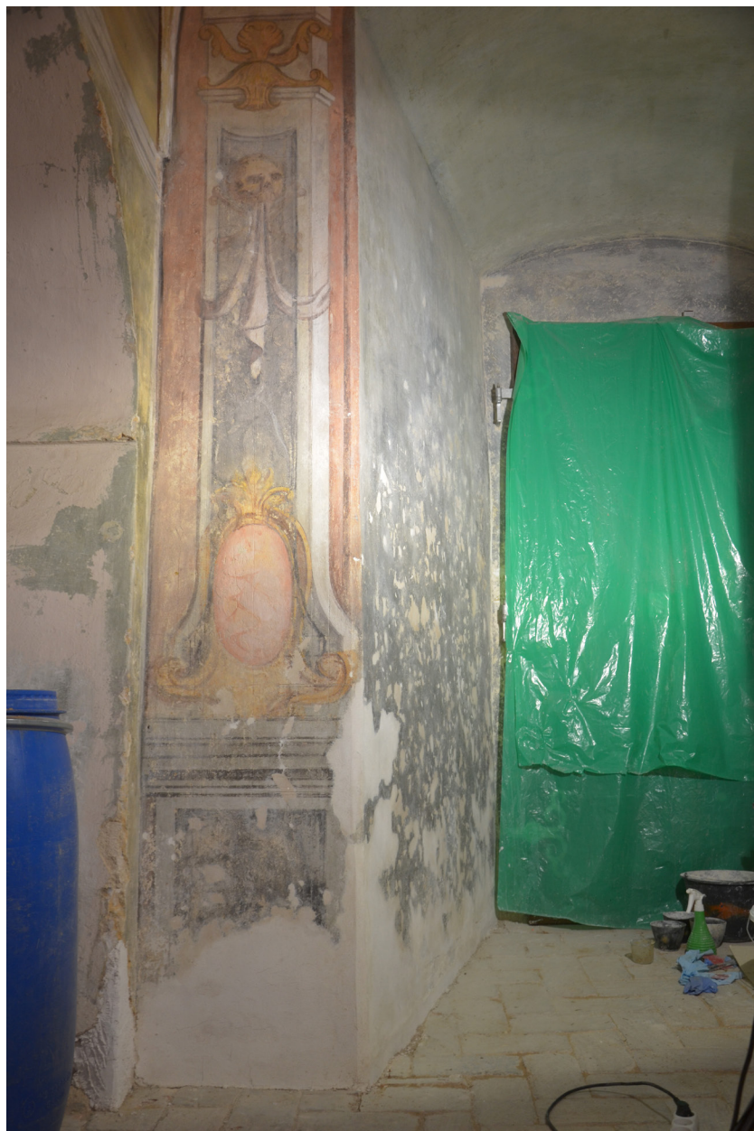
Obr. 106: JZ stěna: pravý malovaný pilastr. Stav v průběhu tmelení.
