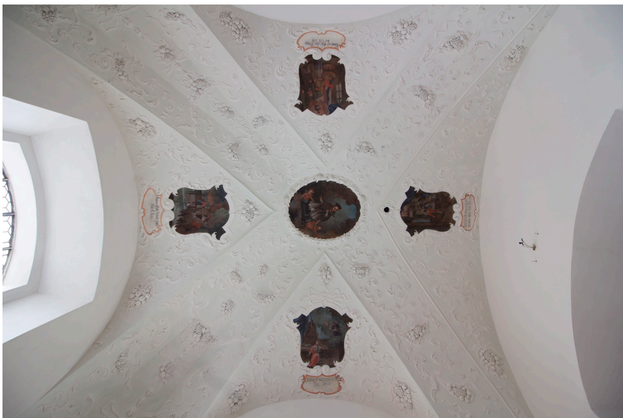
Obr. 65: Celkový pohled na strop v severní sakristii. Stav po restaurování.
