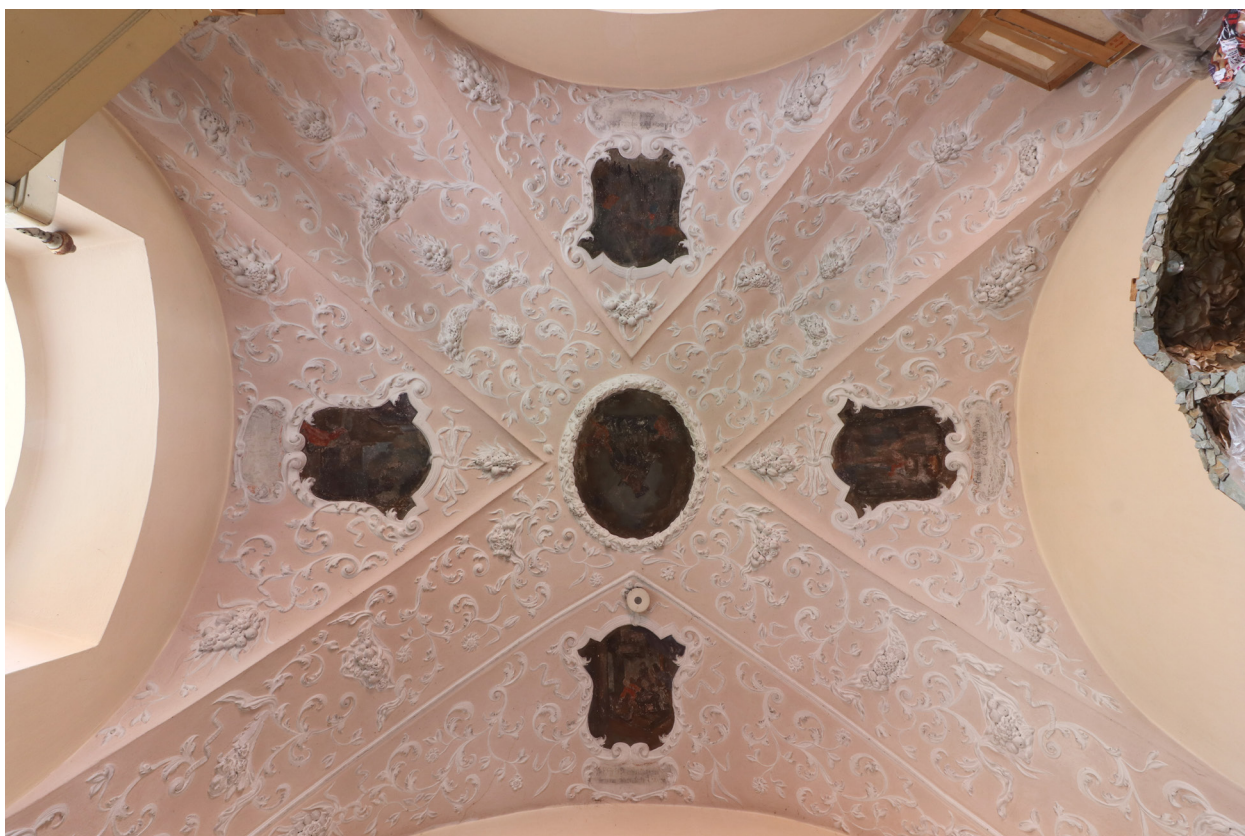
Obr. 01: Celkový pohled na strop v severní sakristii. Stav před restaurováním.
