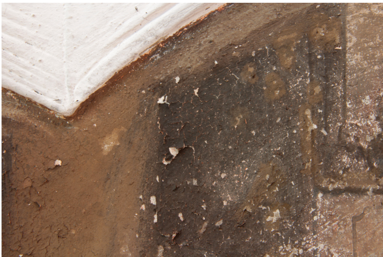
Obr. 19: Detail postav ve výjevu Vyzvednutí ostatků Jana Nepomuckého . Stav před restaurováním. Snímek dokumentuje druhotnou přemalbu v oblasti poškozené ztrátou původní barevné vrstvy.
